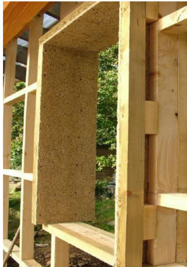
Hemp Cottage - Controtelaio in lana di roccia mineralizzata di una finestra
