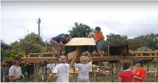
*Sopra: la posa delle costole che compongono il solaio contro terra*
