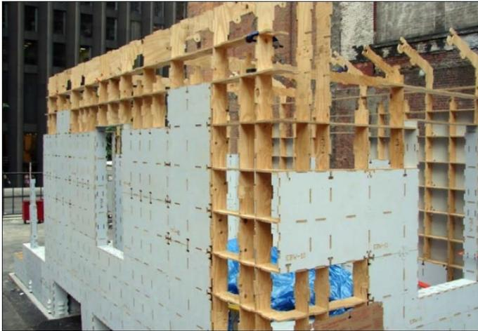
*Le immagini mostrano da punti di vista diversi la struttura delle pareti, in via di rivestimento, e l'inizio di costruzione della copertura.*
