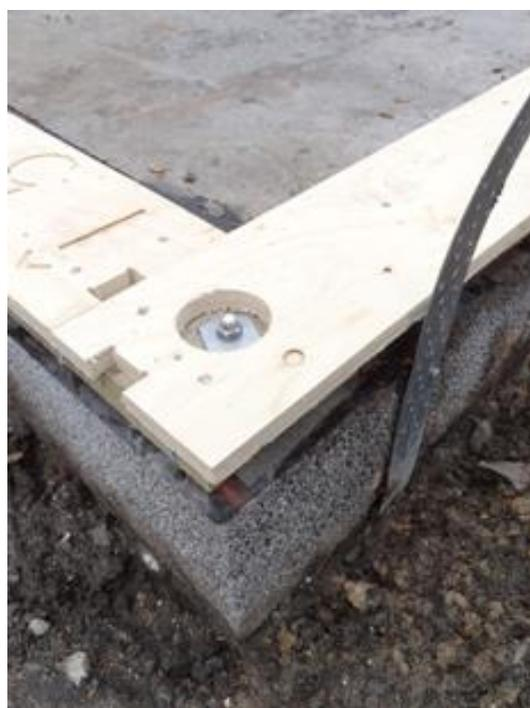
*A sinistra: sopra un solaio contro terra posato su fondazioni a micropali. Sotto i lavori d'isolamento di una fondazione a travi. A destra: una fondazione a platea su cui è stata posata una radice in compensato su cui verranno fissate le scatole della parete.*
