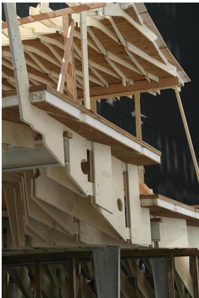
La struttura così creata è quindi in grado di resistere a carichi notevoli, tuttavia, a causa della sua esilità e leggerezza, risulta essere anche estremamente instabile e necessita dunque di ulteriori irrigidimenti prima di poter svolgere il proprio compito strutturale al massimo delle capacità. Le costole definiscono dunque la struttura ma non sarebbero complete senza un rivestimento, che come una sovrastruttura, sia in grado di tenerle fisse e stabili al loro posto, non solo in risposta ai
