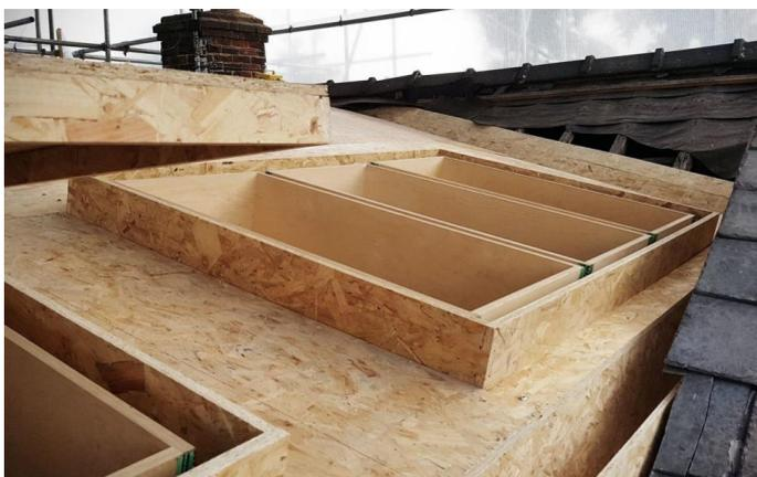
*A lato: Il dettaglio della copertura, ricoperta di OSB dopo aver posato un isolante a pannelli rigidi.*
