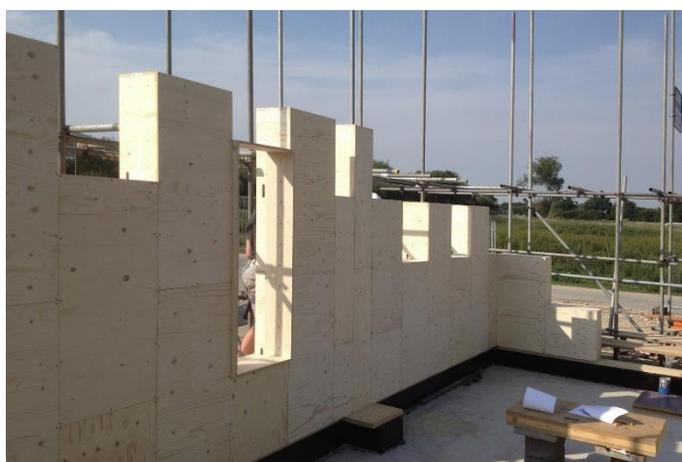
Gli elementi arrivano in cantiere già tagliati e in comodi kit di montaggio. Si procede subito con la prima operazione da compiere, ovvero l'assemblaggio delle scatole, che avviene tramite semplici incastri e connettori standard, e che prevede il solo uso di un martello di gomma e un avvitatore elettrico. L'assemblaggio di ogni scatola richiede circa dieci minuti di lavoro.
