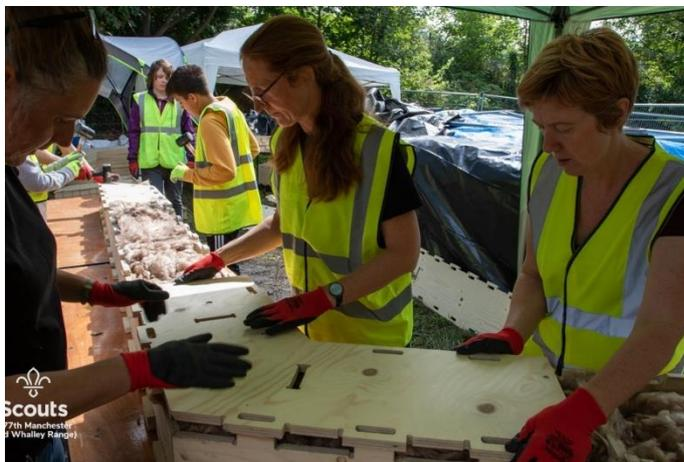
*A lato: l'assemblaggio di un portale, si può notare l'isolante collocato all'interno.*
