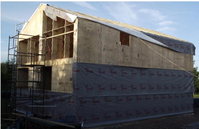
*A lato: il rivestimento con la membrana antivento. Sotto: la posa del rivestimento di facciata in legno.*
