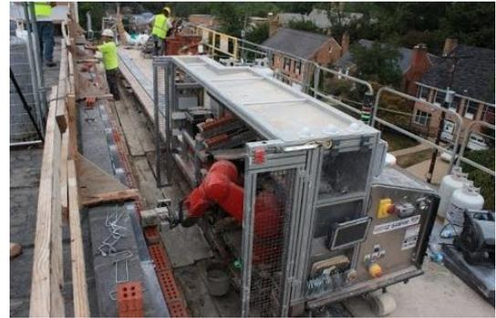
Sopra: il robot per la posa dei mattoni SAM100 di Construction robotics
