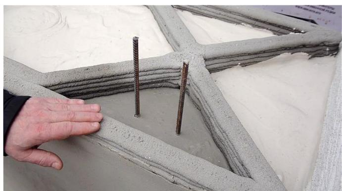
*A lato: si può notare come nell'edificio costruito da AMT-Specavia sia stato necessario inserire un'armatura di acciaio e procedere con un getto integrativo di cemento, effettuato manualmente.*
