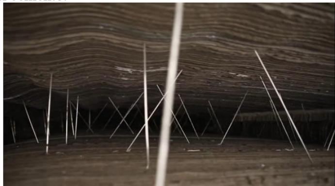
*A sinistra: nel muro stampato da Apis Cor si può notare il collegamento tra le pareti effettuato tramite linee curve di cemento
