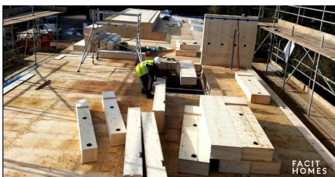
*A lato: le immagini della costruzione del secondo piano dell'abitazione tramite la posa delle scatole perimetrali.*
