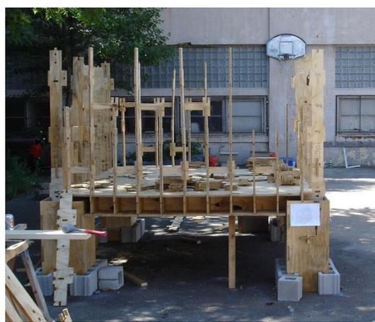
I muri sono costituiti da una struttura interna in montanti di compensato, il cui spessore, 20cm, definisce la larghezza del muro, che viene poi rivestito con i pannelli. L'attenta progettazione fa sì che i pannelli di rivestimento siano più piccoli di 1,8x1,2m e nessuno più grande di 2,5m, in modo che tutti i pannelli siano agilmente maneggiabili da una persona sola. Ogni componente è poi allineato a mano o con un piede di porco e incastrato utilizzando un martello.
