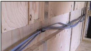
Esempio di alloggiamento sistema in compensato, Facit Homes
