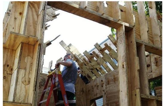
Il rifugio risultante è così un complesso sistema di componenti incastrati tra di loro, dove a forza tra gli elementi è data dall'incrocio di elementi e un assemblaggio capace di eliminare di auto-correggere eventuali errori. Tutto l'assemblaggio è estremamente rapido, nel caso ad esempio di un piccolo locale di 8mq ci sono volute solo 35 ore.
