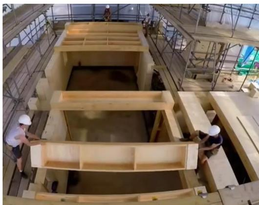
*Sopra: a sinistra, la struttura dei solai intermedi, rinforzata con travi. A destra, la posa delle scatole del solaio, aperte su lato superiore.*
