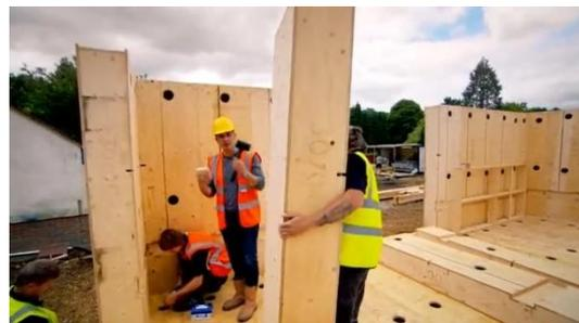
*Sopra: a destra, la posa delle scatole perimetrali. A sinistra, la posa degli elementi di collegamento tra parete e solaio e degli architravi.*
