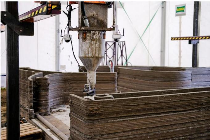
*Nelle immagini la stampa in sito, sotto una copertura temporanea, dell'edificio, e la struttura finita.*
