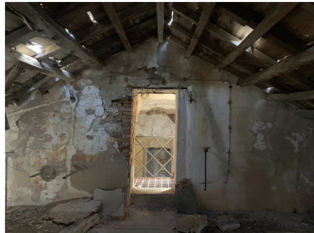
Fig.56 Vista della parete sud del sotto tetto con l'apertura e la scala di ghisa (fonte: foto dell'autore).
