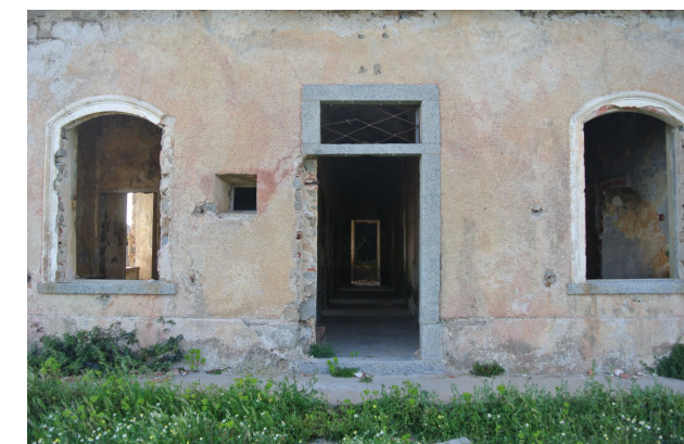
Fig.20 Facciata principale (Fonte: https://www.sardegnaabbandonata.it/semaforo-punta-falcone/ );
