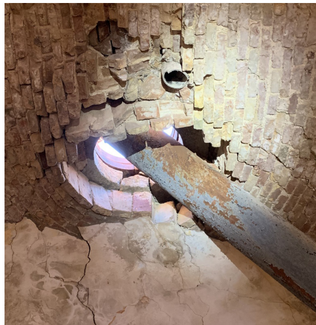
Fig.71 Il foro per il passaggio dell'antenna per le comunicazioni (Fonte: foto dell'autore).
