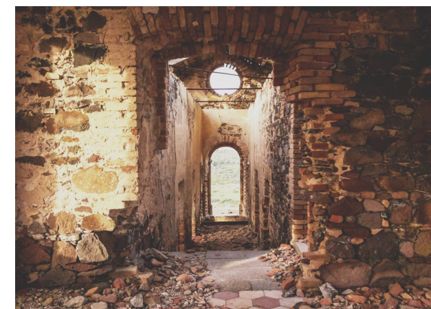
Fig. 31 Corridoio interno del semaforo di Capo Sperone. (Fonte: Sardiniaurbex.com)
