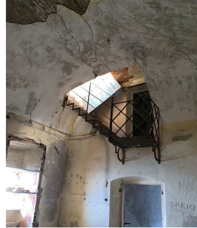
Fig.57 La scala di ghisa per il raggiungimeto della torre (fonte: foto dell'autore).
