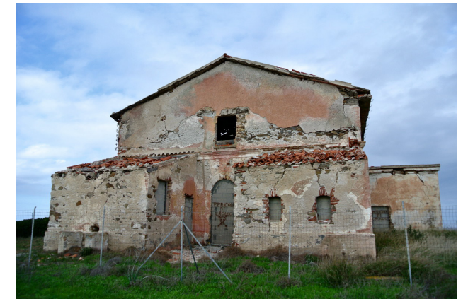
Fig.14 Facciata principale del semaforo (Fonte: www.sardegnaabbandonata.com)
