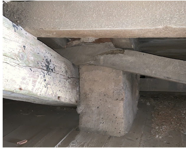
Fig.59 La canna fumaria del forno visibile dal sotto tetto (fonte: foto dell'autore).
