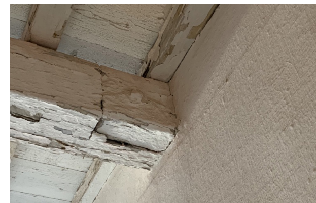
Fig.69 Giunzione nella catena (Fonte: foto dell'autore).
