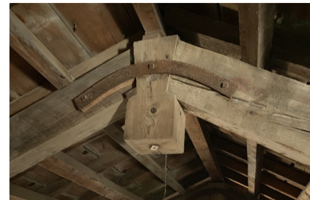
Fig.68 Nodo puntone-puntone (Fonte: foto dell'autore);
