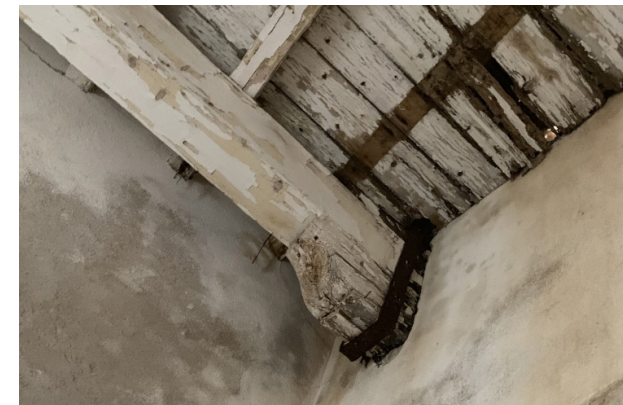
Fig.67 Nodo puntone-catena (Fonte: foto dell'autore);
