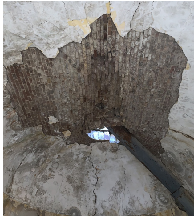
Fig.70 Volta dell'ufficio telegrafico in cui sono visibili alcuni filari di mattoni in seguito al distacco dell'intonaco (Fonte: foto dell'autore).
