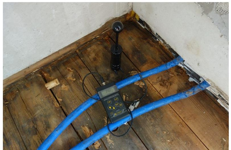
*Struttura lignea di pavimento fortemente compromessa a causa di una marcescenza diffusa a causa degli attacchi impiantistici che hanno causato presenza di umidità assorbita successivamente dal legno: fase di misurazione del livello di umidità presente – fotografie fornite dal professionista incaricato dei lavori, l'ingegner Franco Piva di Ergodomus*
