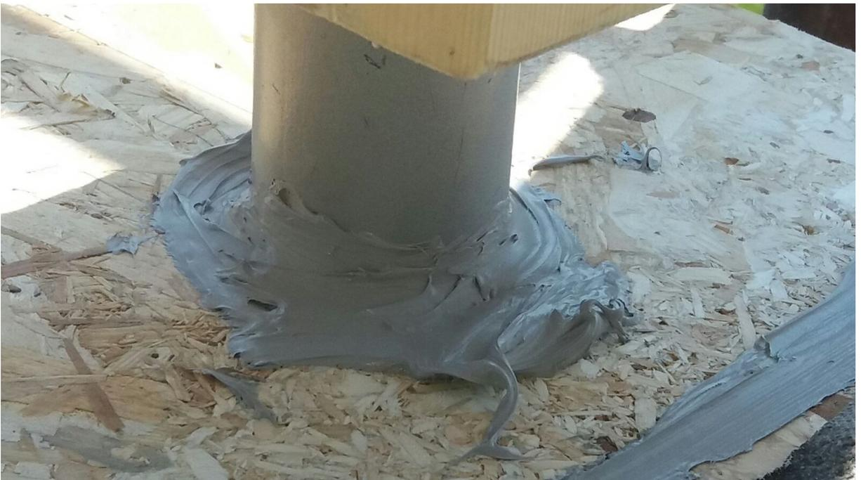
*Particolari che mostrano la risoluzione del problema del pilastro poggiante sul piano del terrazzo tramite inserimento di pistone metallico – fotografie fornite dal professionista incaricato dei lavori, l'architetto Giampiero Cavallo*
