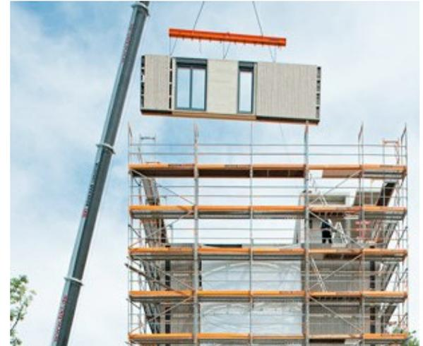
*Balcone dell'edificio, interno dell'edificio dal quale si scorge parzialmente il materiale ligneo e fase di cantiere con l'installazione della facciata prefabbricata*
