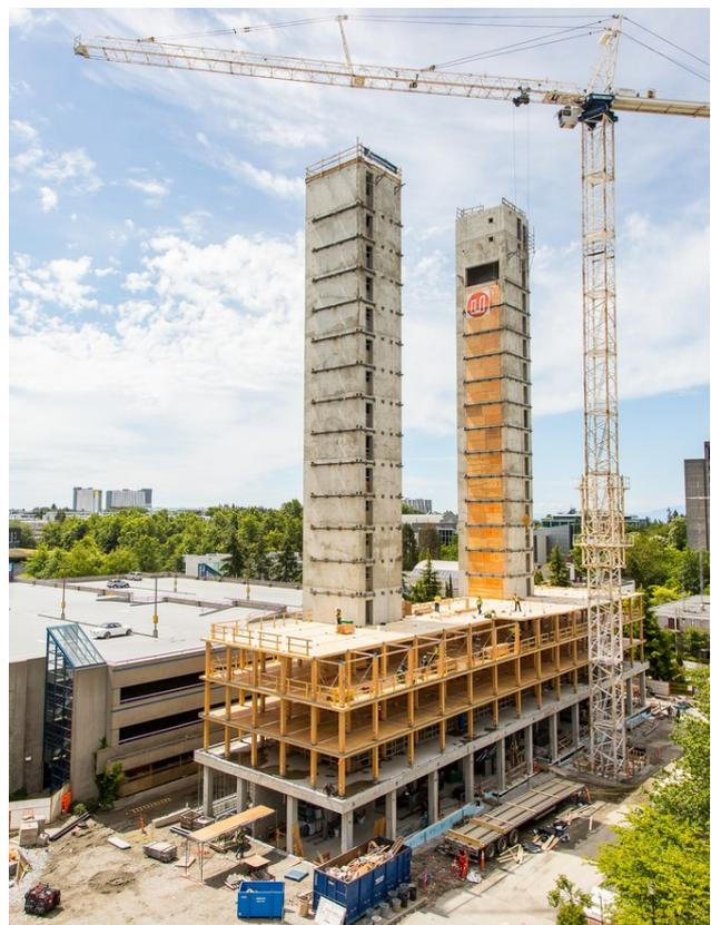
*Esterno dell'edificio e fase di cantiere che mostra la struttura lignea e i nuclei in calcestruzzo*
