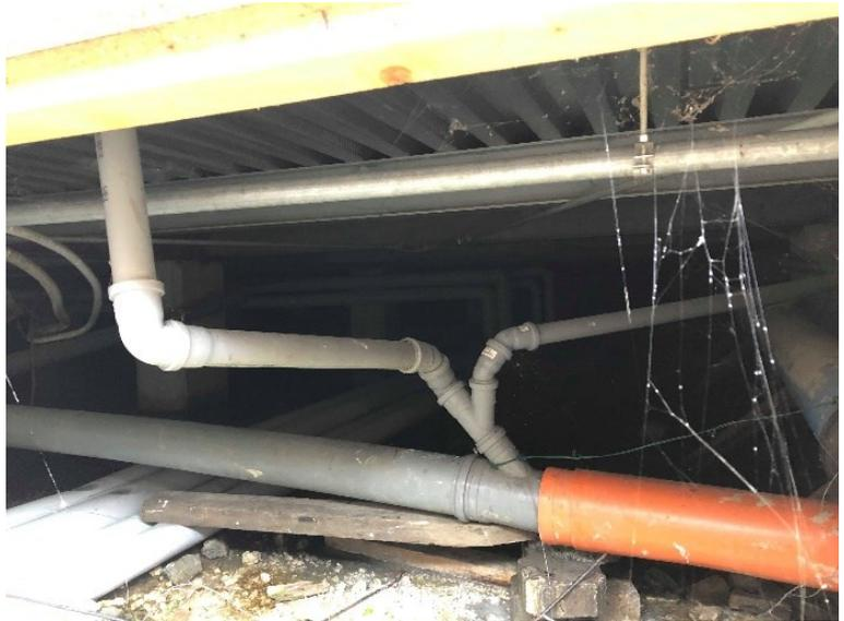
*Particolari dell'attacco a terra dell'edificio che si osserva essere completamente distaccato dal terreno: è stato creato un'intercapedine di circa cinquanta centimetri nel quale passano le tubazioni ma che permette alla base dell'edificio di essere sollevato dal terreno.*
