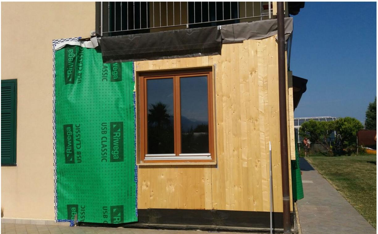
*Posizionamento, in seguito alla sostituzione della parete la cui durabilità era stata intaccata, del serramento messo in opera correttamente: si osserva alla base della parete la guaina risvoltata e nella zona superiore l'impermeabilizzazione del terrazzo al primo piano - fotografie fornite dal professionista incaricato dei lavori, l'architetto Giampiero Cavallo*
