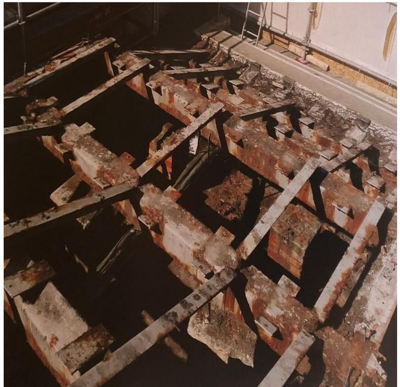
*Particolari del degrado del Ponte dell'Accademia a Venezia al momento dell'intervento di restauro del 2017 in cui si osserva il degrado e la durabilità compromessa del legno e della struttura secondaria del ponte e lo stato di fatto delle rampe di percorrenza del ponte, tutti elementi sui quali sono stati svolti gli interventi di restauro e di consolidamento – fonte: Il Ponte dell'Accademia permanenza del provvisorio, Franco Laner, 2018*
