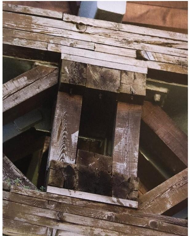
*Situazione del Ponte dell'Accademia nel 2011 e nel 2012: il degrado del legno è ormai insostenibile con la completa assenza di una manutenzione del materiale ligneo che risulta a contatto con il materiale metallico ossidato e oggetto di applicazioni di elementi da parte di agenti antropici che non supportano la durabilità del legno - fonte: Il Ponte dell'Accademia permanenza del provvisorio, Franco Laner, 2018*
