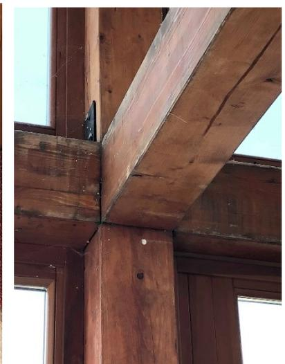
*Particolari della facciata in cui il legno del rivestimento in doghe, in parte posate scorrettamente, ha la superficie degradata - Dettagli delle connessioni strutturali lignei che, a causa del ponte termico dovuto alla vicinanza del nodo alla chiusura trasparente, ha una colorazione anomala e l'attacco dell'elemento verticale al pavimento risulta essere non progettato ed eseguito con precisione visto il sistema improvvisato in fase di cantierizzazione – Fotografie degli autori*
