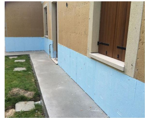
*Intervento di risanamento e consolidamento della base dell'edificio ligneo tramite l'eliminazione della porzione ammalorata e sostituzione con inserimento di cordolino in calcestruzzo – fotografie fornite dal professionista incaricato dei lavori, l'ingegner Alessandro Zerbetto di Legno Smart srl*
