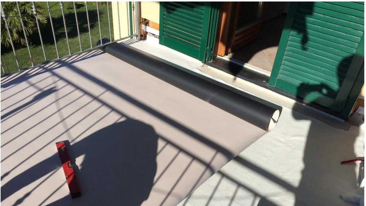
*Particolari delle fasi di intervento conseguente allo sviluppo del degrado con eliminazione del rivestimento a cappotto esterno dalle pareti dell'edificio e rifacimento del terrazzo posto al primo piano dell'edificio sul quale poggia il pilastro oggetto di consolidamento alla base - fotografie fornite dal professionista incaricato dei lavori, l'architetto Giampiero Cavallo*
