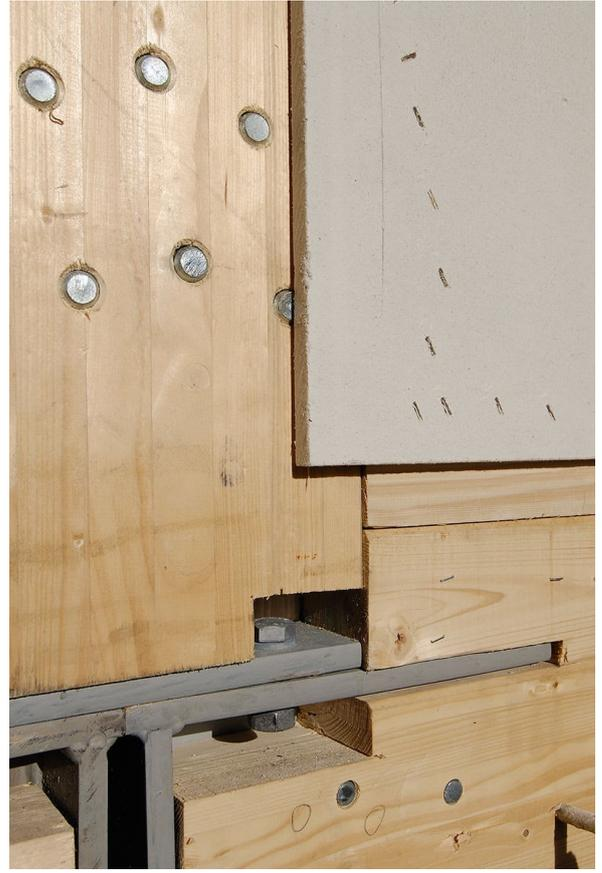
*Fase di cantierizzazione dell'edificio durante la quale si osserva la struttura lignea successivamente rivestita ed intonacata ed il posizionamento e l'assemblaggio degli elementi con inserimento di connessioni metalliche*
