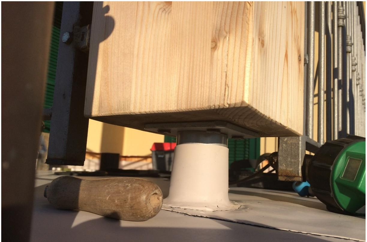
*Particolari delle fasi di intervento sul nodo della base del pilastro con la risoluzione del problema dell'attacco tra il pilastro e il piano del terrazzo tramite l'inserimento di una connessione metallica protetta dall'umidità che potrebbe crearsi alla base del pilastro di legno – fotografie fornite dal professionista incaricato dei lavori, l'architetto Giampiero Cavallo*
