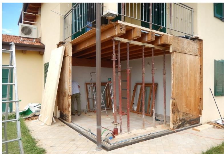
*Edificio con una struttura completamente degradata in seguito all'eliminazione del rivestimento a cappotto dell'edificio che nascondeva una situazione di durabilità compromessa già ad uno stato piuttosto avanzato – fotografie fornite dal professionista incaricato dei lavori, l'architetto Giampiero Cavallo*
