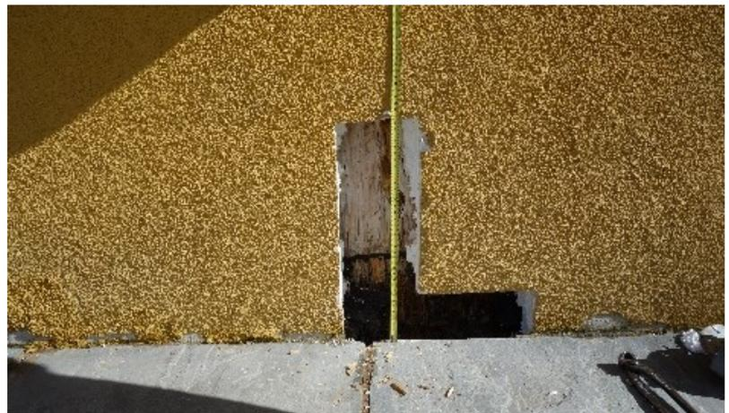
*Porzioni di partizione verticale esterna cappottata che ricopre la struttura dell'edificio in legno con tecnologia X-LAM attraverso le quali si osserva che eliminando la stratigrafia più esterna della parete dell'edificio che consiste nel cappotto dell'edificio, la struttura sottostante in legno risulta colpita da una marcescenza diffusa nel nodo dell'attacco a terra – fotografie fornite dal professionista incaricato dei lavori, l'ingegner Franco Piva di Ergodomus*
