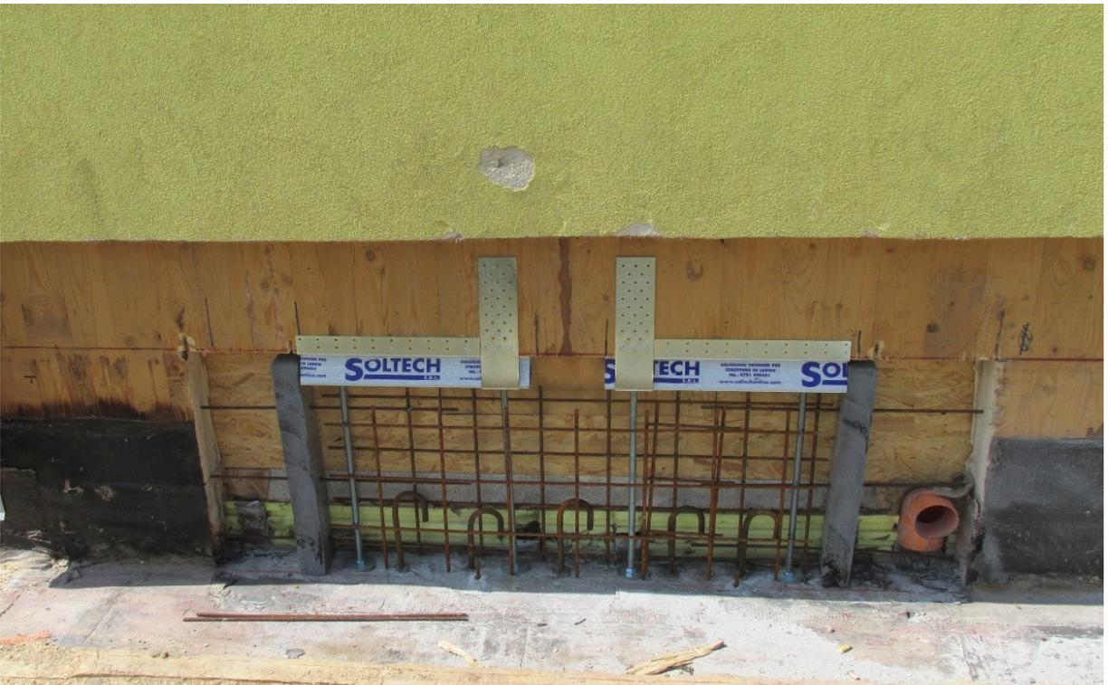
*Particolari dell'attacco a terra in seguito all'eliminazione della porzione di parete degradata per il successivo inserimento del cordolo ventilato metallico alla base della parete in X-LAM tra il cordolo in CLS e il legno - fotografie fornite dalla ditta Soltech incaricata dei lavori*
