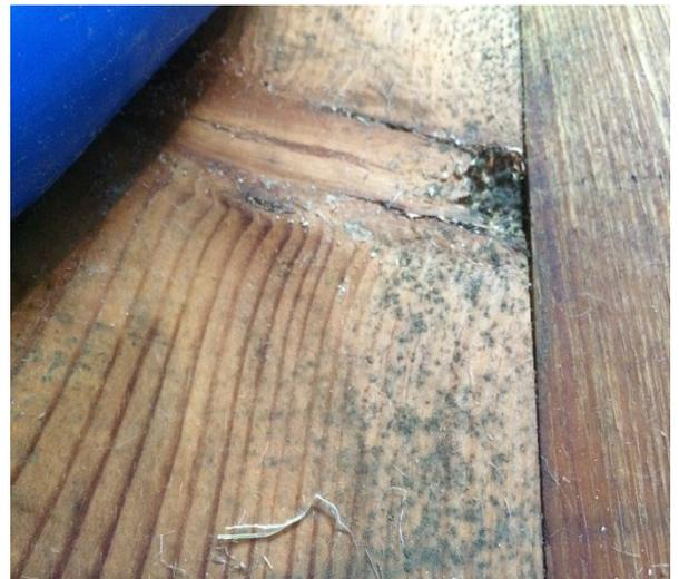
*Struttura lignea di pavimento e parete verticale fortemente compromessa a causa di una marcescenza diffusa a causa degli attacchi impiantistici che hanno causato presenza di umidità assorbita successivamente dal legno: i segni evidenti sulla struttura mostrano un attacco da parte di organismi lignivori con perdita di efficienza da parte del legno – fotografie fornite dal professionista incaricato dei lavori, l'ingegner Franco Piva di Ergodomus*
