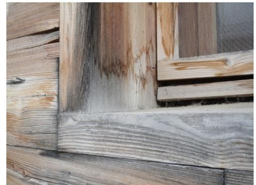
*Particolare di un infisso soggetto a decomposizione della lignina e a conseguente perdita della colorazione – fonte: LegnoArchitettura*
