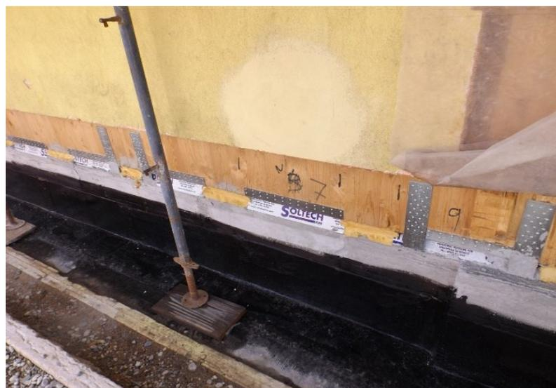
*Particolari dell'attacco a terra della parete che mostrano l'umidità causa di degrado della parete in X-LAM: eliminando lo stato più esterno del rivestimento della parete e la guaina bituminosa impermeabile il legno della parete risulta completamente marcio con la necessità di un risanamento della parete attraverso l'eliminazione della zona colpita da marcescenza - fotografie fornite dalla ditta Soltech incaricata dei lavori*
