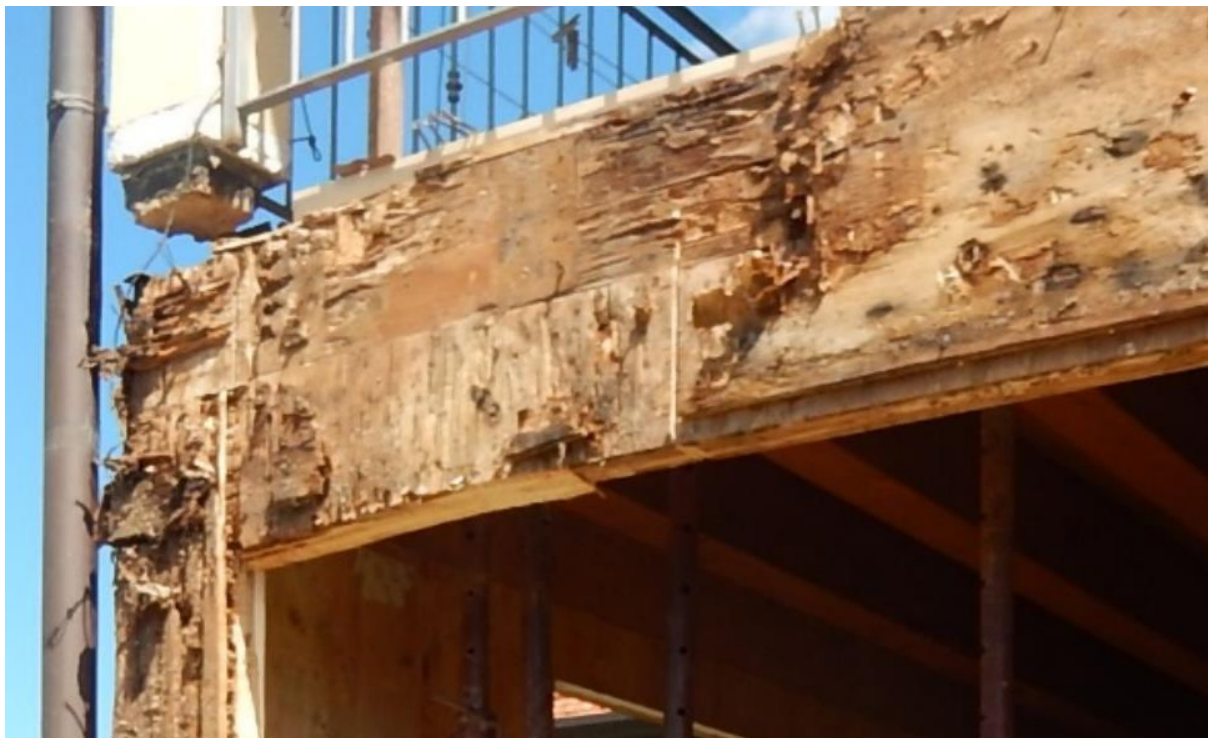
Particolare del pilastro appoggiato direttamente con la base al piano orizzontale del terrazzo, situazione ante intervento che ha scaturito l'insorgenza di problematiche legate alla durabilità – fotografie fornite dal professionista incaricato dei lavori, l'architetto Giampiero Cavallo ed elaborazione degli autori
