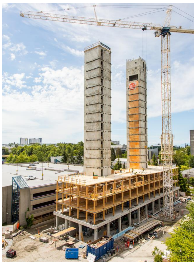
Esterno dell'edificio e fase di cantiere che mostra la struttura lignea e i nuclei in calcestruzzo
