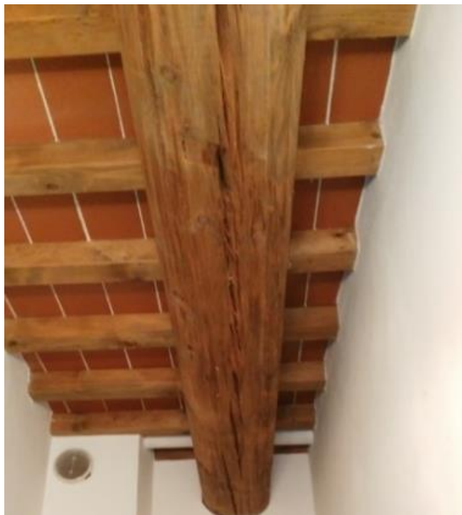
Trave soggetta a fessurazione dovuta al ritiro – fonte: Ingegneri.info
