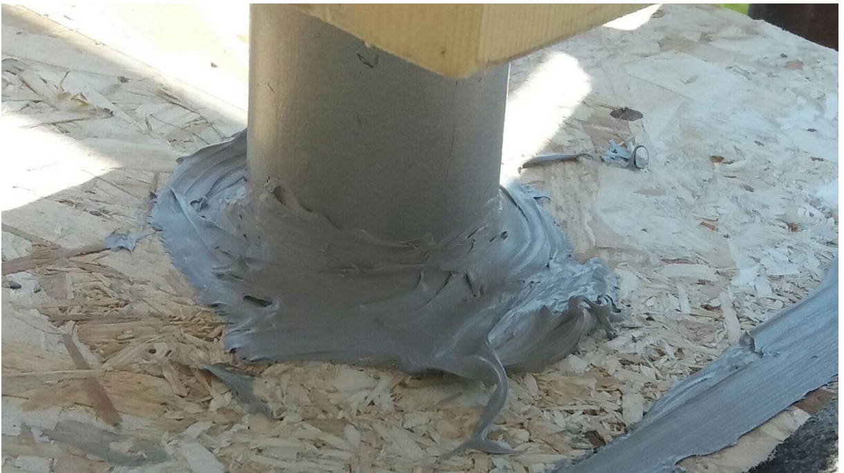
Particolari che mostrano la risoluzione del problema del pilastro poggianti sul piano del terrazzo tramite inserimento di pistone metallico – fotografie fornite dal professionista incaricato dei lavori, l'architetto Giampiero Cavallo
