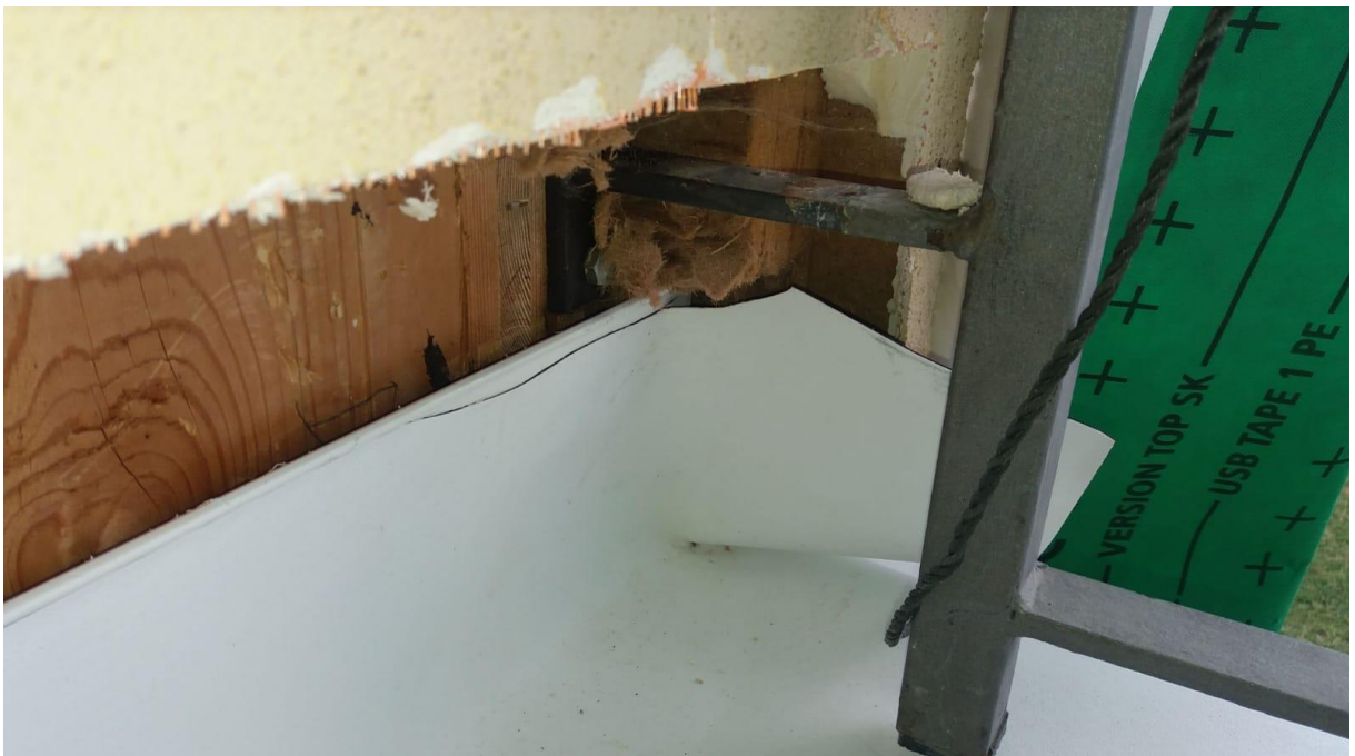
Particolari delle fasi di intervento conseguente allo sviluppo del degrado con eliminazione del rivestimento a cappotto esterno e rifacimento del terrazzo posto al primo piano con attenzione posta alla congiunzione tra la zona oggetto di risanamento e la porzione di edificio che non necessitava di intervento - fotografie fornite dal professionista incaricato dei lavori, l'architetto Giampiero Cavallo
