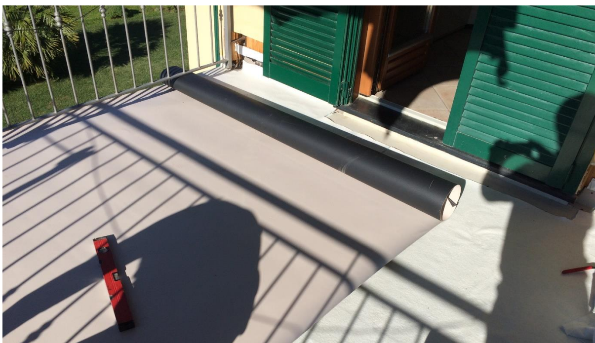
Particolari delle fasi di intervento conseguente allo sviluppo del degrado con eliminazione del rivestimento a cappotto esterno dalle pareti dell'edificio e rifacimento del terrazzo posto al primo piano dell'edificio sul quale poggia il pilastro oggetto di consolidamento alla base - fotografie fornite dal professionista incaricato dei lavori, l'architetto Giampiero Cavallo
