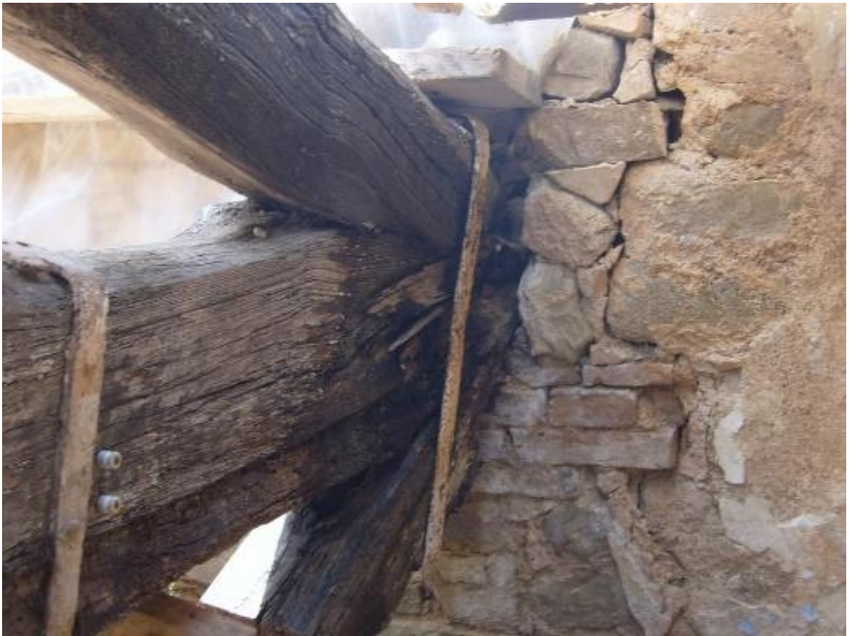
Nodo capriata-muro soggetto a degrado strutturale – fonte: Ingegneria e dintorni
