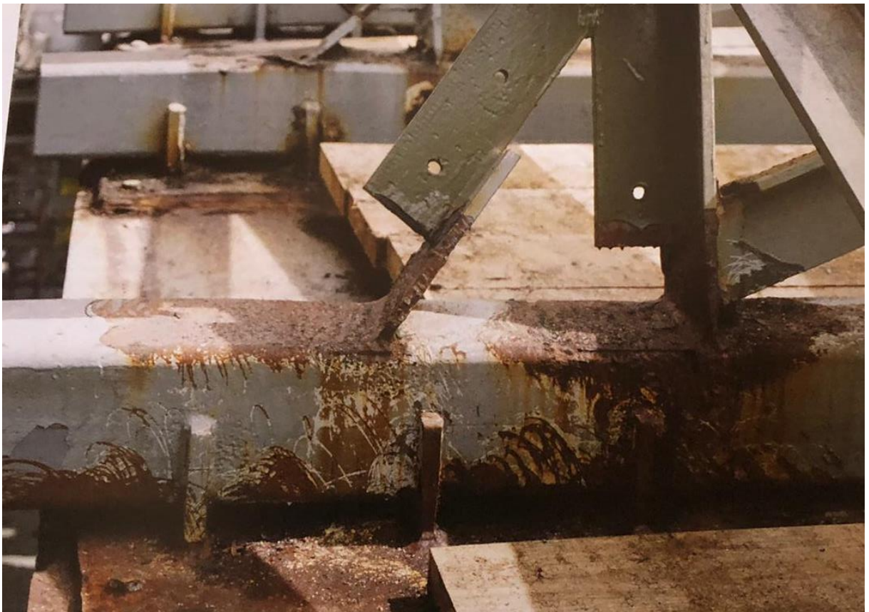
Degrado e ossidazione degli elementi metallici della struttura del Ponte dell'Accademia del secondo ordine - fonte: Il Ponte dell'Accademia permanenza del provvisorio, Franco Laner, 2018
