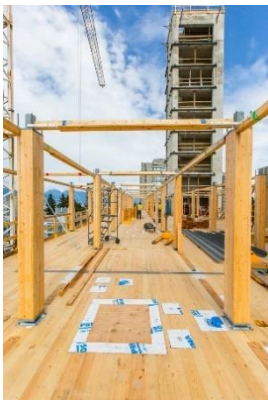
Fase di cantiere che mostra la struttura in legno, successivamente colmata dalla pannellatura visibile esternamente
