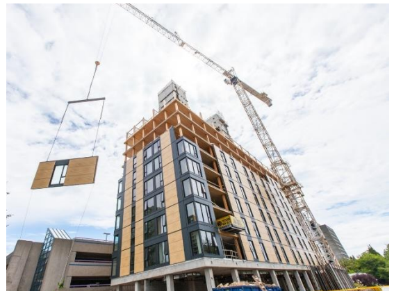
Dettaglio delle pannellature di rivestimento della facciata dell'edificio e fase di montaggio degli elementi prefabbricati
