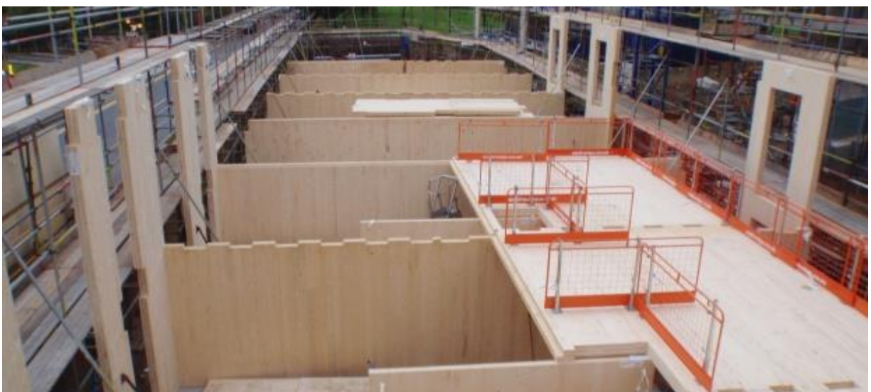
Fase di cantiere in cui si apprezza la struttura in legno, successivamente rivestita, non evidente in facciata
