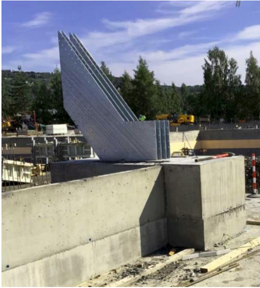
Connessione metallica ad alta capacità in acciaio scanalato che assicura una sicurezza strutturale in caso di incendio
