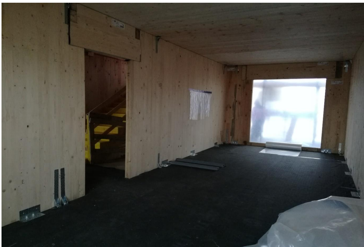
Fase di cantiere durante la quale umidità causata da abbondanti piogge sono entrate all'interno della struttura in fase di costruzione, successivamente per limitare i danni sono stati utilizzati teli per la protezione del cantiere - fotografie fornite dal professionista incaricato dei lavori, l'ingegnere Tania Pesando della ditta Proklima
