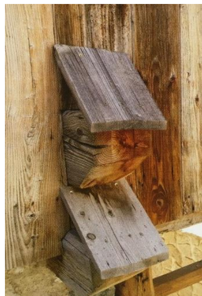
Elementi di sacrificio in larice a protezione dell'elemento ligneo
