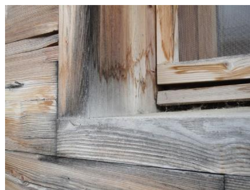
Particolare di un infisso soggetto a decomposizione della lignina e a conseguente perdita della colorazione – fonte: LegnoArchitettura
