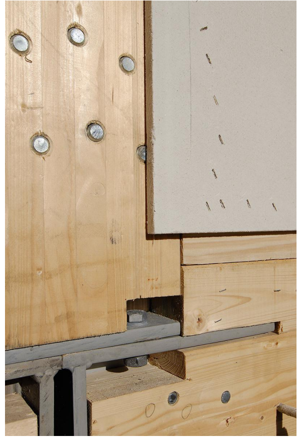
Fase di cantierizzazione dell'edificio durante la quale si osserva la struttura lignea successivamente rivestita ed intonacata ed il posizionamento e l'assemblaggio degli elementi con inserimento di connessioni metalliche
