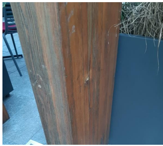
Elementi della struttura portante costituita da colonne, travi e pilastri in legno lamellare di larice levigato per una durabilità più elevata ma che comunque è stata intaccata a causa dell'esposizione agli agenti esterni – fotografie fornite dal professore Davide Maria Giachino
