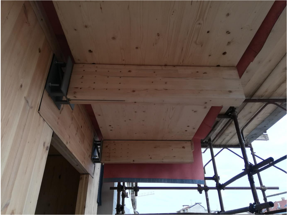
Soluzione di attacco del balcone connesso alla parete in X-LAM tramite la connessione del falso puntone – fotografie fornite dal professionista incaricato dei lavori, l'ingegnere Tania Pesando della ditta Proklima
