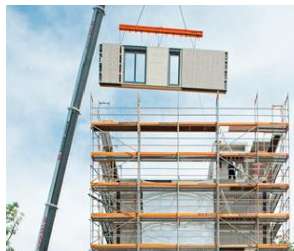
Balcone dell'edificio, interno dell'edificio dal quale si scorge parzialmente il materiale ligneo e fase di cantiere con l'installazione della facciata prefabbricata
