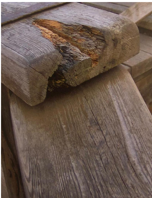
Situazione del Ponte dell'Accademia nel 2011 e nel 2012: il degrado del legno è ormai insostenibile con la completa assenza di una manutenzione del materiale ligneo che risulta a contatto con il materiale metallico ossidato e oggetto di applicazioni di elementi da parte di agenti antropici che non supportano la durabilità del legno - fonte: Il Ponte dell'Accademia permanenza del provvisorio, Franco Laner, 2018
