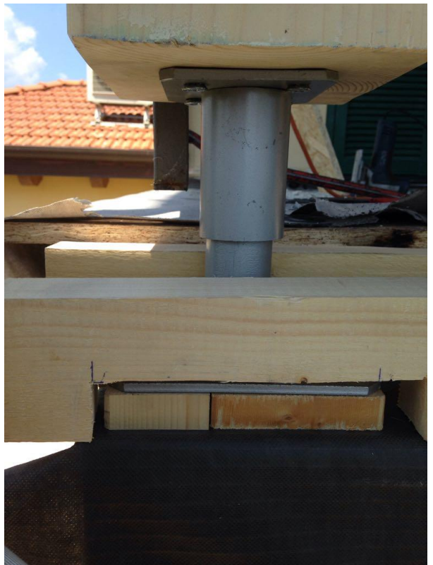
Particolari che mostrano le fasi di intervento alla base dell'elemento di pilastro colpito da degrado: la zona colpita da umidità e marcescenza è stata eliminata con la sostituzione della porzione di legno ammalorata mediante inserimento di un pistone metallico che non mette a contatto diretto il legno con il piano del terrazzo, in modo tale che eventuali ristagni e accumuli di acqua rigenerino fenomeni di marcescenza del legno – fotografie fornite dal professionista incaricato dei lavori, l'architetto Giampiero Cavallo
