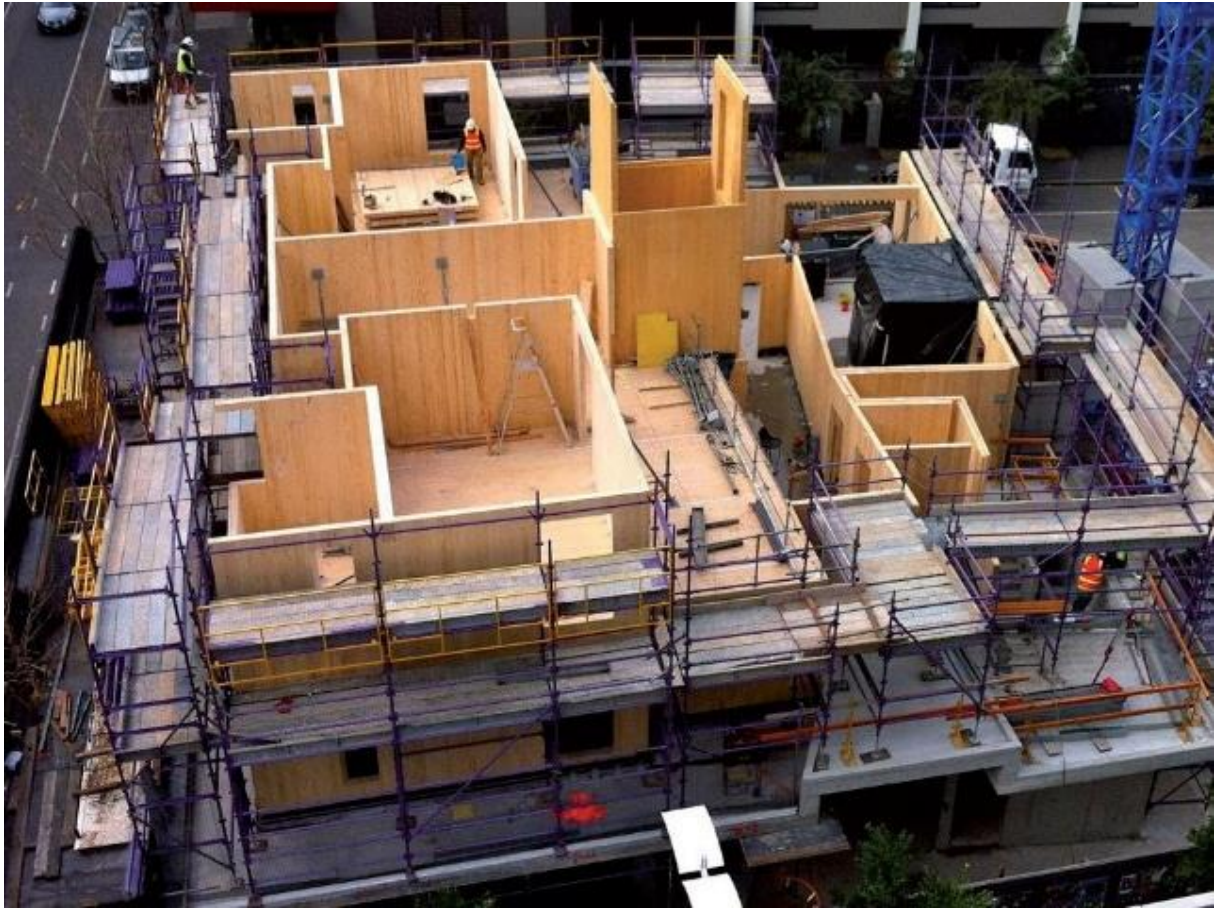
Fase di cantiere in cui si apprezza la struttura in legno, successivamente rivestita, non evidente in facciata
