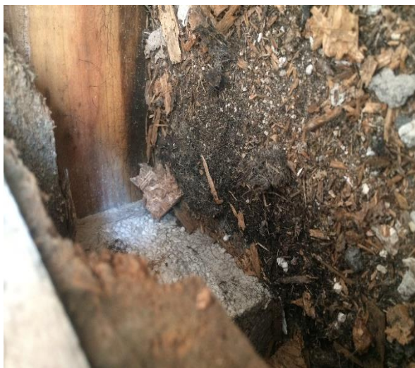
Struttura lignea di pavimento e parete verticale fortemente compromessa a causa di una marcescenza diffusa a causa degli attacchi impiantistici che hanno causato presenza di umidità assorbita successivamente dal legno: i segni evidenti sulla struttura mostrano un attacco da parte di organismi lignivori con perdita di efficienza da parte del legno – fotografie fornite dal professionista incaricato dei lavori, l'ingegner Franco Piva di Ergodomus
