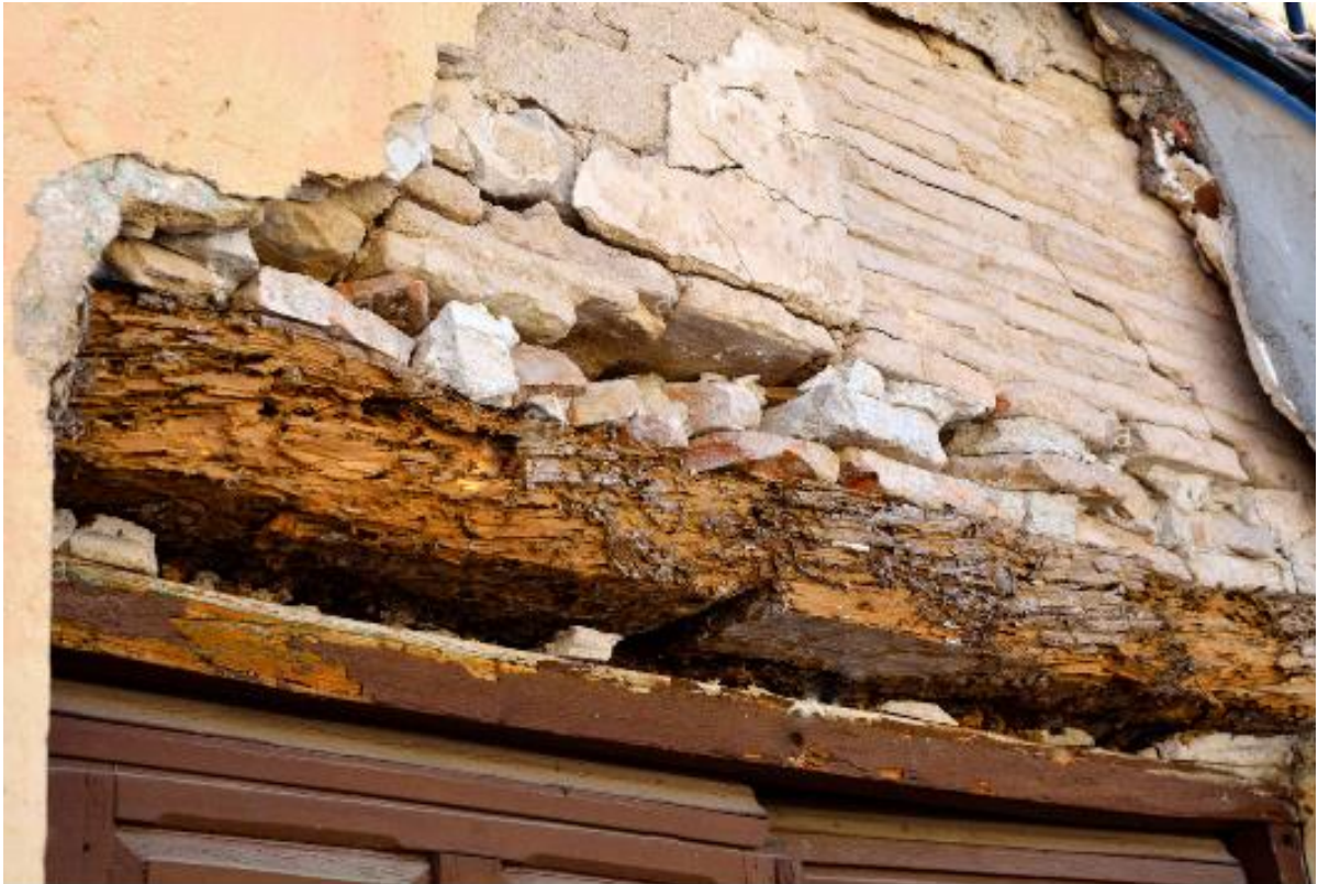
Degrado causato dall'umidità su un elemento di schermatura esterna con un degrado che si estende anche agli elementi dell'edificio a contatto con la zona direttamente attaccata dal degrado stesso, seppur si tratti di un materiale da costruzione differente – fonte: Progetto Biocasa
