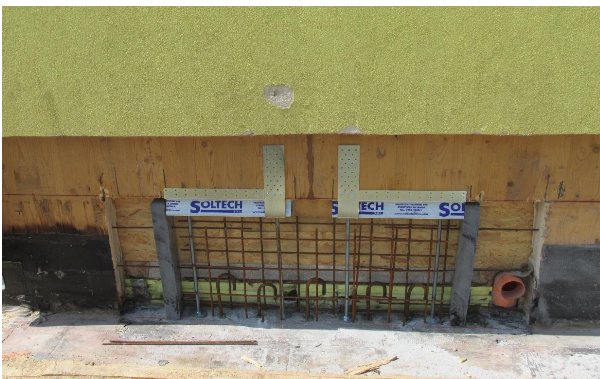
Particolari dell'attacco a terra in seguito all'eliminazione della porzione di parete degradata per il successivo inserimento del cordolo ventilato metallico alla base della parete in X-LAM tra il cordolo in CLS e il legno - fotografie fornite dalla ditta Soltech incaricata dei lavori
