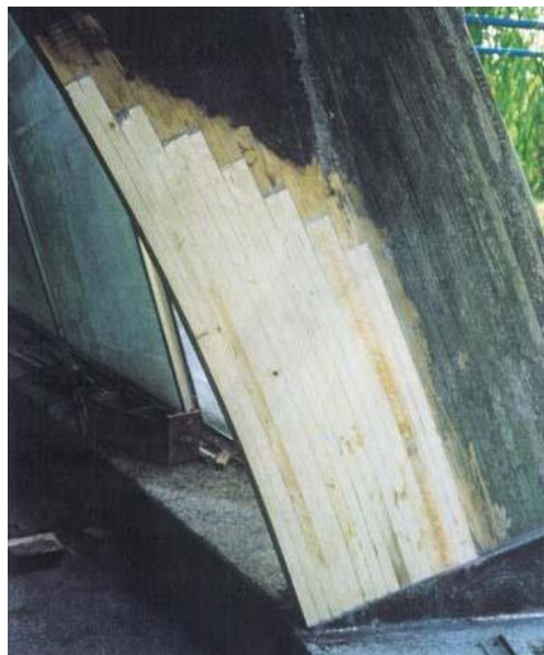
Elemento ligneo esposto all'azione dell'acqua e del sole con conseguente annerimento superficiale – fonte: LegoArchitettura
