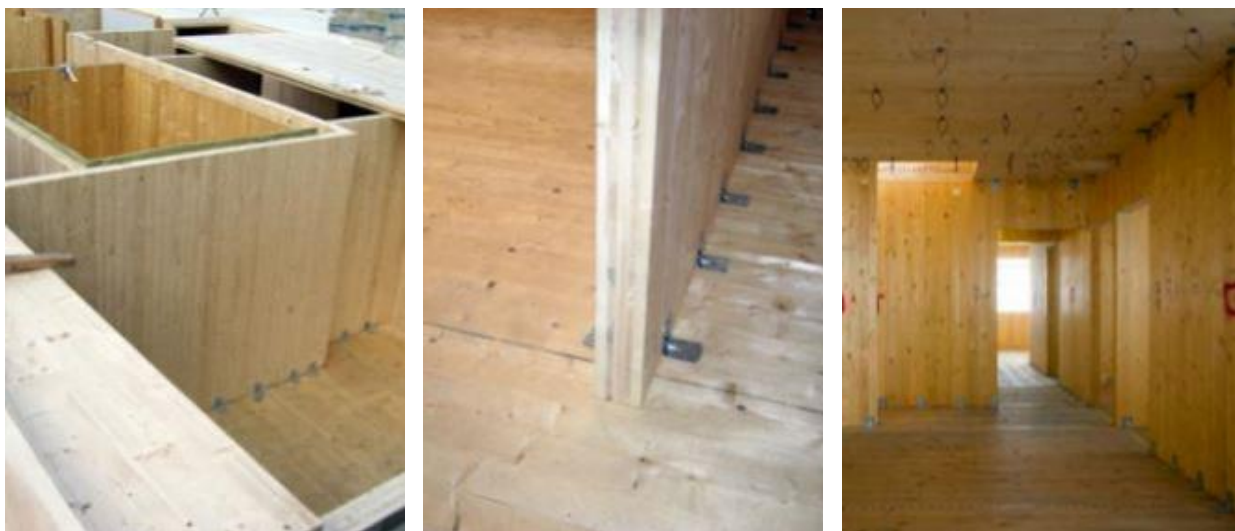
Fase di cantiere che mostra la struttura interna in legno e il metodo di connessione tra gli elementi
