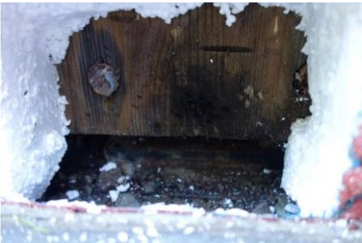
Il progetto errato del passaggio degli impianti peggiora la durabilità già compromessa della struttura, inoltre l'umidità causa l'ossidazione degli elementi metallici che subiscono una inefficienza funzionale – fotografie fornite dal professionista incaricato dei lavori, l'ingegner Franco Piva di Ergodomus
