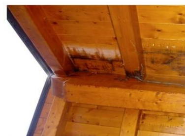
Attacco da muffa su superficie di copertura – fonte: Infobuild
