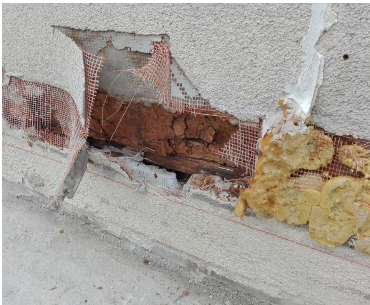
Il legno della struttura portante in legno a causa dell'umidità subisce uno sgretolamento e diminuzione della consistenza con ricadute sulla cappottatura esterna posta al di sopra degli elementi lignei – fotografie fornite dal professionista incaricato dei lavori, l'ingegner Alessandro Zerbetto di Legno Smart srl
