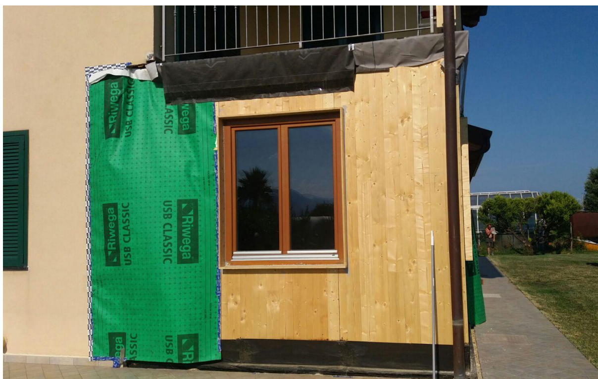
Posizionamento, in seguito alla sostituzione della parete la cui durabilità era stata intaccata, del serramento messo in opera correttamente: si osserva alla base della parete la guaina risvoltata e nella zona superiore l'impermeabilizzazione del terrazzo al primo piano - fotografie fornite dal professionista incaricato dei lavori, l'architetto Giampiero Cavallo
