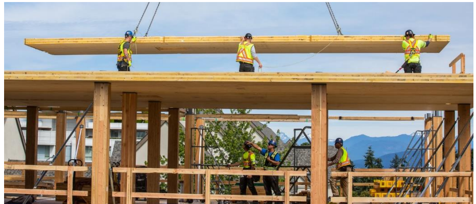
Fase di cantiere che mostra la struttura in legno, successivamente colmata dalla pannellatura visibile esternamente
