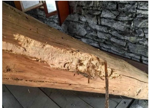
Sezione di trave ammalorata e conseguente perdita di prestanza strutturale localizzata a causa di attacco da insetti xilofagi – fonte: Disinfestazionetarli
