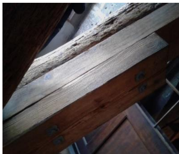
Applicazione del metodo dei fettoni – fonte: Infobuild
