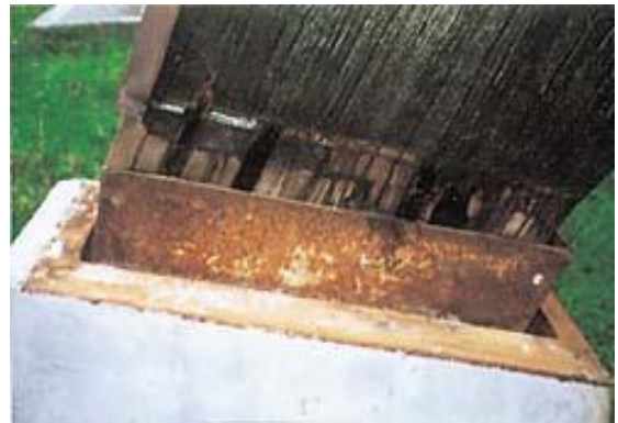
Particolare del bicchiere metallico che regge l'elemento strutturale soggetto al fenomeno di ossidazione – fonte: Doc Player
