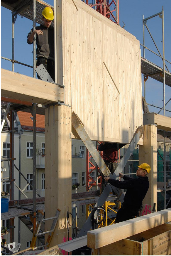
Fase di cantierizzazione dell'edificio durante la quale si osserva la struttura lignea successivamente rivestita ed intonacata ed il posizionamento e l'assemblaggio degli elementi con inserimento di connessioni metalliche
