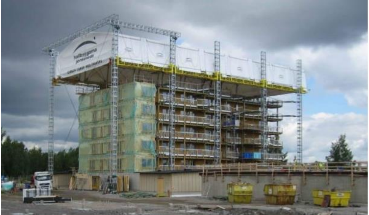
Fase di cantierizzazione durante la quale si osserva l'importanza del processo di controllo dell'umidità del manufatto ligneo tramite un sistema di protezione dagli agenti atmosferici mediante materiali impermeabili a copertura della struttura dell'edificio
