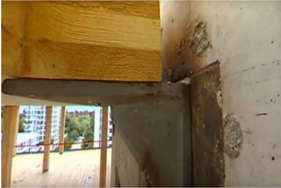
Connessione tra elemento ligneo orizzontale in X-LAM e nucleo centrale in calcestruzzo della struttura dell'edificio mediante sostegno metallico
