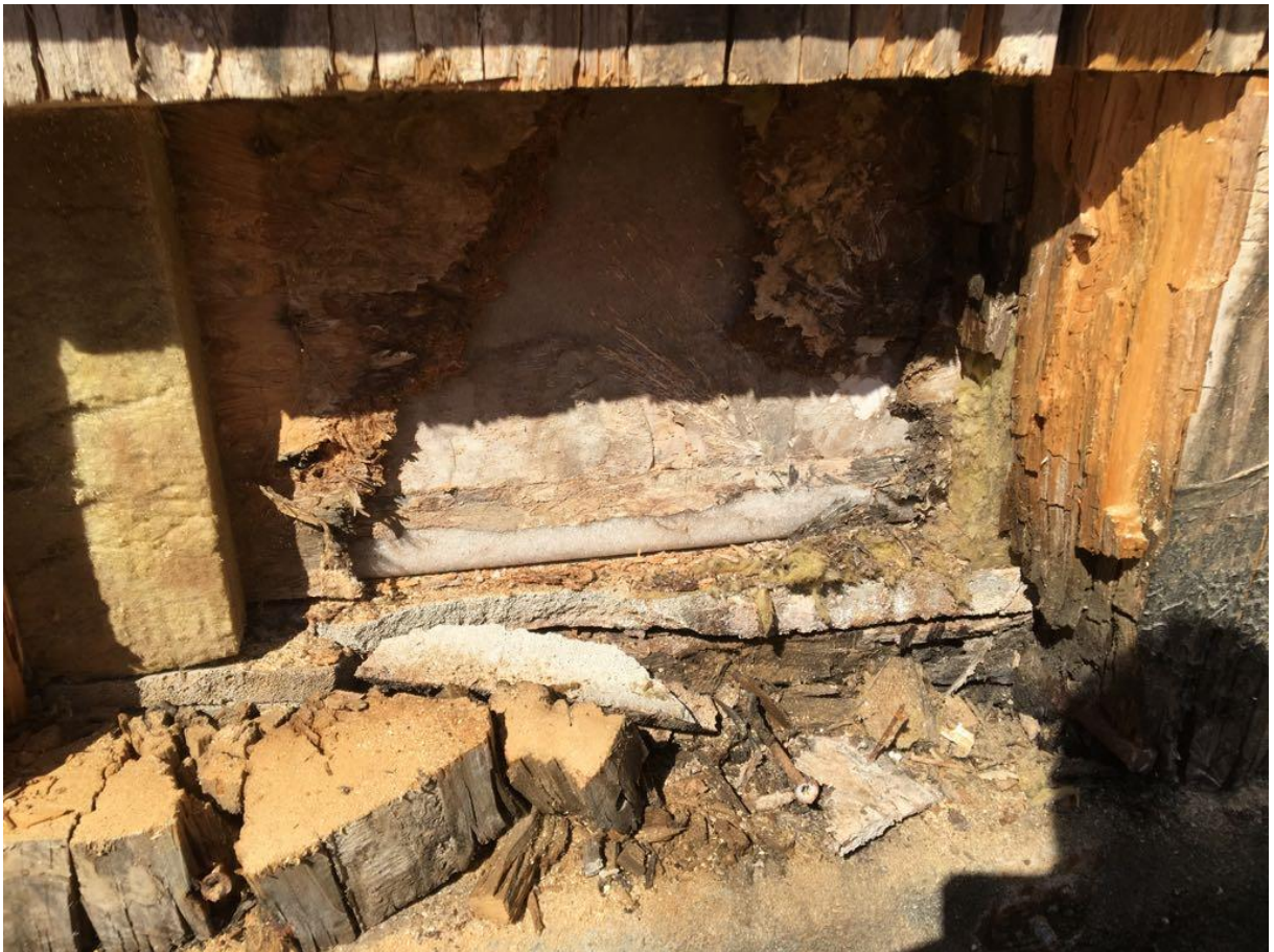
Struttura in legno colpita da marcescenza diffusa nel nodo dell'attacco a terra, degrado causato dall'umidità, che si è poi esteso in altezza lungo le pareti dell'edificio compromettendo la stabilità del manufatto – fotografie fornite dal professionista incaricato dei lavori, l'ingegner Franco Piva di Ergodomus
