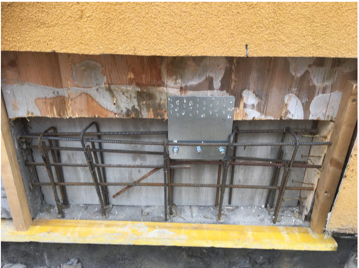
Alcune fasi di intervento consolidativo sulla struttura degradata con l'eliminazione della porzione di legno colpita da marcescenza e sostituzione della porzione ammalorata con inserimento di elementi di sostegno alla struttura esistente – fotografie fornite dal professionista incaricato dei lavori, l'ingegner Franco Piva di Ergodomus
