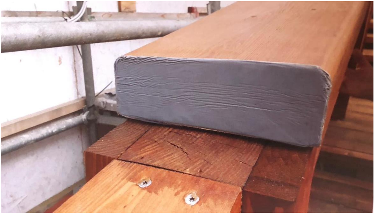
Giunto impermeabile tra gli elementi del parapetto del ponte fonte: Il Ponte dell'Accademia permanenza del provvisorio, Franco Laner, 2018
