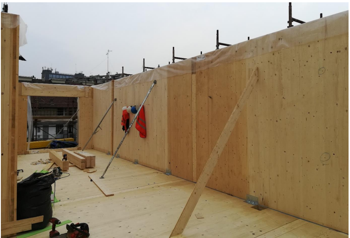
Fase di cantierizzazione nelle quali si osserva l'assemblaggio degli elementi lignei e l'organizzazione del cantiere - fotografie fornite dal professionista incaricato dei lavori, l'ingegnere Tania Pesando della ditta Proklima
