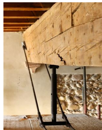
Rottura dell'elemento di trave con funzione strutturale – fonte: Ingegneri e dintorni
