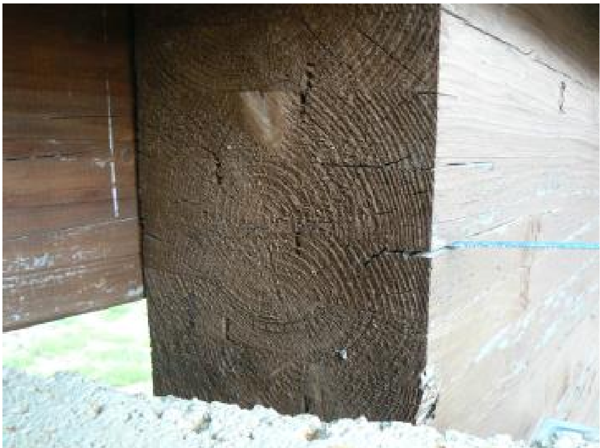
Effetto di delaminazione in un elemento di trave – fonte: Doc Player
