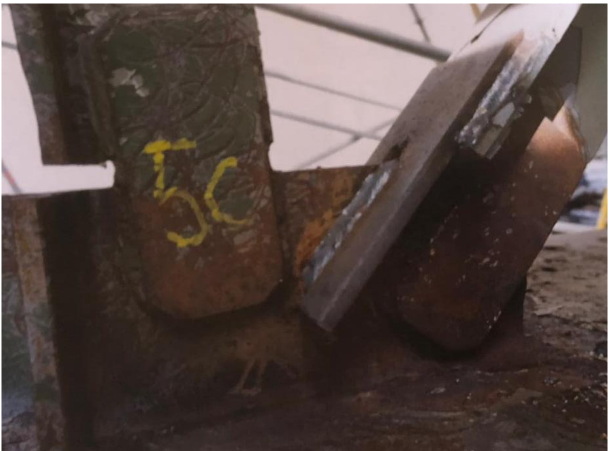
Le principali cause di degrado del Ponte dell'Accademia risiedono nella marcescenza degli elementi lignei e nell'ossidazione degli elementi metallici - fonte: Il Ponte dell'Accademia permanenza del provvisorio, Franco Laner, 2018
