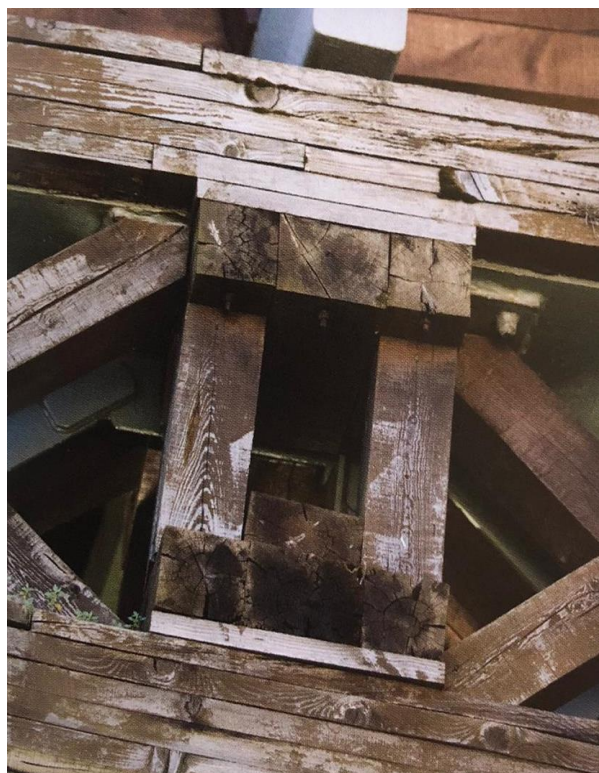
Situazione del Ponte dell'Accademia nel 2011 e nel 2012: il degrado del legno è ormai insostenibile con la completa assenza di una manutenzione del materiale ligneo che risulta a contatto con il materiale metallico ossidato e oggetto di applicazioni di elementi da parte di agenti antropici che non supportano la durabilità del legno - fonte: Il Ponte dell'Accademia permanenza del provvisorio, Franco Laner, 2018
