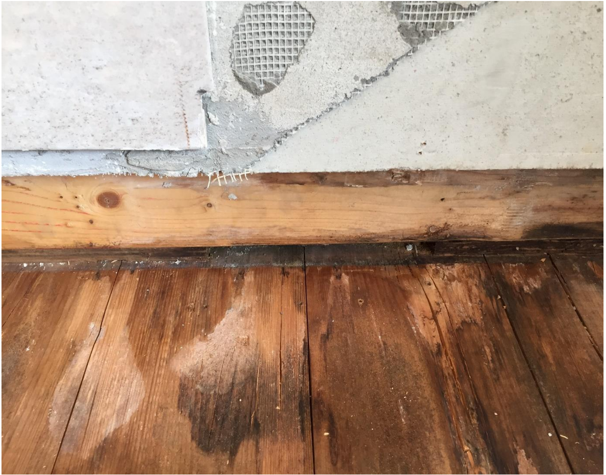
Struttura lignea di pavimento e parete verticale fortemente compromessa a causa di una marcescenza diffusa a causa degli attacchi impiantistici che hanno causato presenza di umidità assorbita successivamente dal legno – fotografie fornite dal professionista incaricato dei lavori, l'ingegner Franco Piva di Ergodomus
