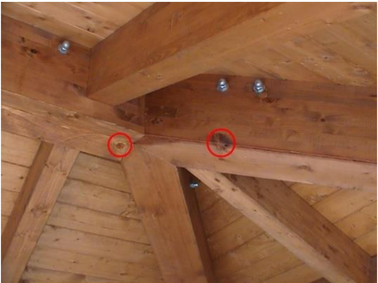
Struttura lignea di copertura con nodi ben in vista – Doc Player
