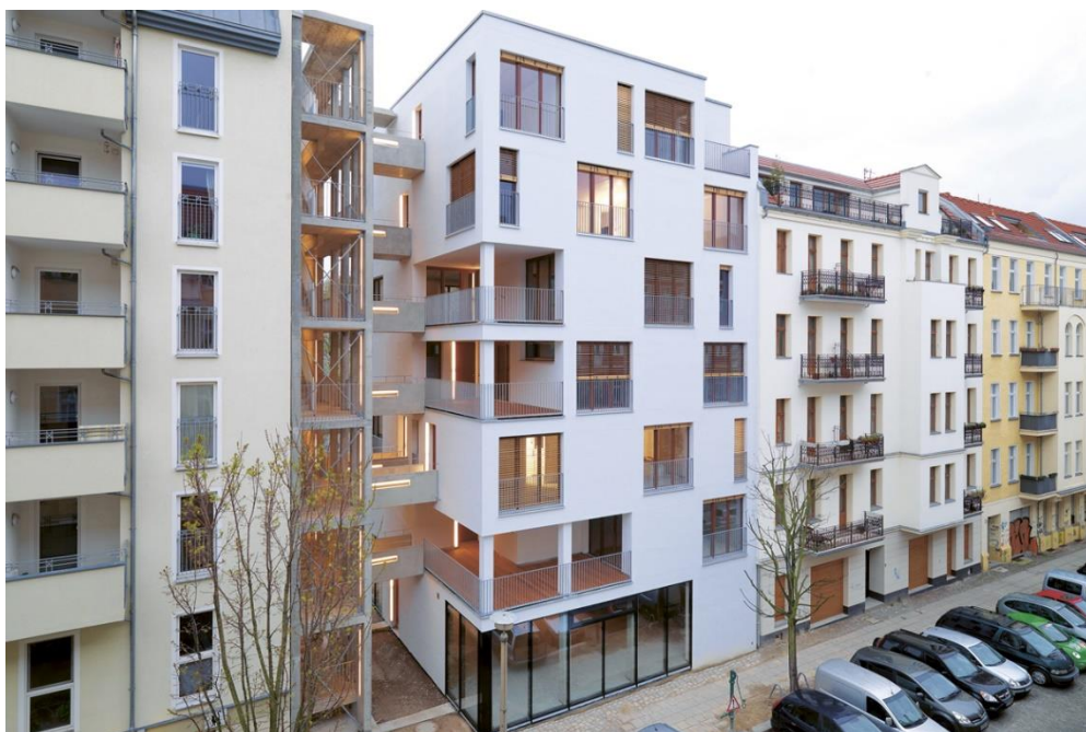
Esterno dell'edificio verso fronte strada con la particolare texture in facciata ricavata grazie al sistema a telaio
