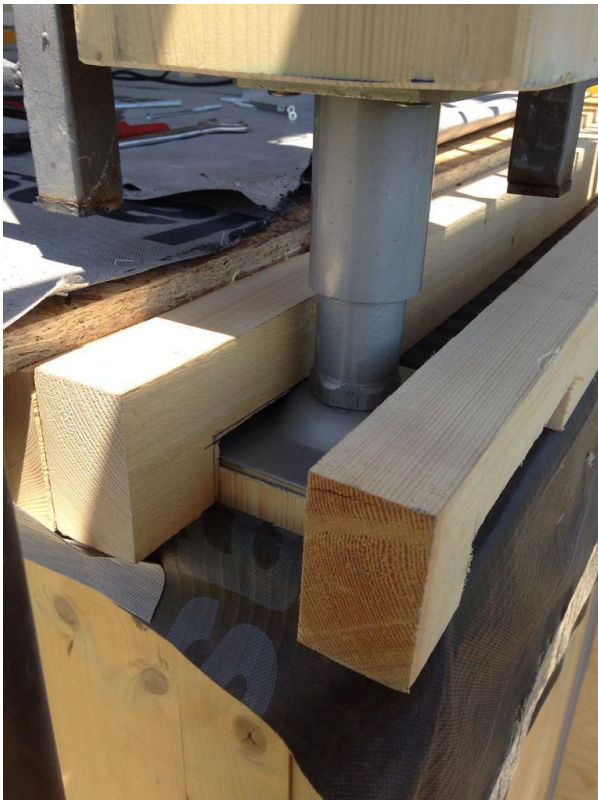
Particolari che mostrano le fasi di intervento alla base dell'elemento di pilastro colpito da degrado: la zona colpita da umidità e marcescenza è stata eliminata con la sostituzione della porzione di legno ammalorata mediante inserimento di un pistone metallico che non mette a contatto diretto il legno con il piano del terrazzo, in modo tale che eventuali ristagni e accumuli di acqua rigenerino fenomeni di marcescenza del legno – fotografie fornite dal professionista incaricato dei lavori, l'architetto Giampiero Cavallo
