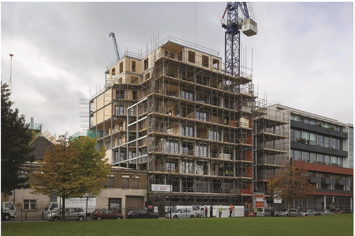
Fase di cantiere in cui si apprezza la struttura in legno dell'edificio
