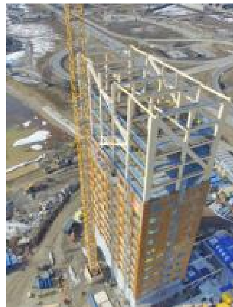
Modello tridimensionale strutturale con la differenziazione dei solai in legno fino all'undicesimo piano e i solai in calcestruzzo per i piani superiori e fase di cantierizzazione della struttura dell'edificio con l'installazione della facciata prefabbricata
