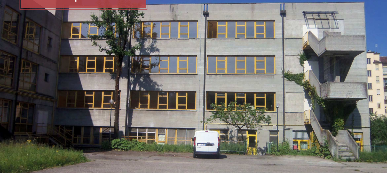
7_Vista dal cortile dei corridoi distributivi esposti ad est
