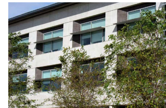
[54] Materiale didattico: Anna Pellegrino, "Sistemi di illuminazione naturale", Laboratorio di progettazione fisico tecnica dell'edificio, a.a. 2018/2019, Politecnico di Torino.
