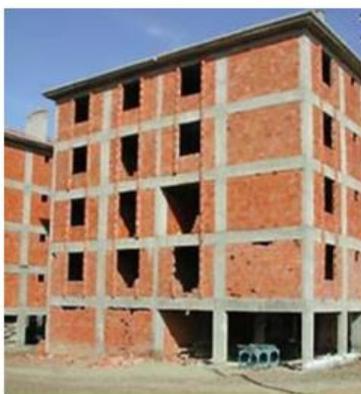
**Figura 1.** Esempio di tamponamenti in muratura
