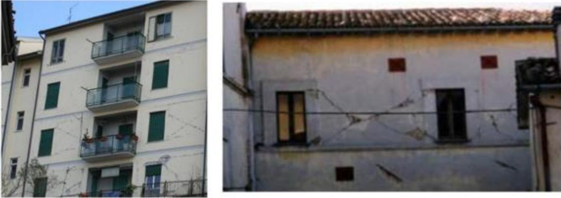
**Figura 5.** Esempi di fessurazione diagonale
