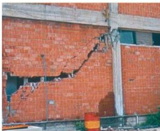
**Figura 8.** Esempio dello schiacciamento degli spigoli [2]
