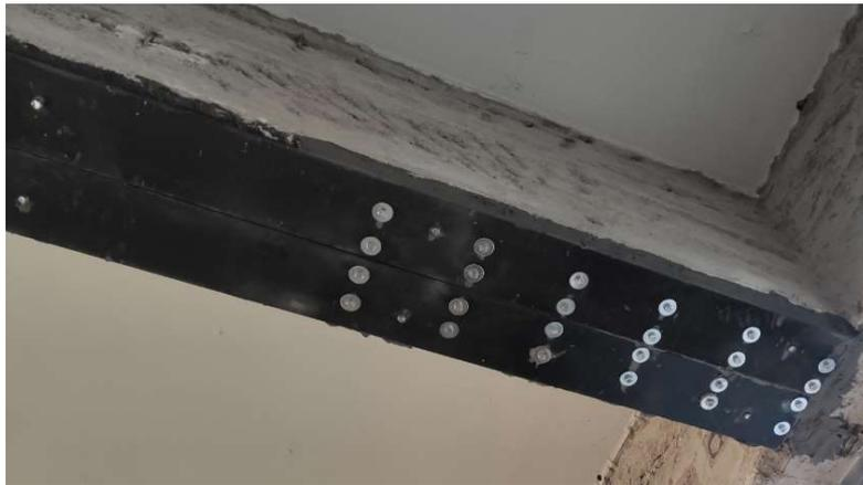
*Figura 4. 54: Fissaggio delle lamine metalliche*
