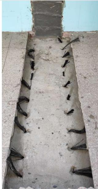
*Figura 4. 49 Rimozione pavimentazione e disposizione dei connettori in corrispondenza del solaio per il rinforzo a taglio delle travi*
