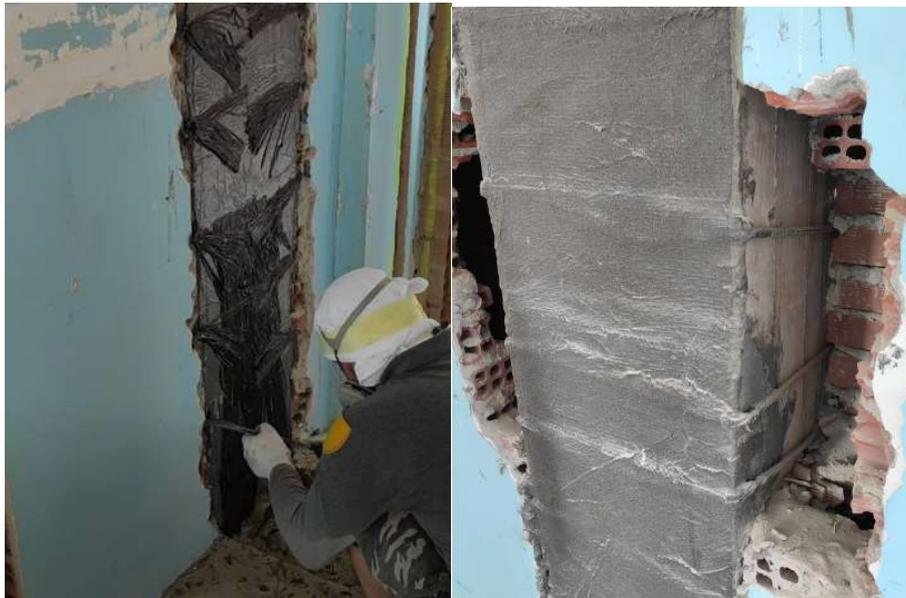
*Figura 4. 60: disposizione dei fiocchi nei pilastri*
