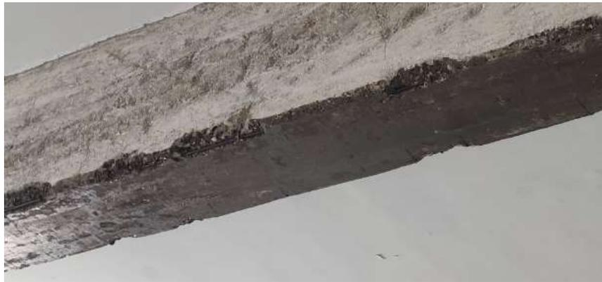
*Figura 4. 51: Applicazione del primer per rinforzo a flessione della trave*
