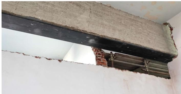
Figura 4. 48 Rimozione di parte della tamponatura per il rinforzo a flessione della trave
