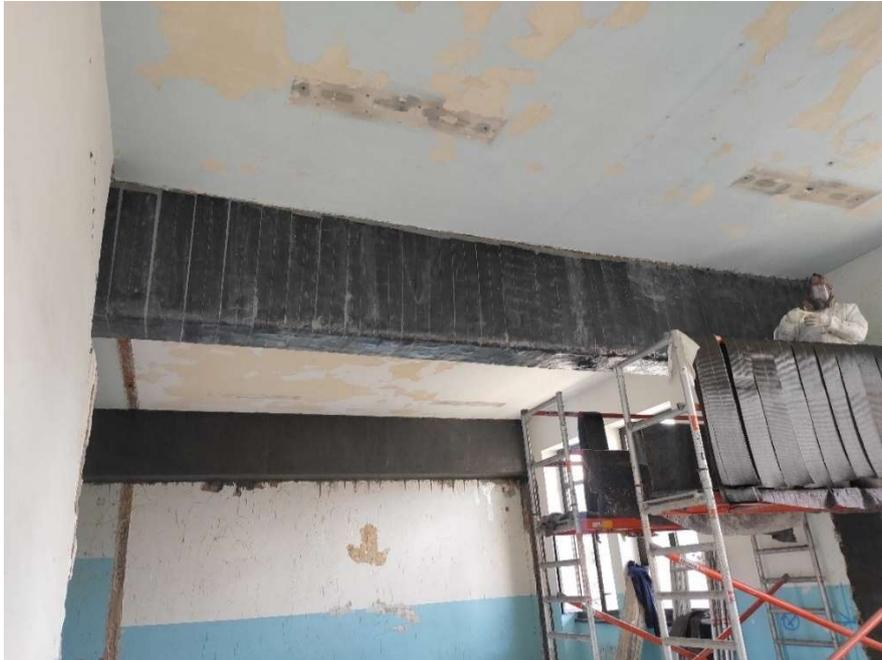
*Figura 2. 29 Rinforzo a taglio e a flessione di una trave in c.a. mediante fasce in fibra di carbonio*
