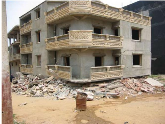
Figura 2. 23 schiacciamento pilastri piano terra - terremoto in Abruzzo [13]
