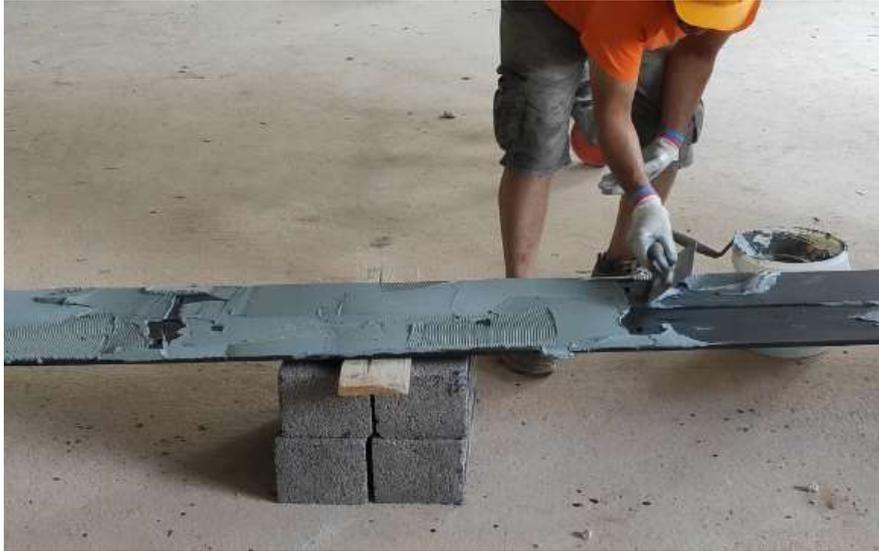
*Figura 4. 52: disposizione dello stucco epossidico sulle lamine metalliche*
