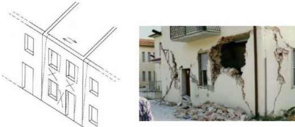
*Figura 2. 7 rottura a taglio dei maschi murari [7]*
