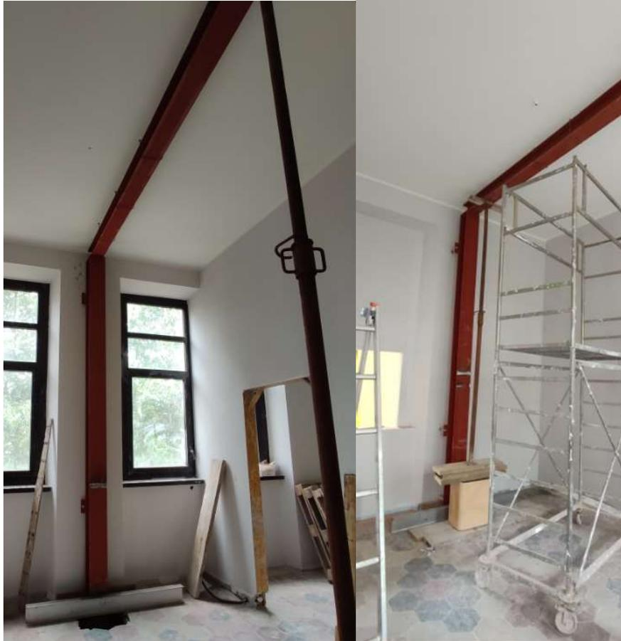
*Figura 4. 65 Portale in acciaio in fase di realizzazione*
