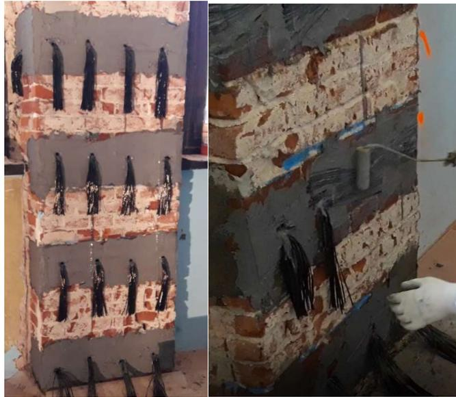
Figura 4. 64 disposizione ed impregnamento dei fiocchi nei piedritti
