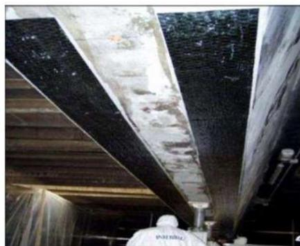
Figura 4. 6: Rinforzo a flessione mediante FRP [17]
