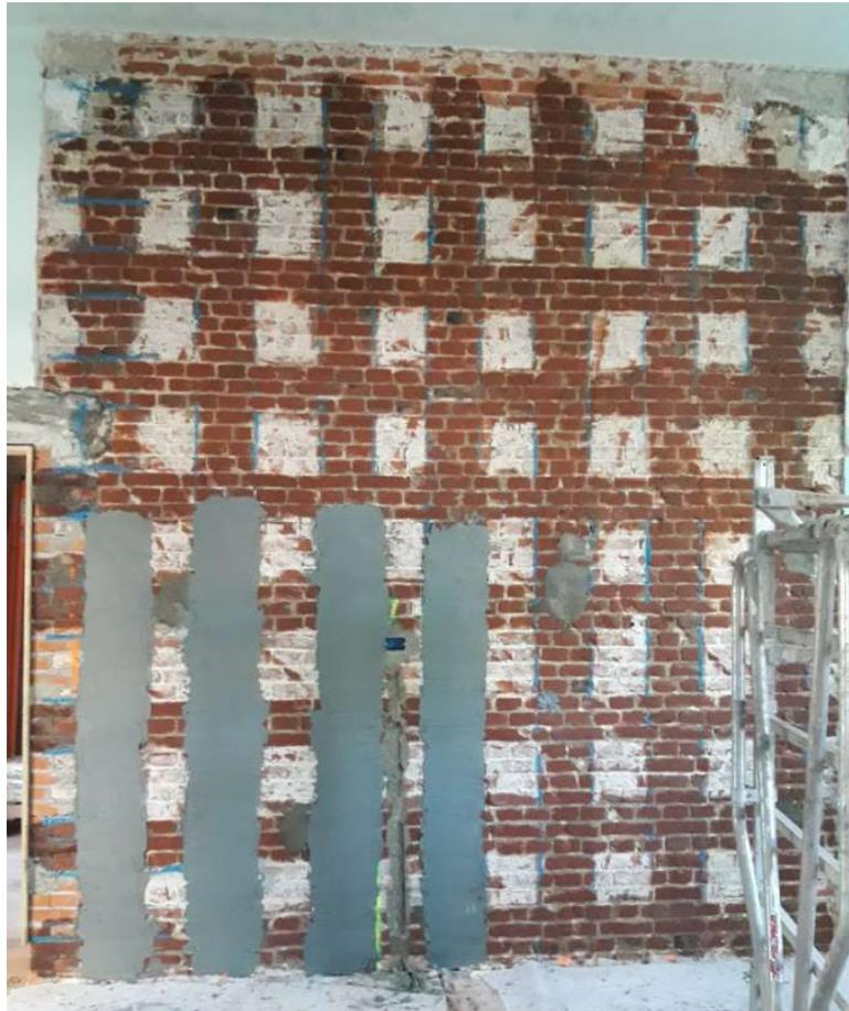
*Figura 4. 61: stesura dello stucco epossidico dopo la pulizia della zona da rinforzare*
