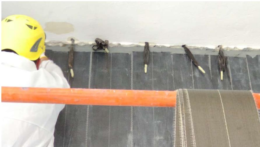
*Figura 4. 57: inserimento dei connettori per rinforzo a taglio totalmente avvolto*
