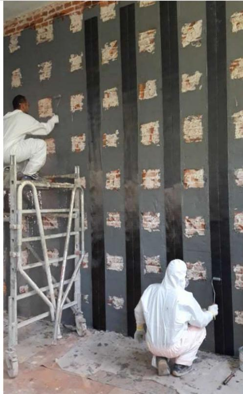
*Figura 4. 62 applicazione del tessuto verticale per il rinforzo a pressoflessione*
