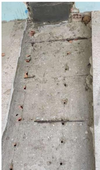
*Figura 4. 50 Esempio trave con armatura a vista*
