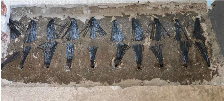
*Figura 4. 58: impregnazione dei fiocchi nella parte superiore della trave*
