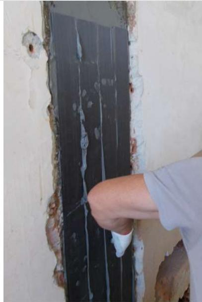
*Figura 4. 59 Applicazione delle lamine nei pilastri*
