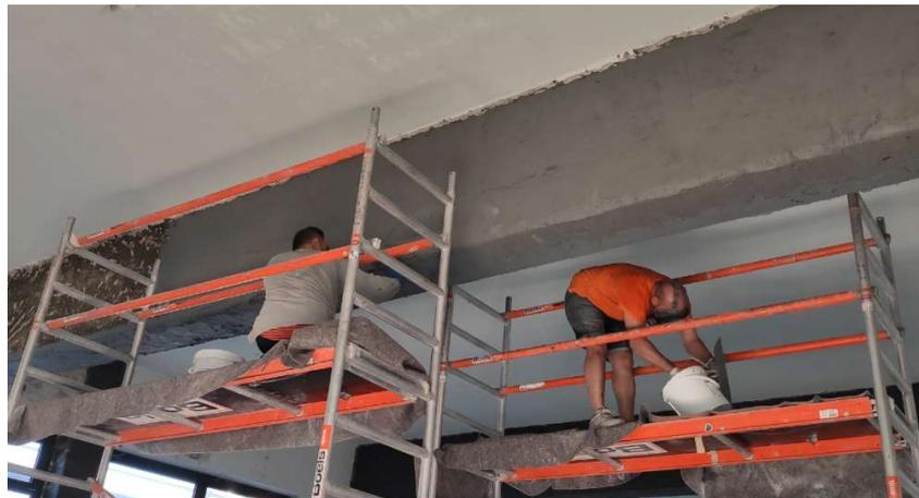
*Figura 4. 55: posa dello stucco epossidico per il rinforzo a taglio della trave*
