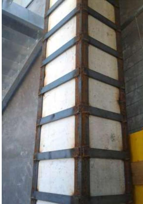
*Figura 2. 28 esempio di incamiciatura in acciaio di un pilastro [17]*
