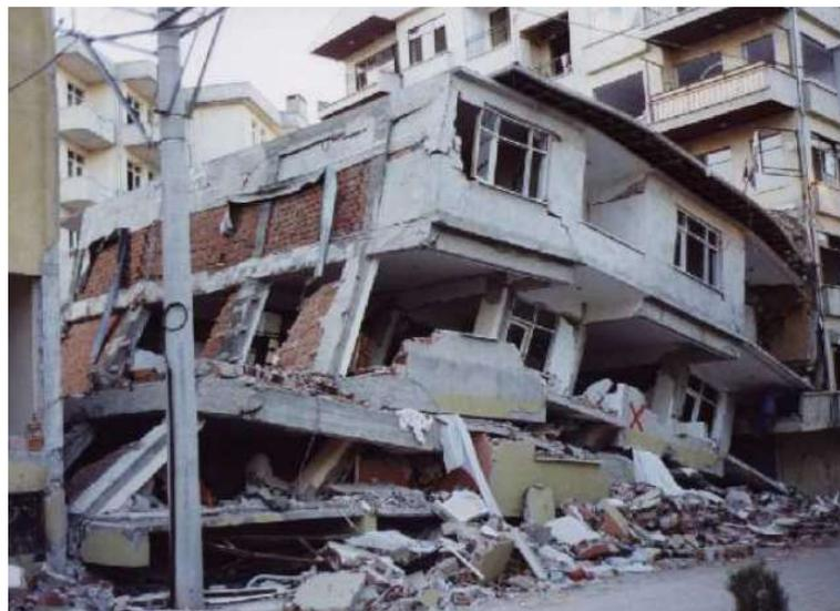
Figura 2. 21 Esempio meccanismo di collasso travi forti-pilastri deboli [14]
