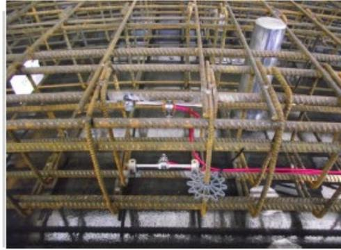
*Figura 3.20 - A sinistra, esempio di barrette estensimetriche. A destra, disposizione del sistema di monitoraggio*
