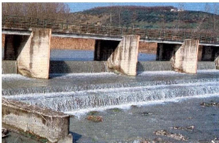
Figura 2.7 - Traversa di Passo Cordone 9
