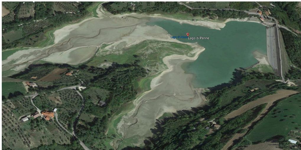
Figura 2.4 - Vista aerea della diga di Penne ottenuta con Google Earth (moltiplicatore elevazione terreno = 3)
