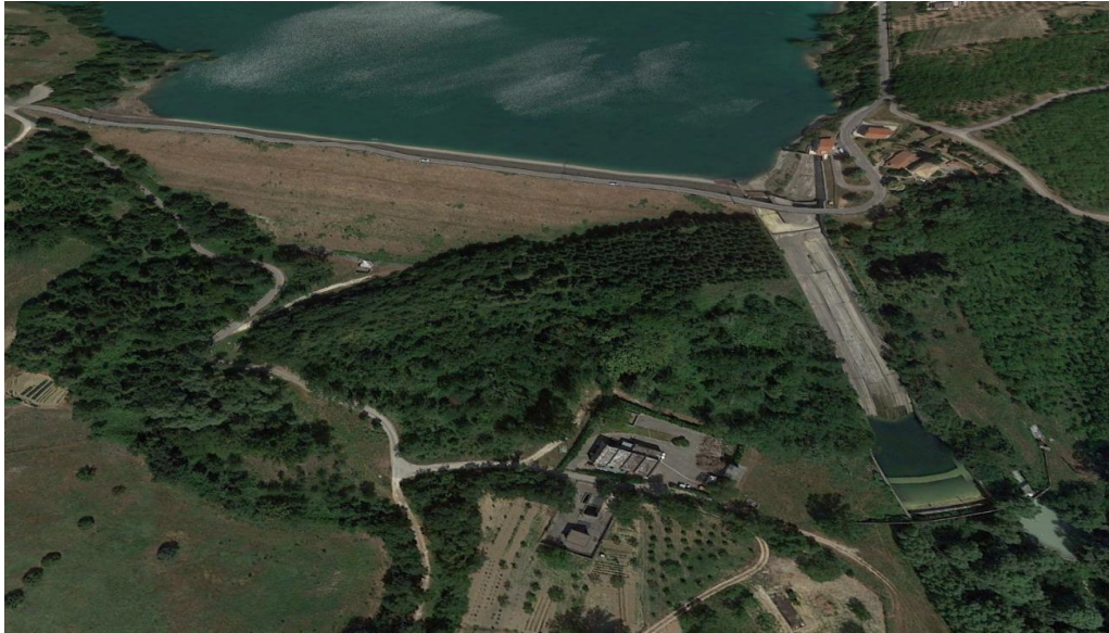
Figura 2.5 - Vista aerea della diga di Penne ottenuta con Google Earth (moltiplicatore elevazione terreno = 1)
