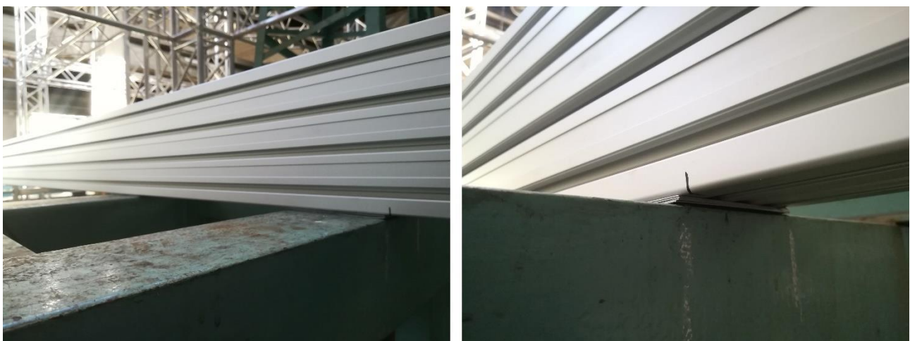
Figura 4.26 - Allineamento di una trave di alluminio mediante i lamierini metallici. Nella figura di destra si osserva la sistemazione di 4 piattine per annullare il dislivello di 2,4 mm tra le due estremità della trave
