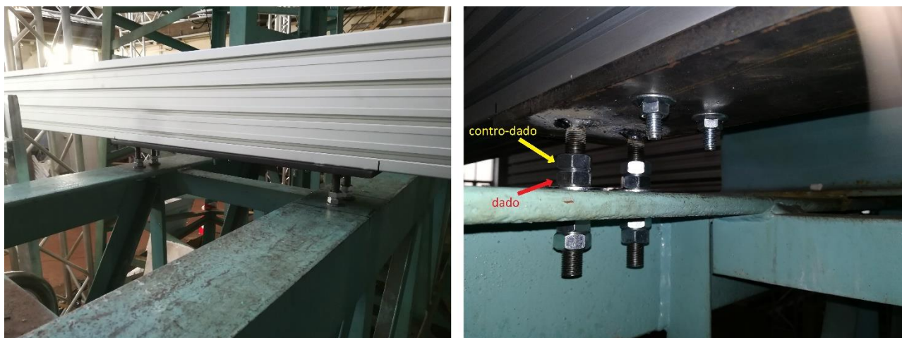
Figura 4.27 - Fissaggio di una trave di alluminio al traliccio per mezzo di un terzo elemento (registro). Nell'immagine di destra si osservano i particolari della bullonatura tra il registro e il traliccio: l'orizzontalità è stabilita effettuando le regolazioni sui quattro dadi a contatto con il traliccio e fissando la posizione con altrettanti contro-dadi
