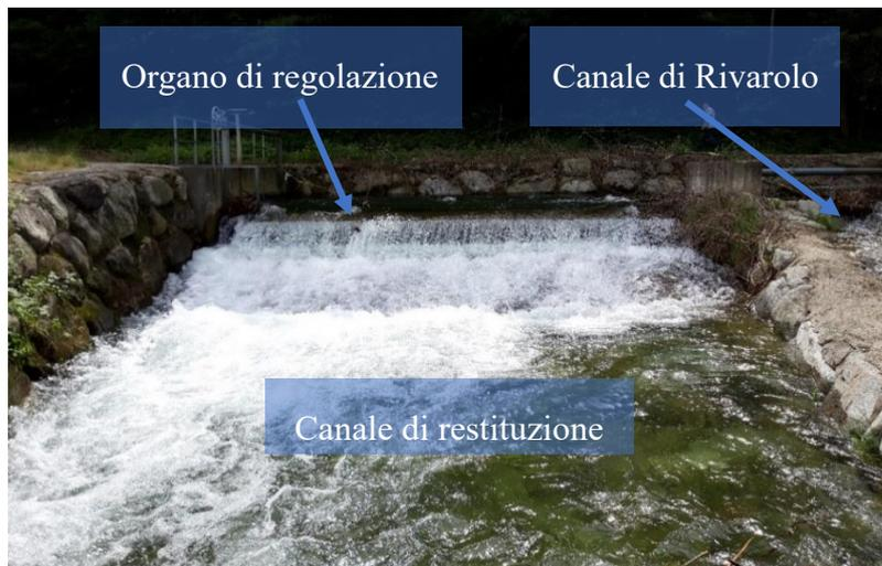
Figura 46: Canale di restituzione, dal Canale di Rivarolo al Torrente Orco; attraversamento ID 24.
