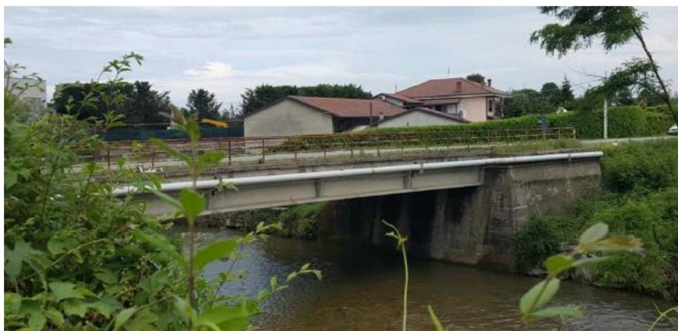
Figura 21: Esempio di condotta in staffaggio a un ponte; attraversamento ID30, Torrente Viana; l'immagine è un render; la condotta rappresentata appartiene al tracciato in progetto [11].
