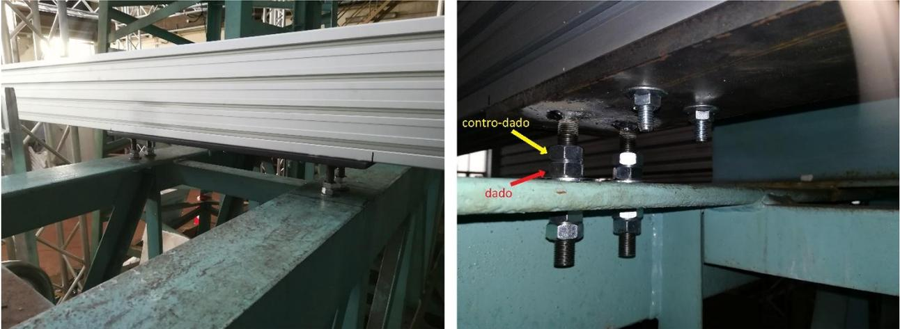
*Figura 5.1.26 - Fissaggio di una trave di alluminio al traliccio per mezzo di un terzo elemento (registro). Nell'immagine di destra si osservano i particolari della bullonatura tra il registro e il traliccio: l'orizzontalità è stabilita effettuando le regolazioni sui quattro dadi a contatto con il traliccio e fissando la posizione con altrettanti contro-dadi*
