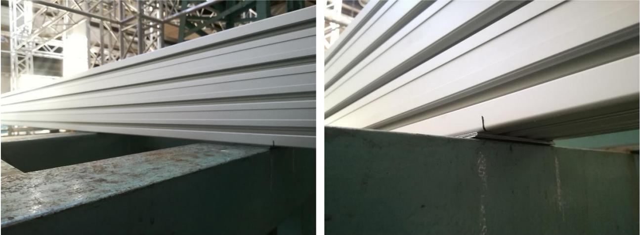
*Figura 5.1.25 - Allineamento di una trave di alluminio mediante i lamierini metallici. Nella figura di destra si osserva la sistemazione di 4 piattine per annullare il dislivello di 2,4 mm tra le due estremità della trave*
