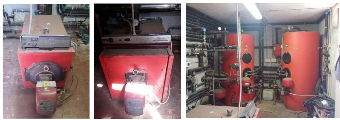
Figura 16 - Caldaie, bruciatori e accumuli per ACS (a sinistra "Motel B", a destra "Motel A")
