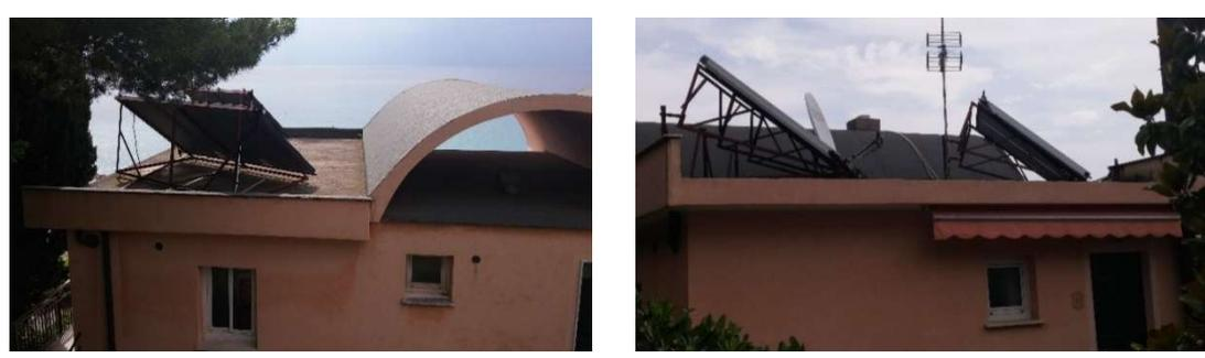
Figura 17 - Impianti a collettori solari a circolazione forzata per l'integrazione di ACS
