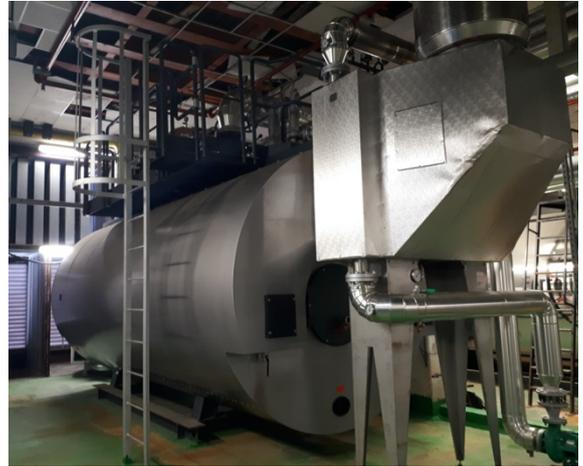
*Figura 39: Caldaia Viessmann presente in centrale*
