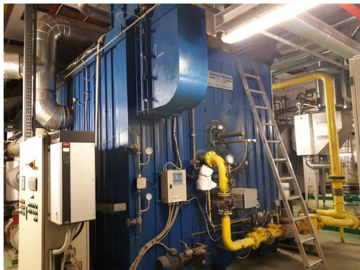
*Figura 37: Caldaia Babcock Wanson presente in centrale.*
