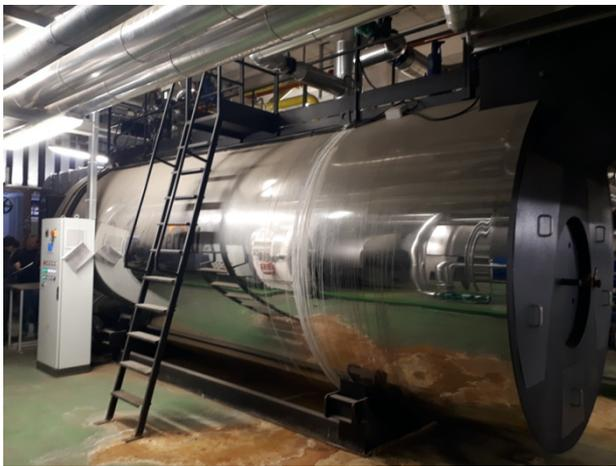
*Figura 38: Caldaia Ferroli presente in centrale.*
