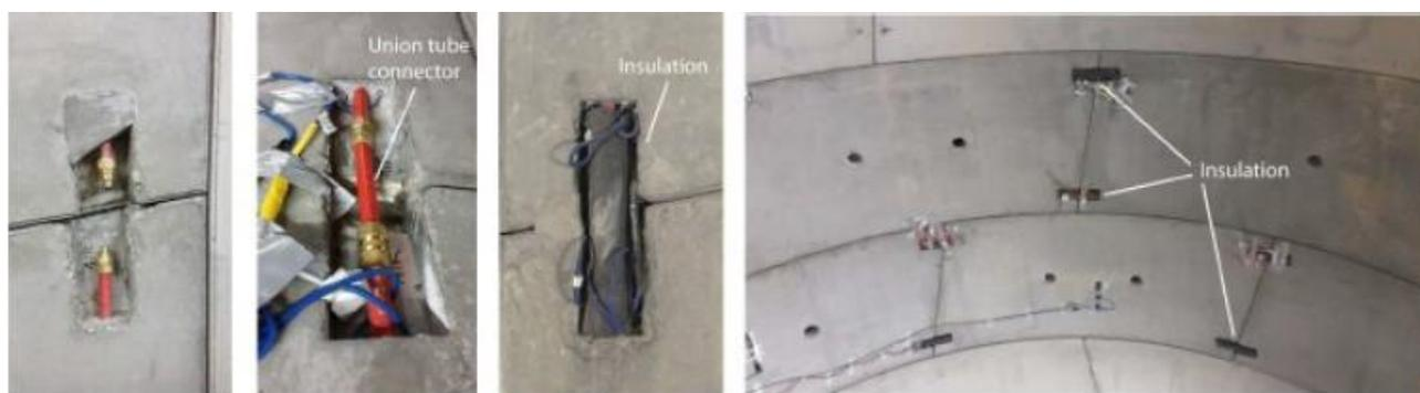
Figura 19 - Collegamento delle tubazioni tra moduli adiacenti e applicazione del rivestimento isolante
