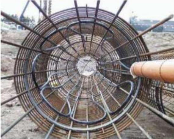
Figura 16 - Particolare interno di un palo energetico
