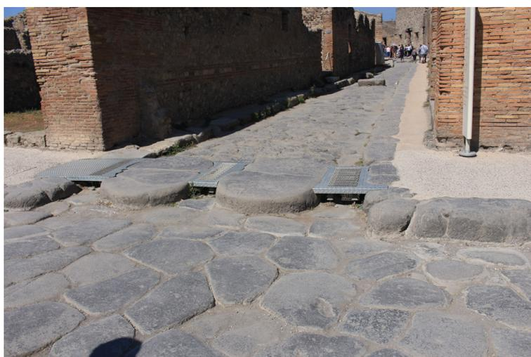
Sistemi in metallo per il superamento di ostacoli dovuti alla conformazione della strada storica.
