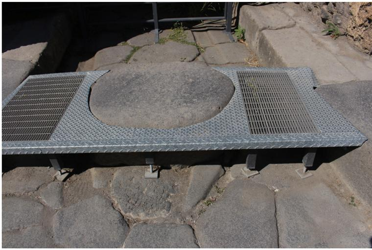
Dettaglio elemento di superamento e congiunzione di due lati di strada.
