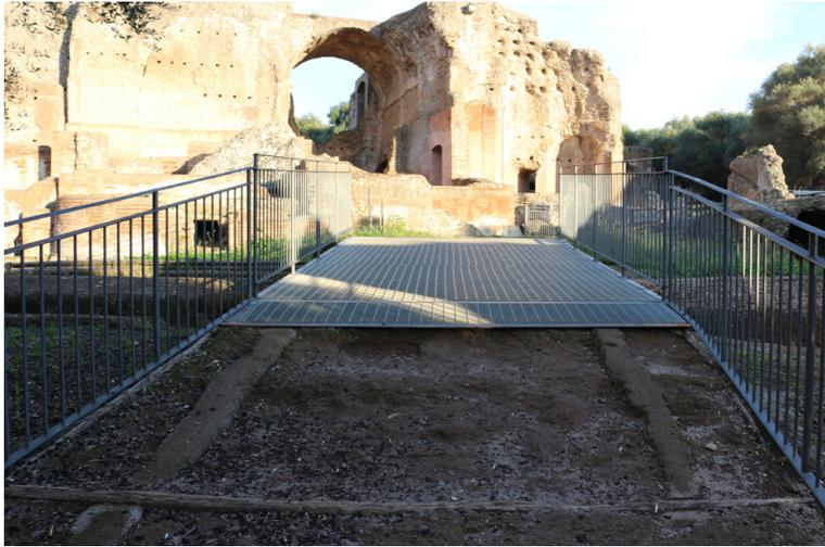
**Mancata giunzione tra materiali diversi** che crea dislivelli e incoerenze ampia dalla disgregazione del fondo in cemento della rampa e dal suo degrado elevato.
