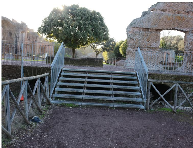
**Scala in metallo** completamente **rimovibile** prima della spiana del Canopo non integrata adeguatamente con il contesto.
