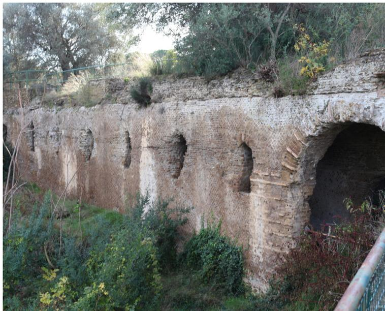
Sostruzioni sotto Piazza d'Oro che sviluppano un salto di quota superiore a 3 m. Ad oggi non sussistono collegamenti con la parte visitabile della Villa e risultano inaccessibili.
