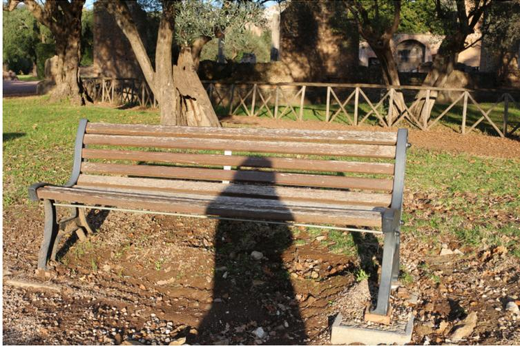
Punto di sosta composto da una panchina degradata con parti mancanti di verniciatura e con plinti di ancoraggio a terra visibili.
