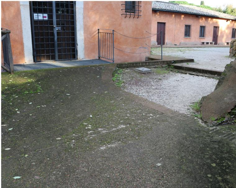
Degrado delle pavimentazioni con **disgregamento** e **manca-**
