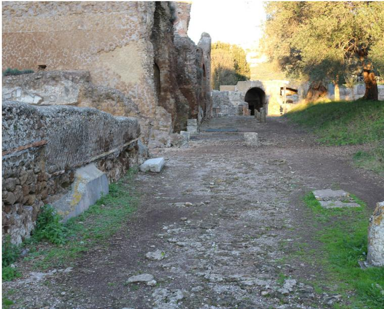
Cambi di pavimentazione e presenza di detriti nel Cortile delle Biblioteche che creano dei micro dislivelli recanti problemi con la percorrenza.
