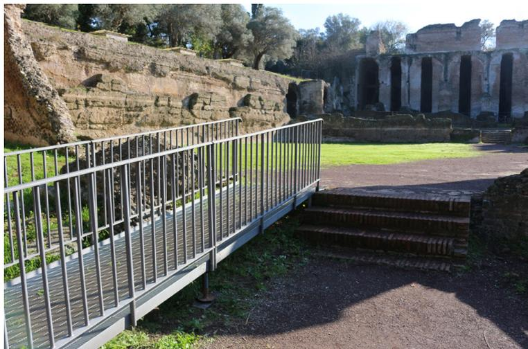
Si compone di una **rampa metallica** rimovibile e una **scala in muratura**.
