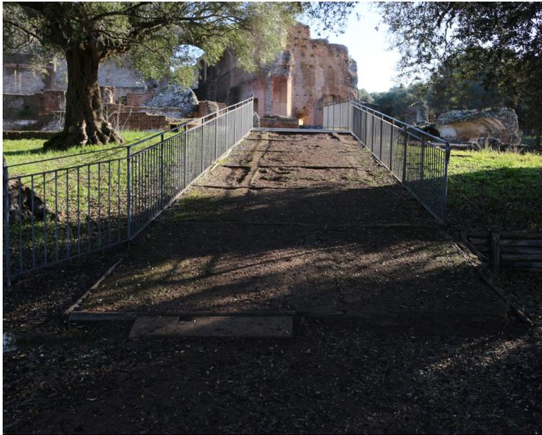
Rampa in calcestruzzo - Questo **materiale** data l'assenza di manutenzione si presenta **estremamente degradato**. Oltre in questo specifico caso sul sito i sottofondi in calcestruzzo si presenta perlopiù degradato e disgregato impedendo di fatto la fruizione in sicurezza e agilmente.
