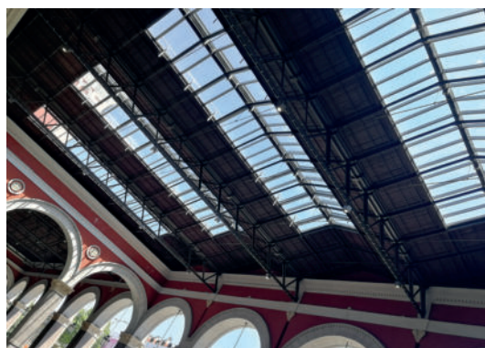
Fig. 3 - Copertura in ferro e vetro del portico (foto personale)
