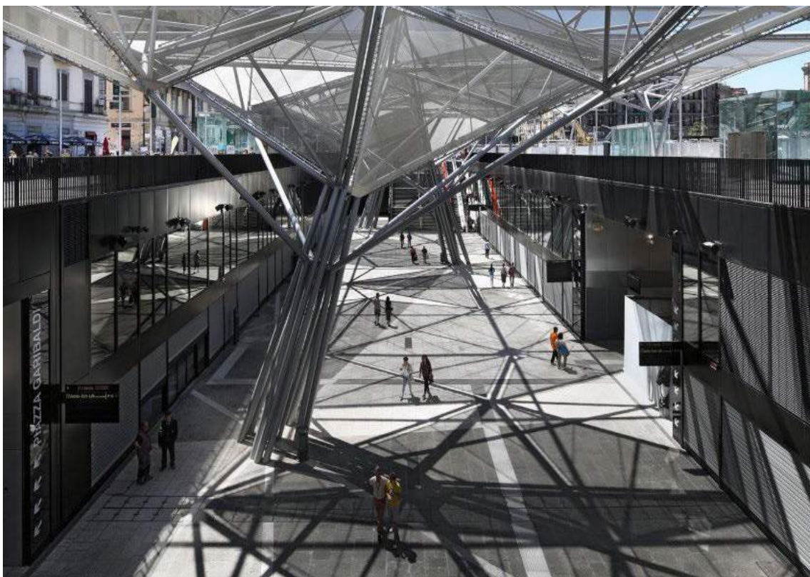
Fig. 4 - Interno della Galleria commerciale interrata, particolare delle ombre date dalla struttura in acciaio degli alberi tubolari (photo credit: https://www.professionearchitetto.it/Napoli-riconsegnata-Piazza-Garibaldi-60mila-mq-firmati-Dominique-Perrault )
