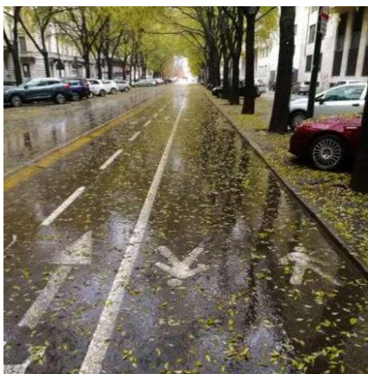
Fig. 6 - L'assenza di soluzioni ambientali per il deflusso delle acque provoca il ruscellamento delle acque meteoriche (foto personale, Novembre 2019)
