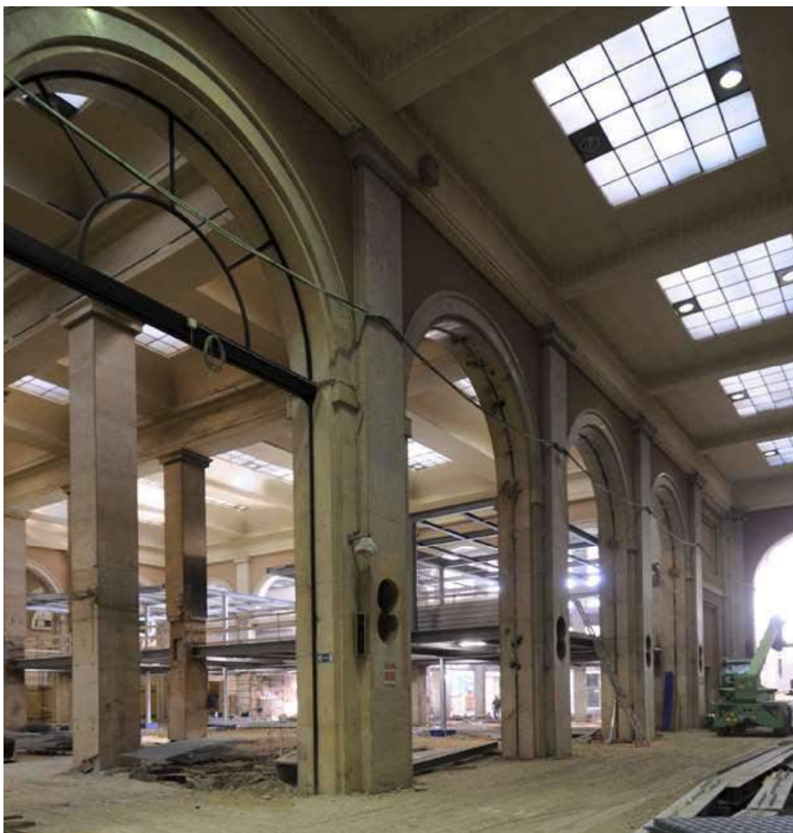
Fig. 11 - Il cantiere del recupero ed adeguamento funzionale della stazione (photo credit: © Luca Moretto)
