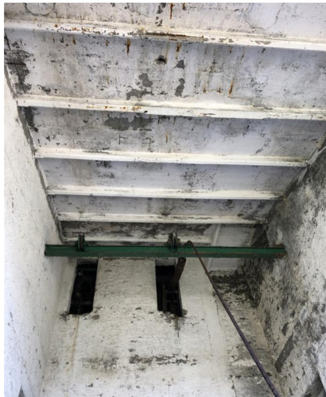
10\_Il soffitto dell'ingresso della cabinovia: anche qui si notano ferri a vista, anche se in minor quantità e annerimento delle pareti.
