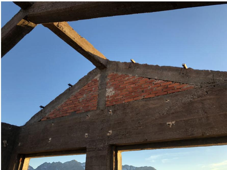
19\_Dettaglio del frontone del tetto: sono visibile gli elementi di aggancio delle travi secondarie (assenti).
