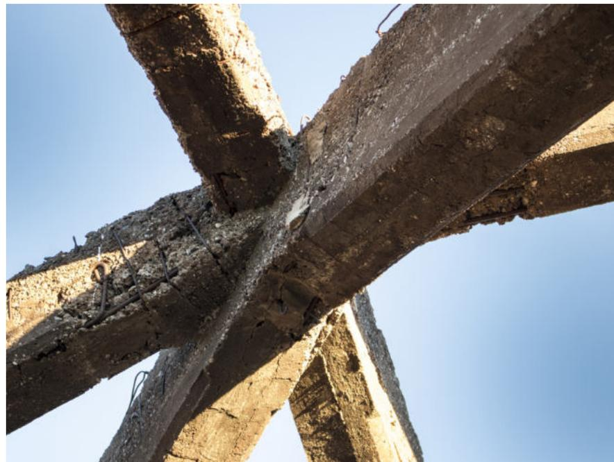
20\_Dettaglio del frontone del tetto: sono visibile gli elementi di aggancio delle travi secondarie (assenti).
