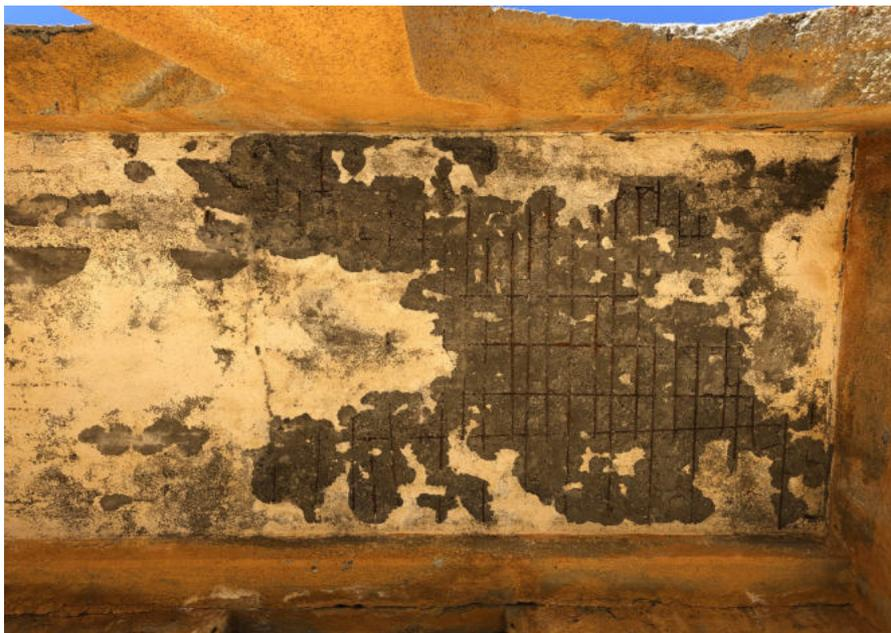
06\_(sopra)Il soffitto del piccolo portico: i ferri del solaio sono ormai a vista da tempo.
