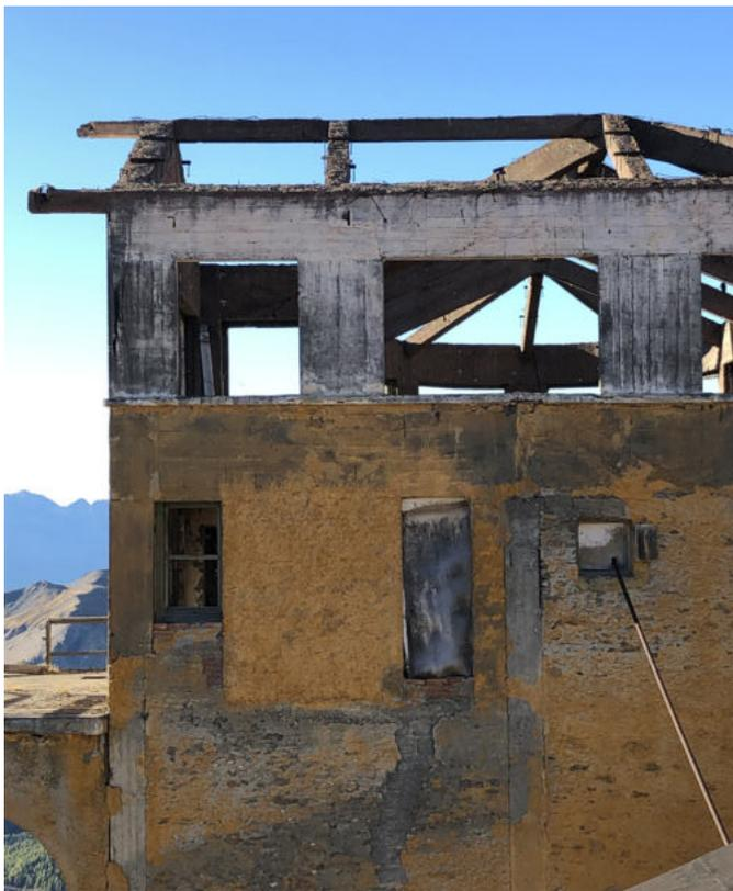
02\_La facciata posteriore: la copertura del tetto è totalmente assente e le condizioni degli intonaci sono pessime; manca il parapetto del piccolo terrazzo.
