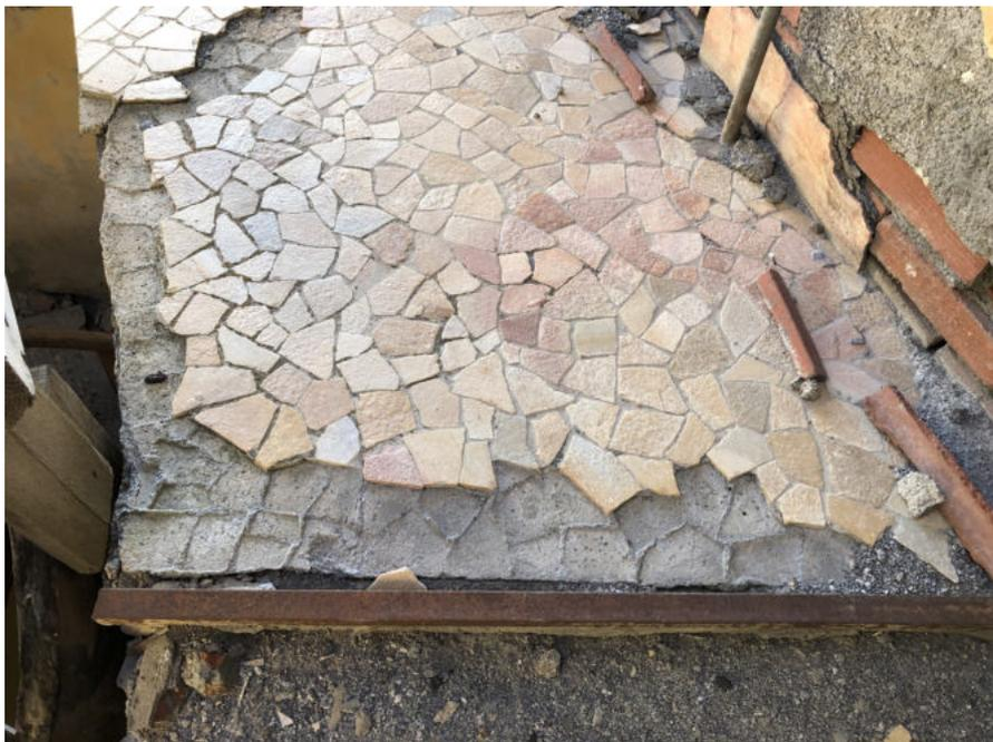
13\_(sopra) Dettaglio della pavimentazione in mosaico (presumibilmente in quarzite) dei solai del corpo distributivo.
