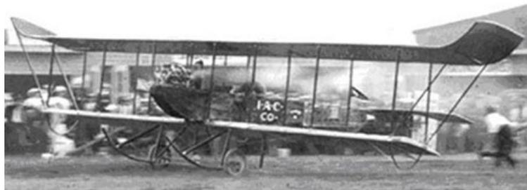
Figura 1.3: Biplano di Somerville dotato di dispositivi di estremità tipo winglet, [15]
