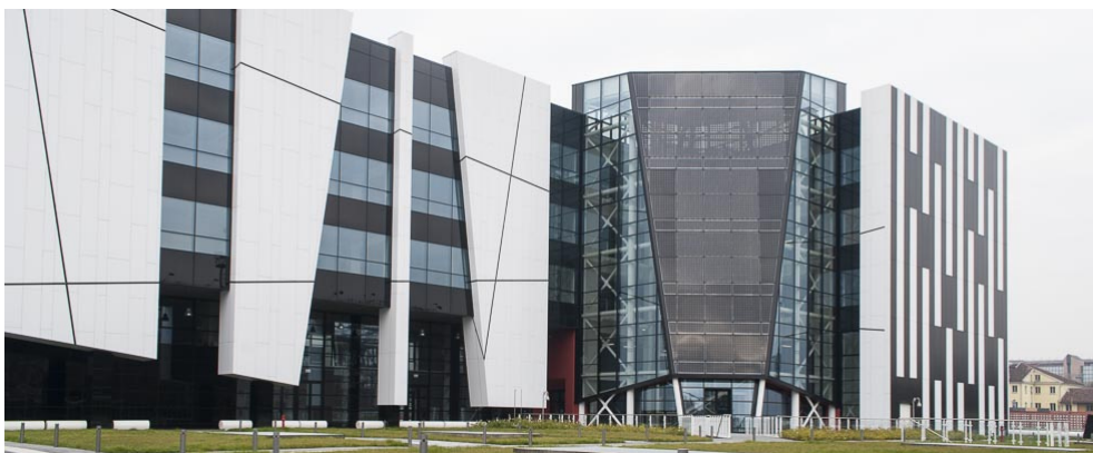
Figura 4.1: Ingresso principale Energy Center-Via P.Borsellino n38/16
