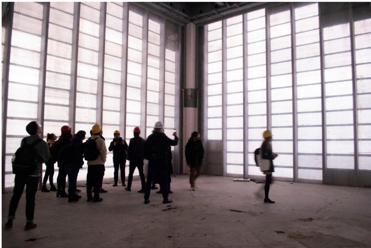
*Figura 50 - Foto di una delle sale espositive al piano terra. È ben visibile l'effetto di trasparenza generato dal cemento i.ight®, che lascia penetrare la luce all'interno generando un ambiente confortevole*
