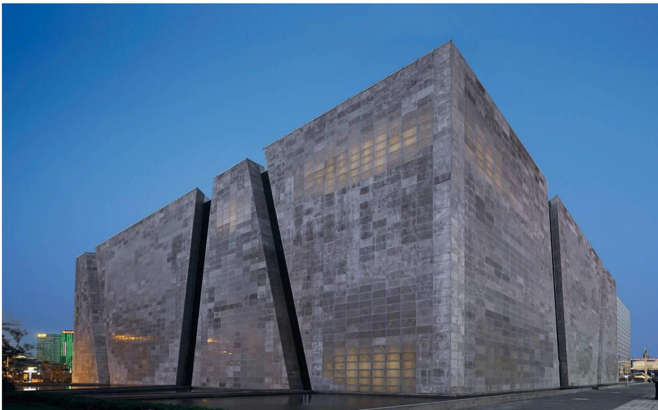
*Figura 6 - Vista nord-est del Padiglione, dalla quale è possibile intuire la percezione delle luci interne attraverso il cemento semi trasparente al calar del sole*
