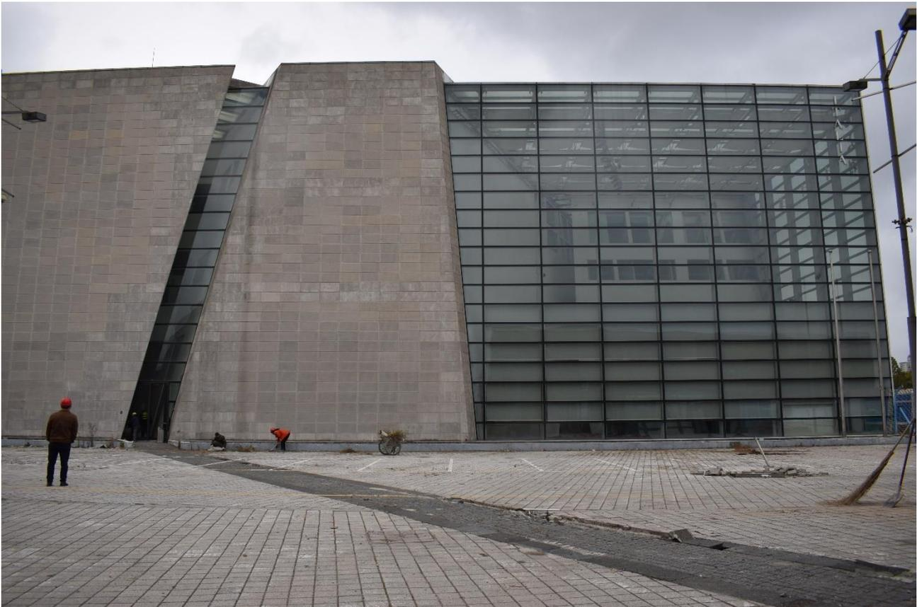
*Figura 44 - Stralcio del prospetto sud, con in evidenza il taglio vetrato che seziona il volume, proseguendo esternamente in pianta*
