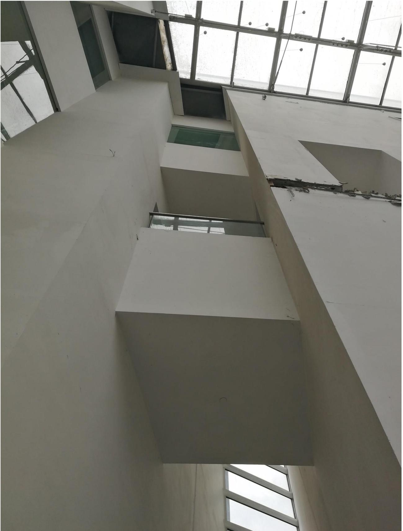
*Figura 48 - Vista sulle strutture-ponte in acciaio che collegano, ai livelli superiori, i diversi blocchi dell'edificio*
