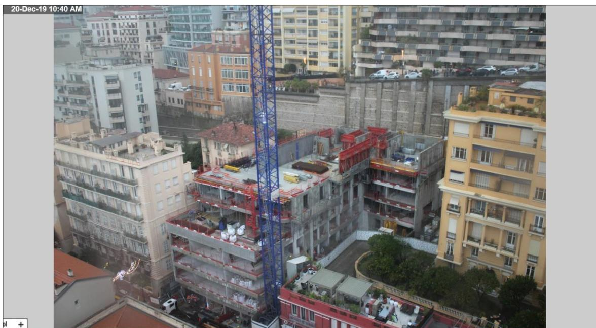
**Figura 80: Fotografia del 20 dicembre 2019 (ore 10:40) - Realizzazione Piano quinto e inizio piano sesto, fonte Vinci Construction Monaco**
