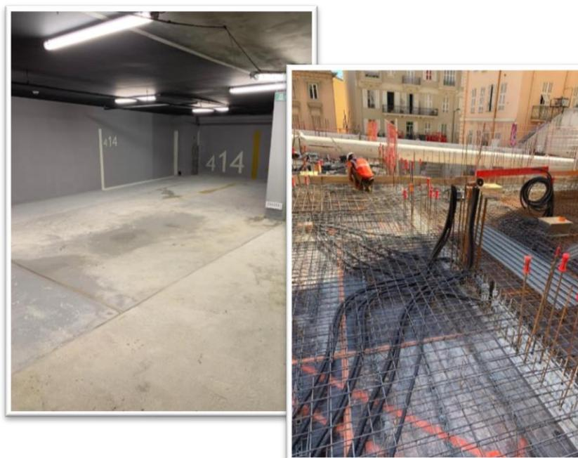
**Figura 68 e 69: Vista delle opere secondarie del parcheggio – passaggio dei cavi elettrici prima del getto per il solaio, fonte Vinci Construction Monaco**
