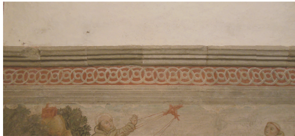
Fig. 2.3.7 Rivalta Scrivia. Dettaglio cornice modanata in pietra
