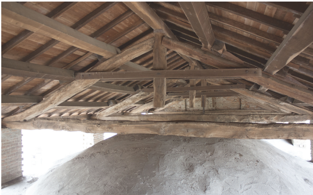
Fig. 3.14 Sottotetto navata centrale, realizzazione del massetto in CLS sull'estradosso delle volte
