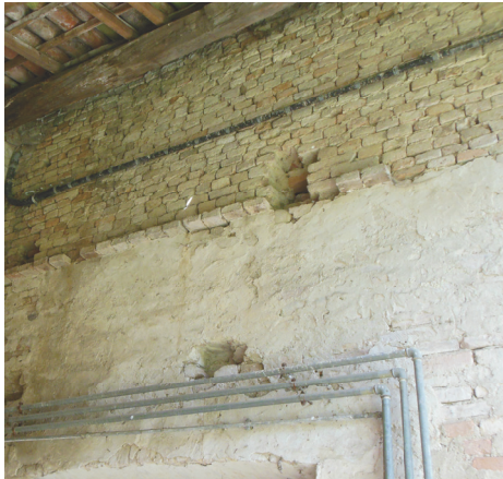
Fig. 7.17 Prospetto meridionale. Dettaglio muratura PS008 con mattoni disposti in chiave
