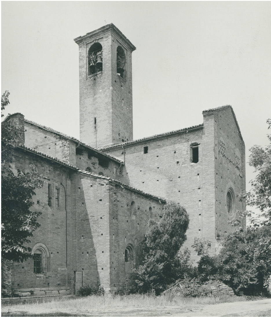
Fig. 7.1 Paolo Verzone, porta di collegamento della chiesa con l'esterno prima del suo tamponamento (in Laboratorio di Storia e Beni Culturali - DIST, Fondo Verzone , prima metà XX secolo)
