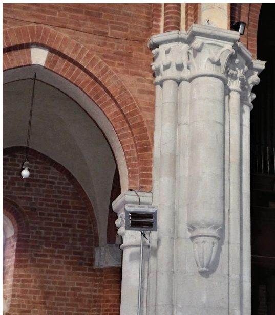
Fig. 2.3.24 Rivalta Scrivia. Colonna pensile del pilastro polilobato di sinistra
