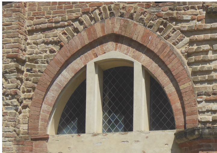
Fig. 3.21 Restauro delle finestre poste in facciata
