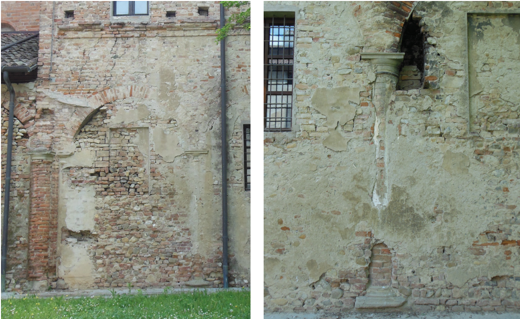
Fig. 2.4.4 Rivalta Scrivia. Galleria orientale, tamponamenti esterni
