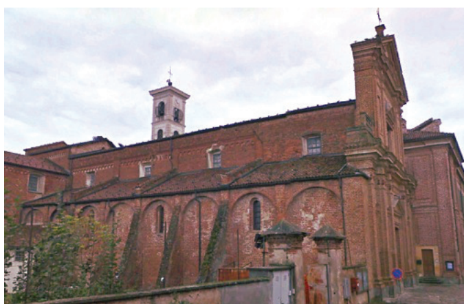
Fig. 2.3.37 Casanova. Contrafforti ad arcate cieche su paraste, in http://archeocarta.org/carmagnola-to-antica-abbazia-s-maria-casanova/
