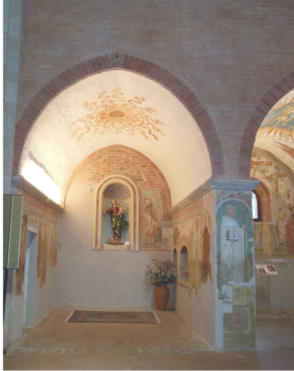
Fig. 2.3.6 Rivalta Scrivia. Arco di accesso alla cappella laterale
