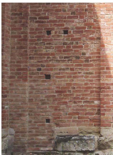
Fig. 3.19 Tamponamento della porta di collegamento con la chiesa
