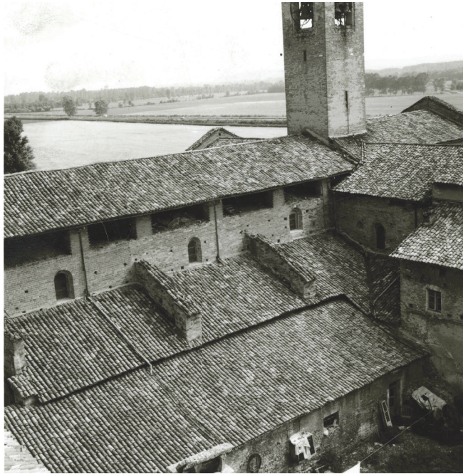
Fig. 7.15 Prospetto meridionale. Legnaia (in Archivio Fotografico SABAP-TO, AL_Tortona_32890, 1970)
