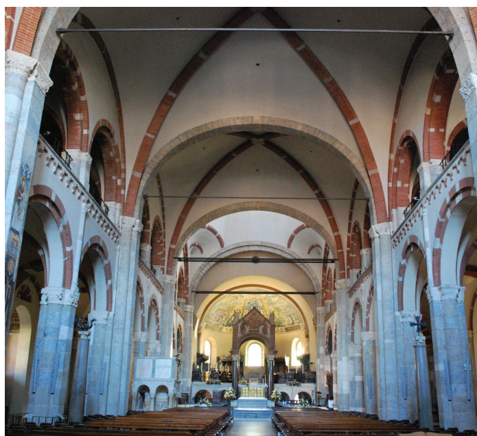
Fig. 2.3.31 Basilica di Sant'Ambrogio a Milano. Sistema di pilastri polistili e volte a crociera costolonate
