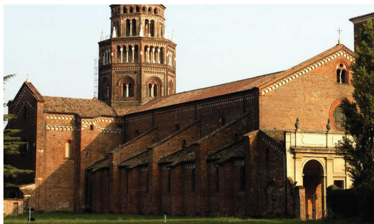
Fig. 2.3.36 Chiaravalle Milanese. Sistema dei muri trasversi, in http://www.borgodichiaravalle.org/borgo/abbazia-di-chiaravalle/
