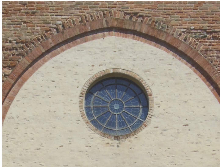
Fig. 3.20 Restauro del rosone posto in facciata, 2000
