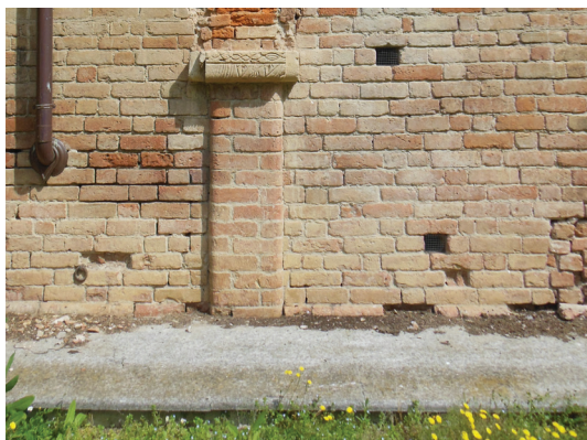
Fig. 2.3.51 Rivalta Scrivia. Prospetto sud. Marciapiede in pietra
