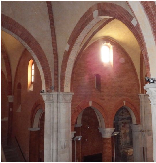
Fig. 2.3.20 Rivalta Scrivia. Apertura tamponata al di sotto del cleristorio
