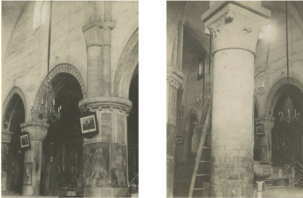
Fig. 3.11 Paramenti interni intonacati (in Archivio Fotografico SABAP-TO, AL_Tortona_1504, ottobre 1940)
