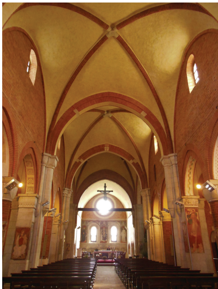
Fig. 2.3.30 Rivalta Scrivia. Semicolonne di scarico degli archi
