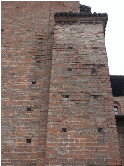
Fig. 2.3.39 Rivalta Scrivia. Contrafforte destro del transetto
