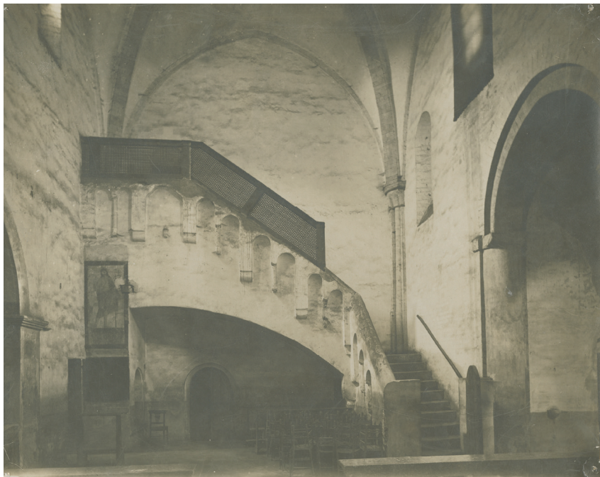
Fig. 3.10 Stato della scala dei monaci (in Archivio Fotografico SABAP-TO, AL_Tortona_16632, ottobre 1942)
