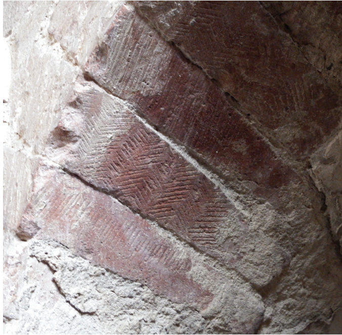
Fig. 2.3.15 Rivalta Scrivia. Graffiature a spina-pesce all'interno della scala a chiocciola
