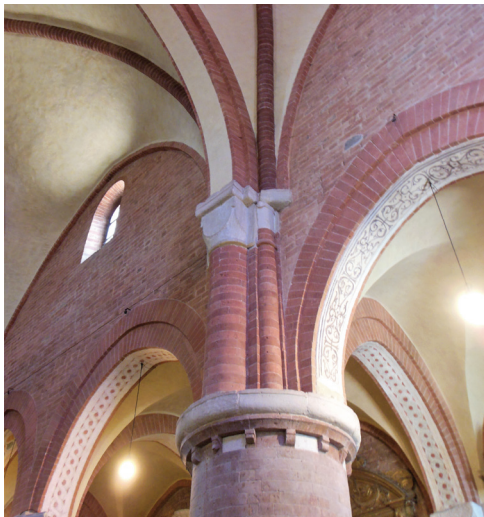
Fig. 2.3.28 Rivalta Scrivia. Semicolonne di scarico degli archi
