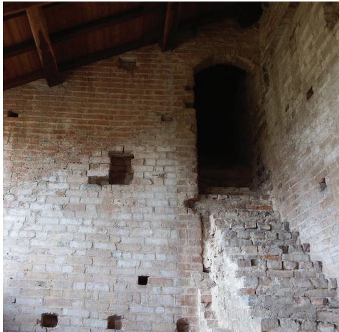
Fig. 2.3.16 Rivalta Scrivia. Scala a rampa unica di accesso ai sottotetti
