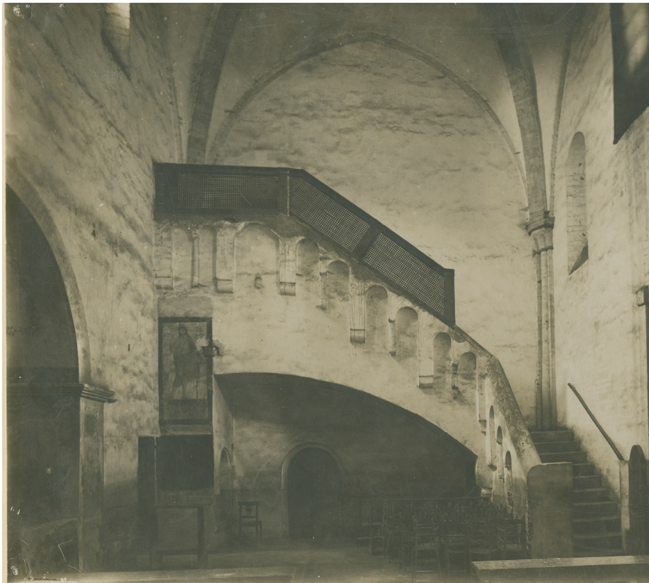
Fig. 2.3.8 Rivalta Scrivia. Accesso taponato alla cappella (da Archivio Fotografico SABAP-TO, 1910)
