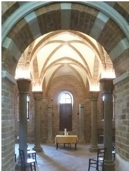
Fig. 3.16 Sala capitolare a seguito degli interventi dello Studio Tecnico Flli Sala
