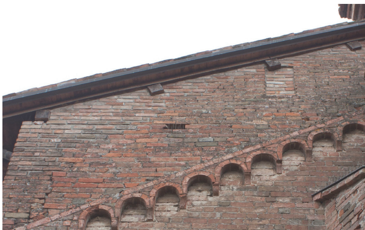
Fig. 7.22 Fianco nord delle cappelle laterali. Risarcitura delle murature
