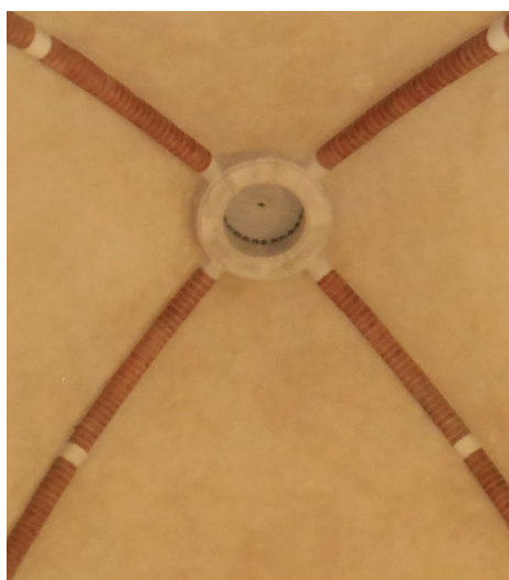
Fig. 2.3.11 Rivalta Scrivia. Costoloni torici. Campata centrale del transetto
