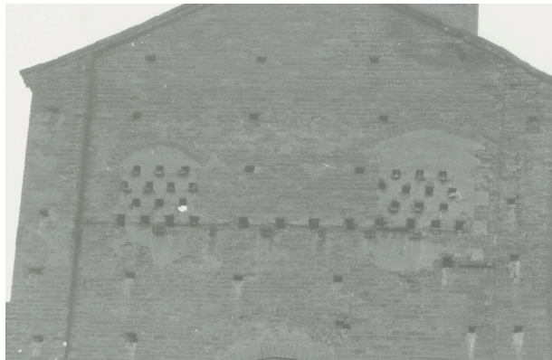
Fig. 7.9 Paolo Verzone, abside centrale, intonaco di rivestimento dei tamponamenti (in Laboratorio di Storia e Beni Culturali-DIST, Fondo Verzone , prima metà XX secolo)
