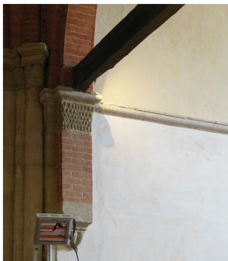
Fig. 2.3.10 Rivalta Scrivia. Elemento pensile di scarico dell'arco
