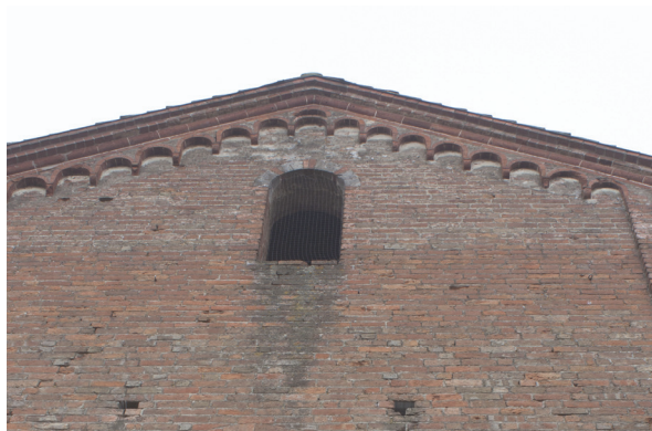
Fig. 7.24 Testata nord del transetto. Muratura del timpano
