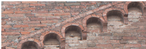
Fig. 7.13 Abside di destra. Archetti pensili sul prospetto orientale e su quello settentrionale
