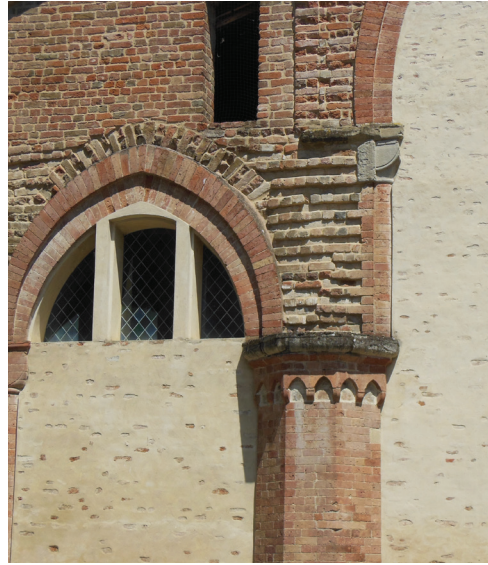
Fig. 2.3.27 Rivalta Scrivia. Modanatura del pilastro ottagonale inglobato nella facciata
