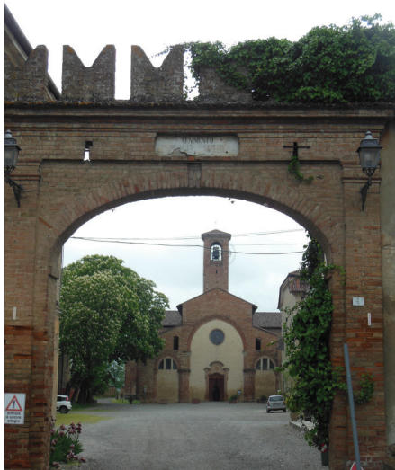
Fig. 2.4.1 Rivalta Scrivia. Arco di ingresso al complesso abbaziale
