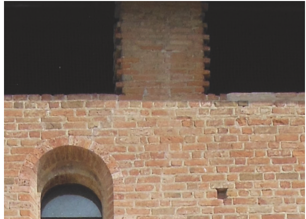
Fig. 7.18 Prospetto meridionale. Pilastrino di rialzo della copertura
