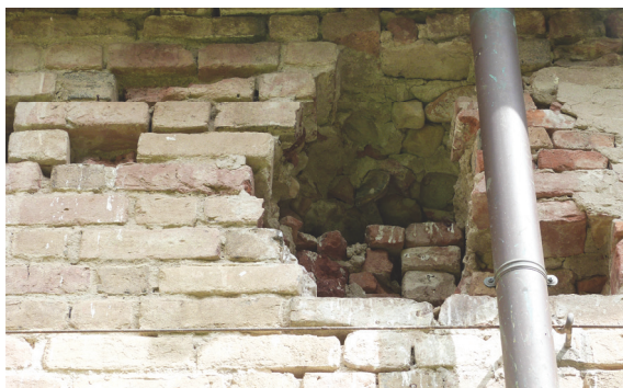
Fig. 7.14 Prospetto meridionale. Fori di alloggiamento degli originali puntoni dal profilo irregolare
