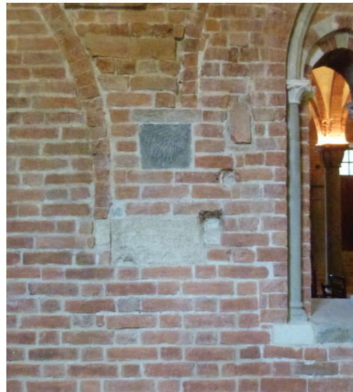
Fig. 2.4.3 Rivalta Scrivia. Galleria Orientale, mensola dell'originaria copertura
