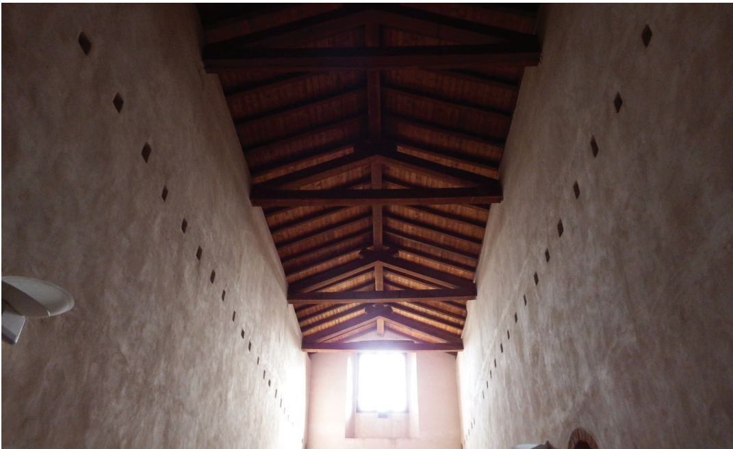
Fig. 2.4.5 Rivalta Scrivia. Monastero, buche di alloggiamento dell'orditura dell'impalcato
