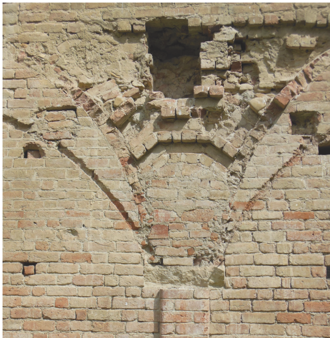
Fig.7.16 Prospetto meridionale. Traccia dell'originario riempimento tra le volte
