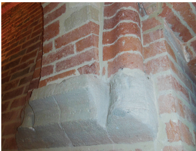
Fig. 2.3.54 Rivalta Scrivia. Sagrestia, dettaglio dei costoloni e della mensola di scarico
