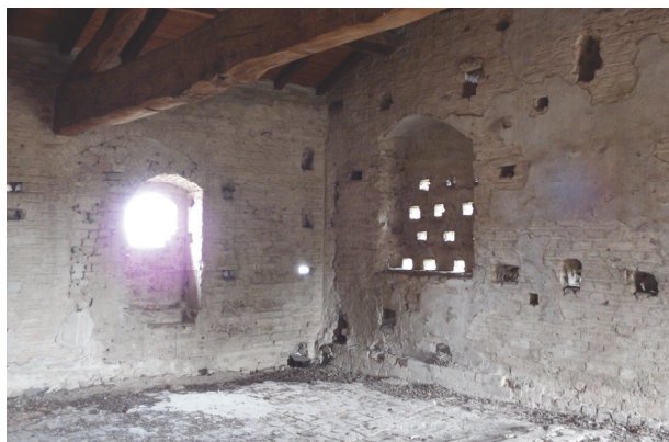
Fig. 7.10 Tamponamenti delle aperture visti dall'interno del locale posto al di sopra del presbitero
