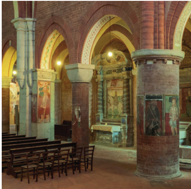
Fig. 2.3.23 Rivalta Scrivia. Sistema alternato dei sostegni
