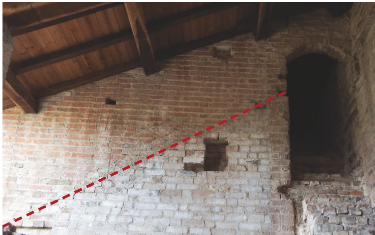
Fig. 7.21 Fianco settentrionale del presbiterio. Accostamento delle murature PNa003 e PNA006
