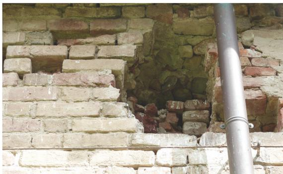
Fig. 7.14 Prospetto meridionale. Fori di alloggiamento degli originali puntoni dal profilo irregolare
