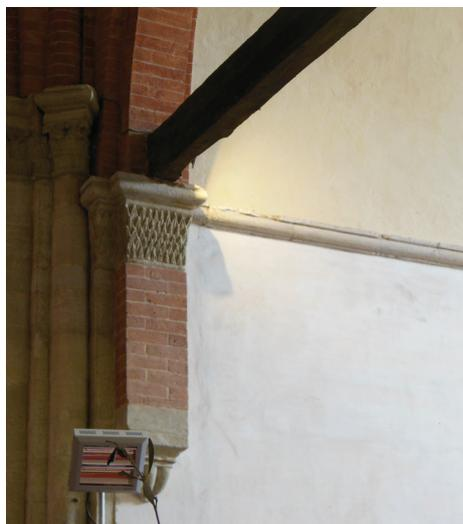
Fig. 2.3.10 Rivalta Scrivia. Elemento pendente di scarico dell'arco
