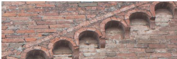
Fig. 7.13 Abside di destra. Archetti pensili sul prospetto orientale e su quello settentrionale
