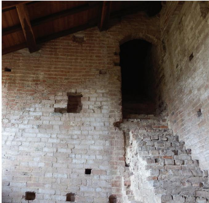
Fig. 2.3.16 Rivalta Scrivia. Scala a rampa unica di accesso ai sottotetti
