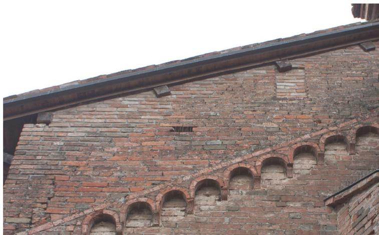
Fig. 7.22 Fianco nord delle cappelle laterali. Risarcitura delle murature
