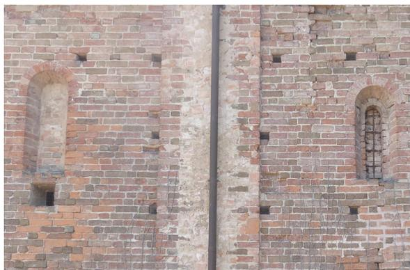
Fig. 7.26 Corpo longitudinale settentrionale. Monofore tamponate
