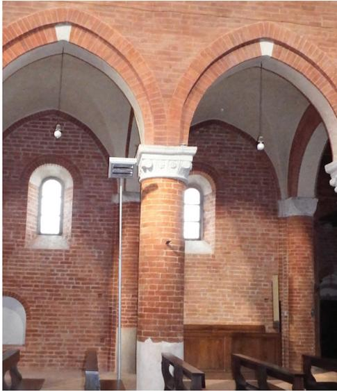
Fig. 2.3.26 Rivalta Scrivia. Pilastro debole cilindrico in laterizi
