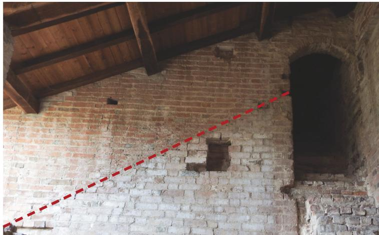
Fig. 7.21 Fianco settentrionale del presbiterio. Accostamento delle murature PNa003 e PNA006
