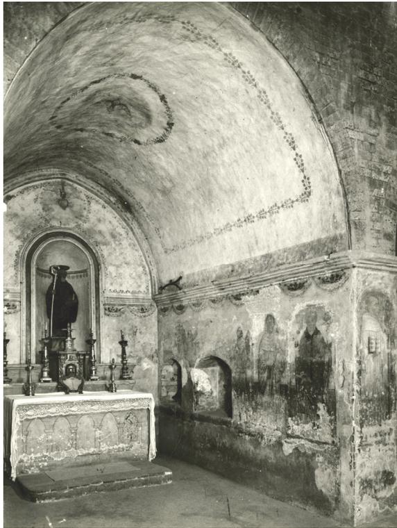
Fig. 3.9 Stato di degrado delle superfici affrescate (in Archivio Fotografico SABAP-TO, AL\_Tortona\_3885/3886, ottobre 1942)
