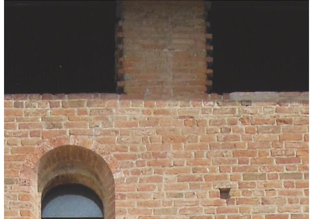
Fig. 7.18 Prospetto meridionale. Pilastrino di rialzo della copertura
