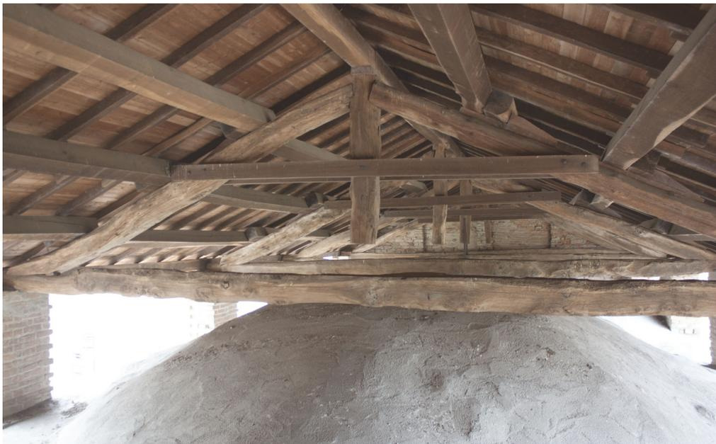
Fig. 3.14 Sottotetto navata centrale, realizzazione del massetto in CLS sull'estradosso delle volte
