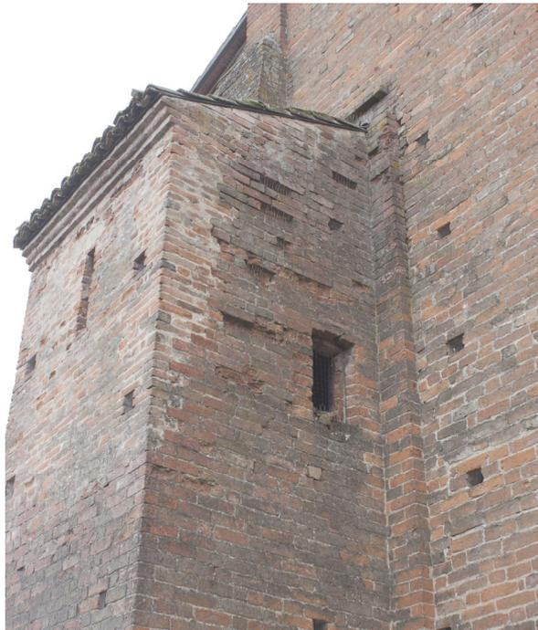
Fig. 7.23 Torre scalare. Ammorsamento tra le murature PNc012 e PNc014
