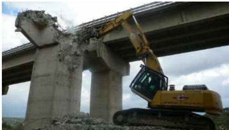
Figura 1 Demolizione top down
