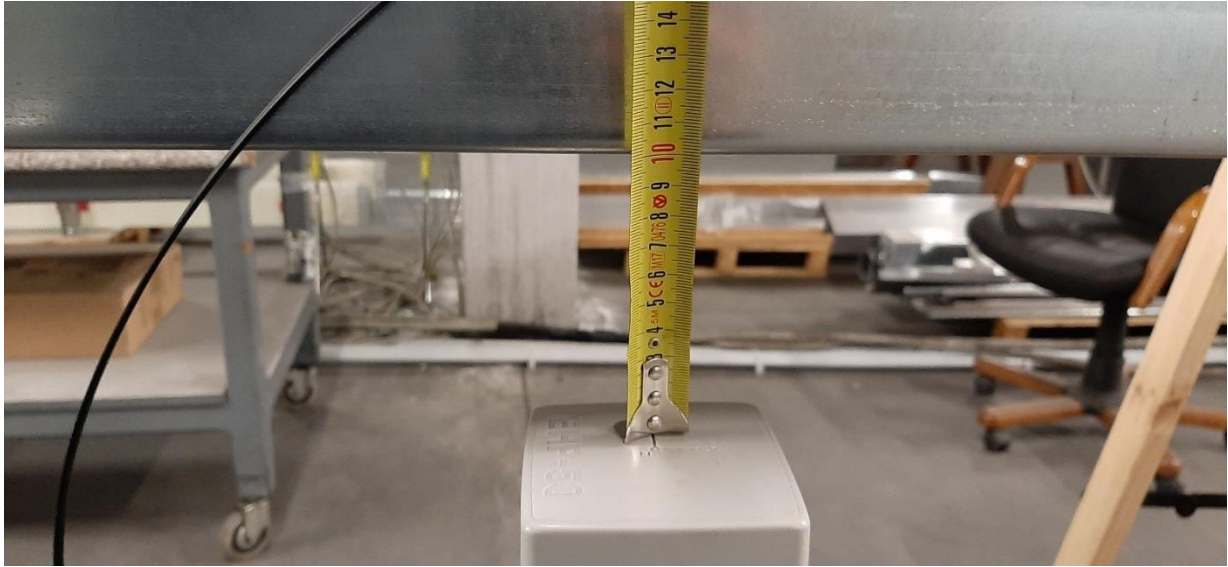
Figura 12 Dettaglio sul posizionamento della sonda per misurazione sul fondo del canale
