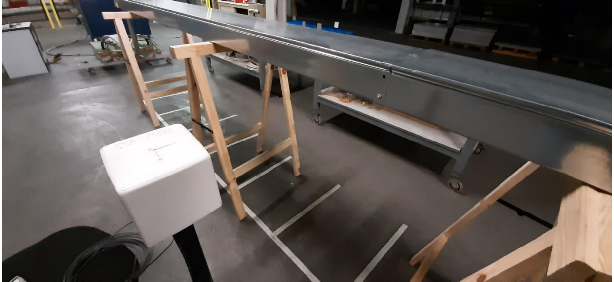
Figura 10 Posizionamento della sonda in corrispondenza del canale a 0.5 m dalla superficie. Particolare in riferimento alla sezione di giunto.
