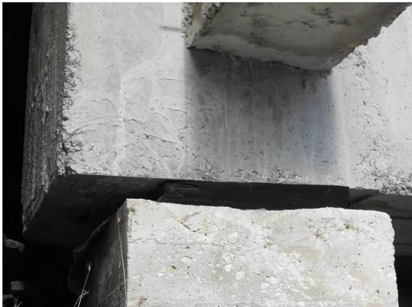
Figura 2.10: Particolare dei dispositivi di appoggio
