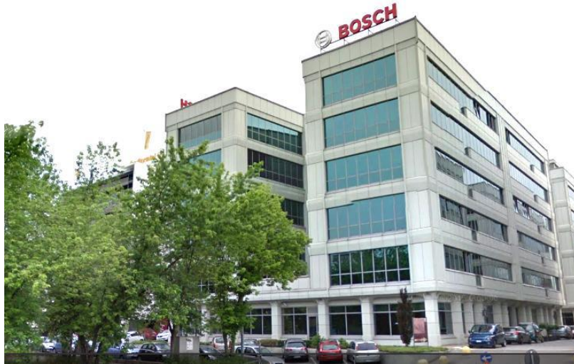
Figura 5 - Edificio Bosch Group a Torino
