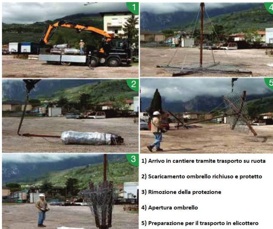
**Figura 4** Operazioni di apertura ombrello all'arrivo in cantiere (Foto da: IncofilTech)
