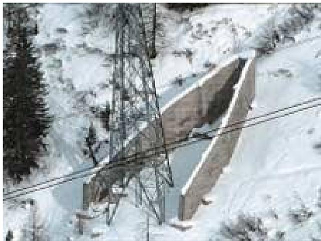
**Figura 4** Un cuneo di ripartizione a protezione di un traliccio dell'alta tensione (Foto da: [www.mairwilfried.it](http://www.mairwilfried.it))
