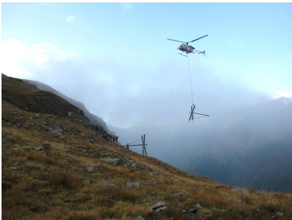
**Figura 5** Posizionamento di ombrelli in sito nel comune di Valsavarenche con l'ausilio di elicottero (foto di V. Segor)
