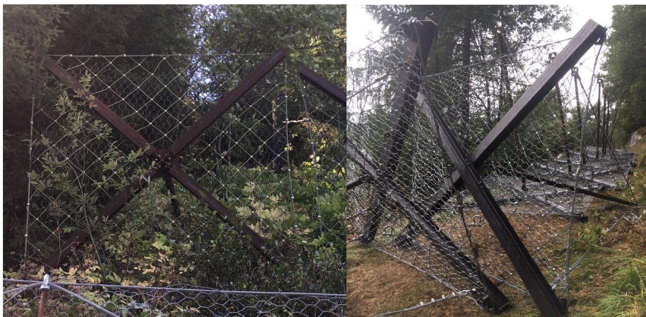
**Figura 8** Differenti tipologie di realizzazione della croce di Sant'Andrea. A sinistra 4 travi distinte unite al centro, nei pressi di Rhêmes-Saint-Georges (AO), a destra due travi sovrapposte nei pressi di Chiomonte (TO) (foto di M. Da Dalt)
