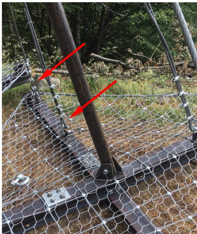
**Figura 9** Particolare del braccio di un ombrello con doppi tiranti che sarà posto a fine linea, presso Chiomonte (TO)
