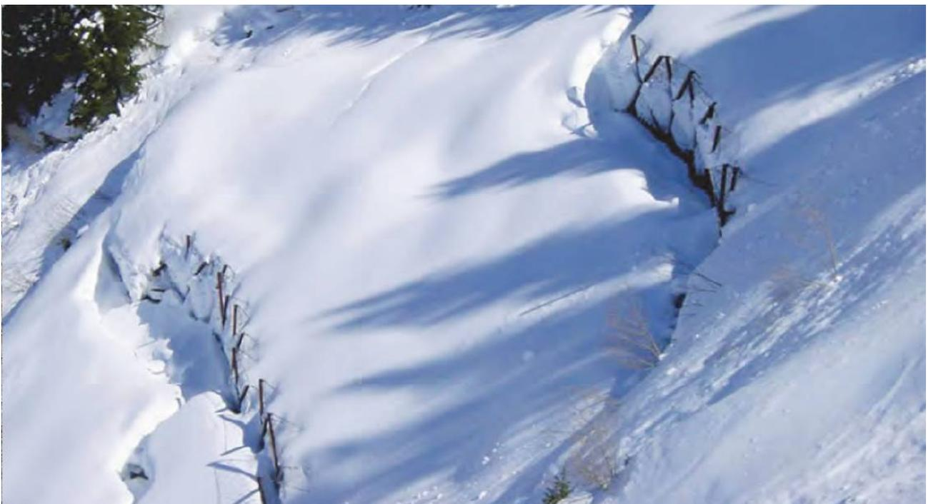
Figura 3 Ombrelli installati lungo un versante nella stagione invernale (Immagine da: Barbero et al, 2014)
