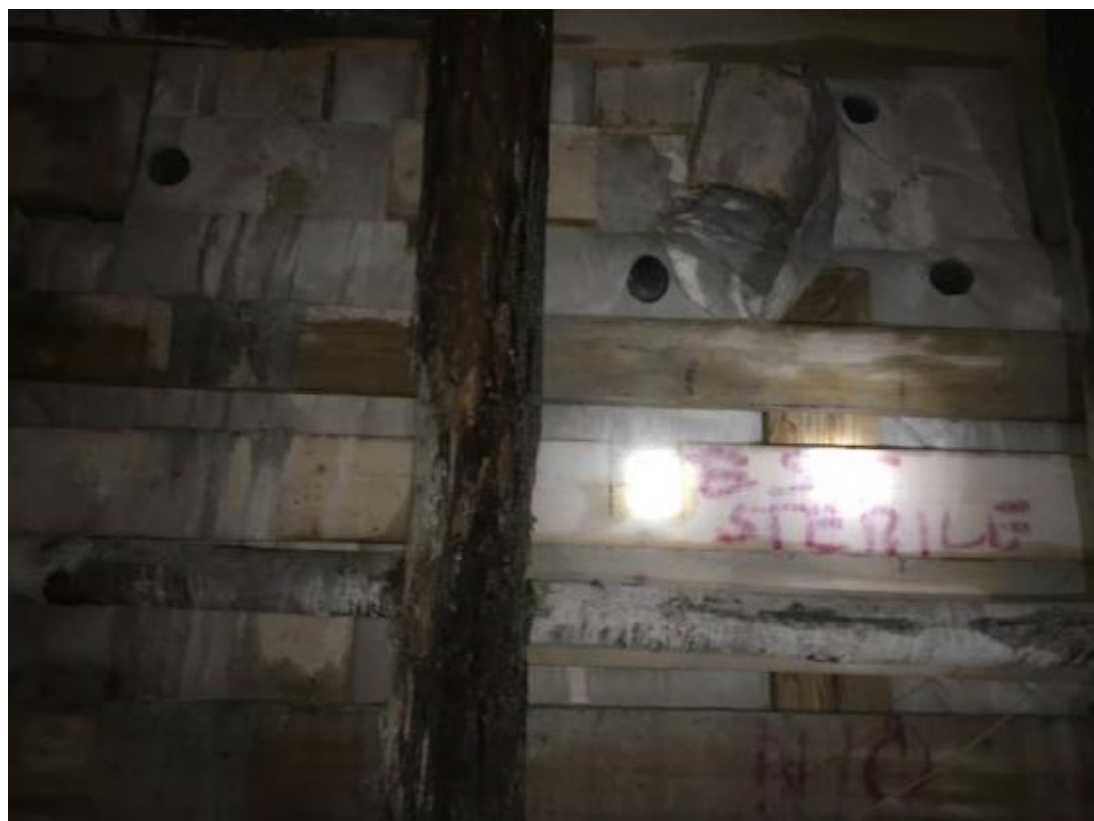
Figura 3.8: foto della trancia ripienata al termine delle operazioni di carotaggio
