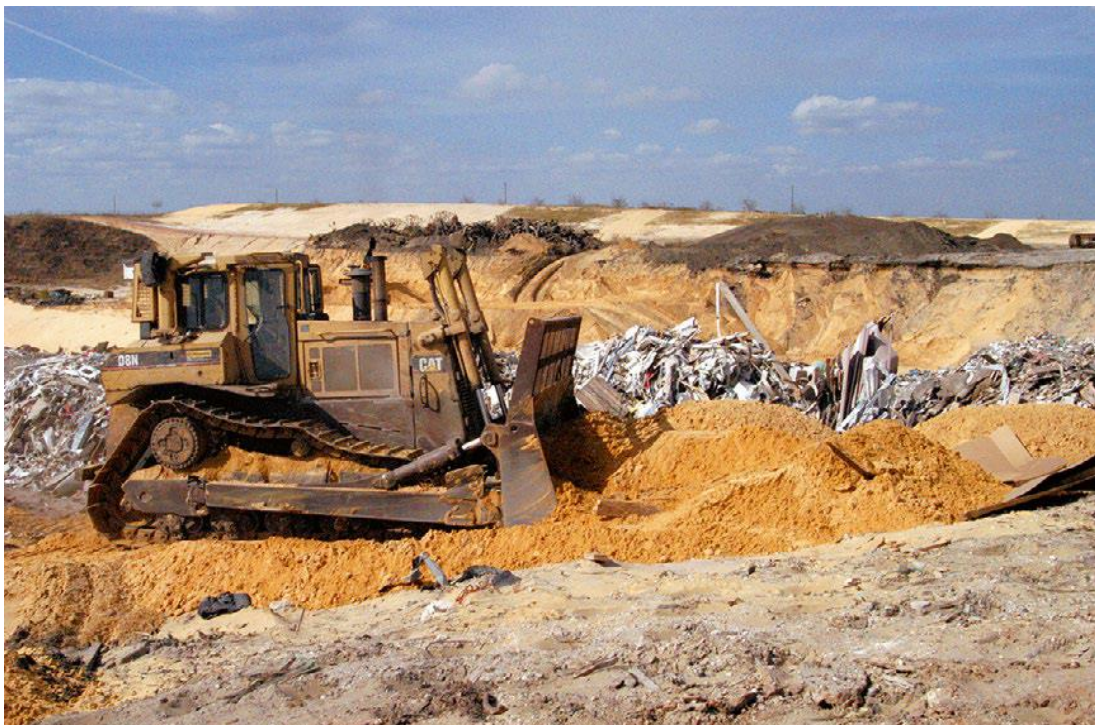
Figura 1.5: applicazione del suolo di copertura, riduzione di odori, incendi, inquinamento e protezione da acque di pioggia e percolato, immagine tratta da “Sustainable Practices for Landfill Design and Operation”
