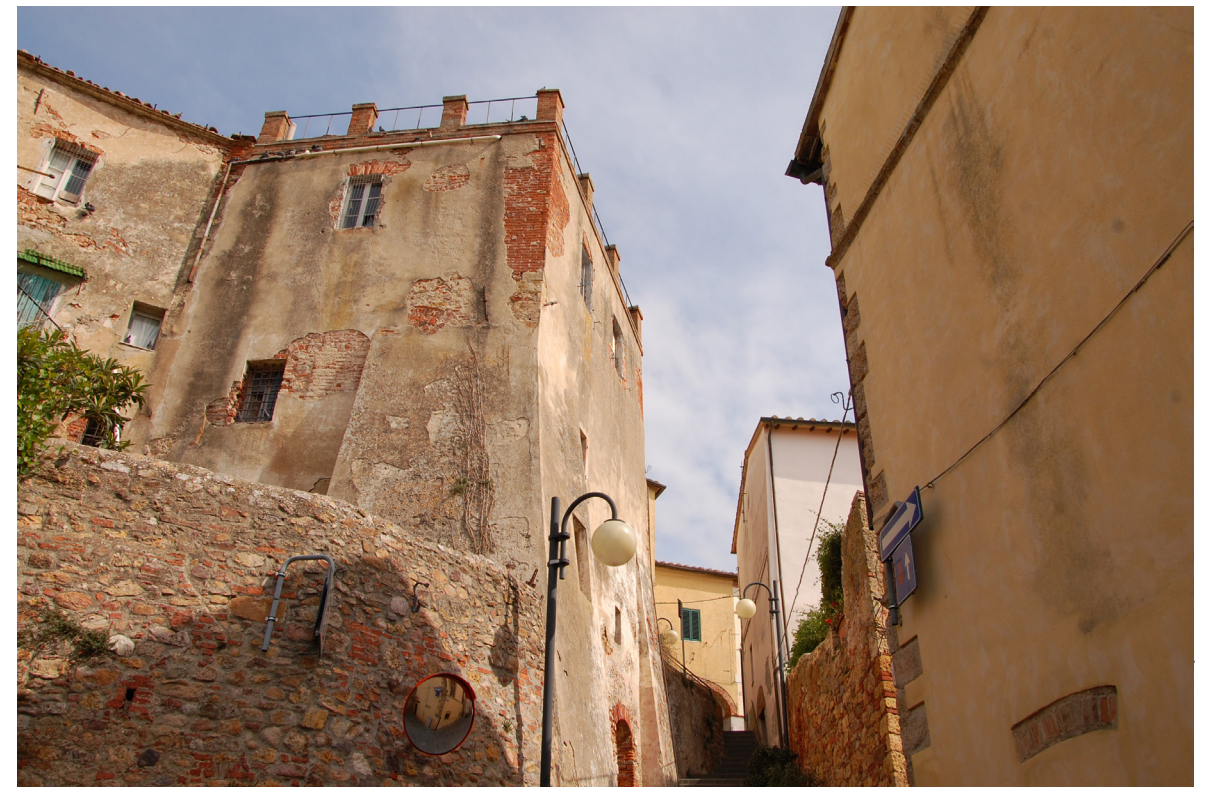
Figura 22. Veduta interna del borgo
