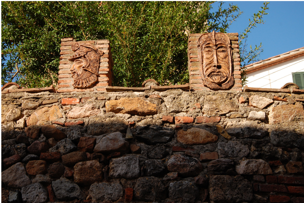
Figura 32. Merlatura e maschere aggiunte sulla muratura medievale
