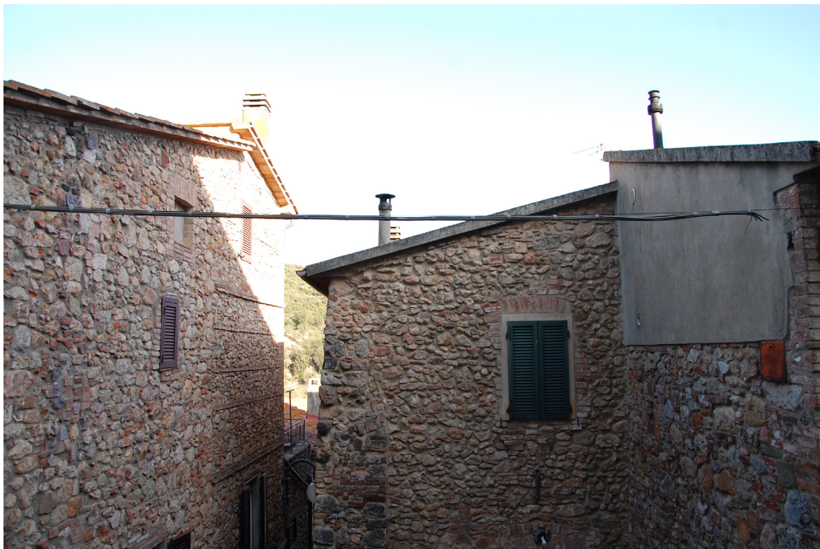
Figura 37. Veduta interna del borgo
