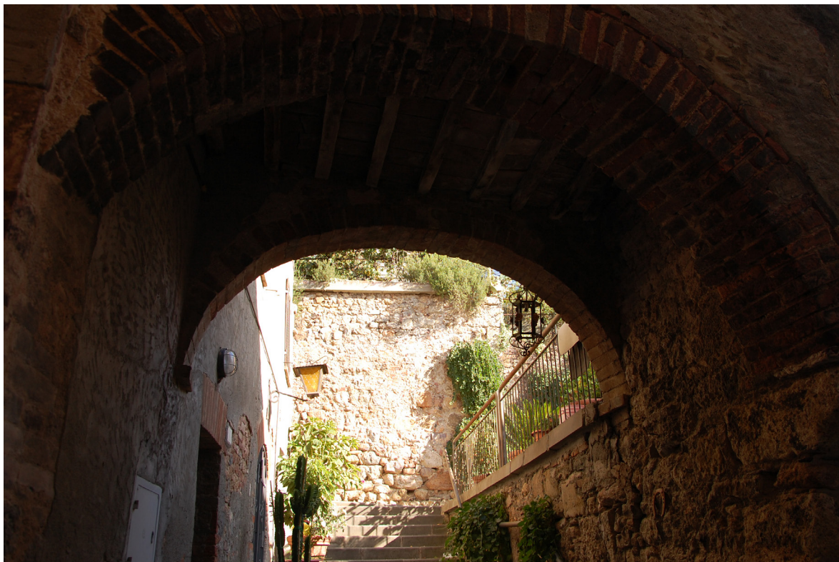
Figura 33. Scorcio di una copertura con archi del vicolo
