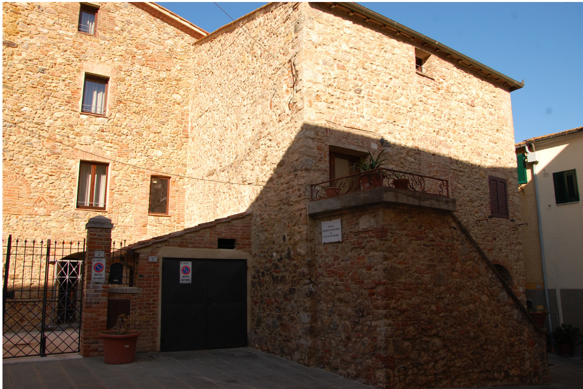
Figura 36. Veduta interna del borgo
