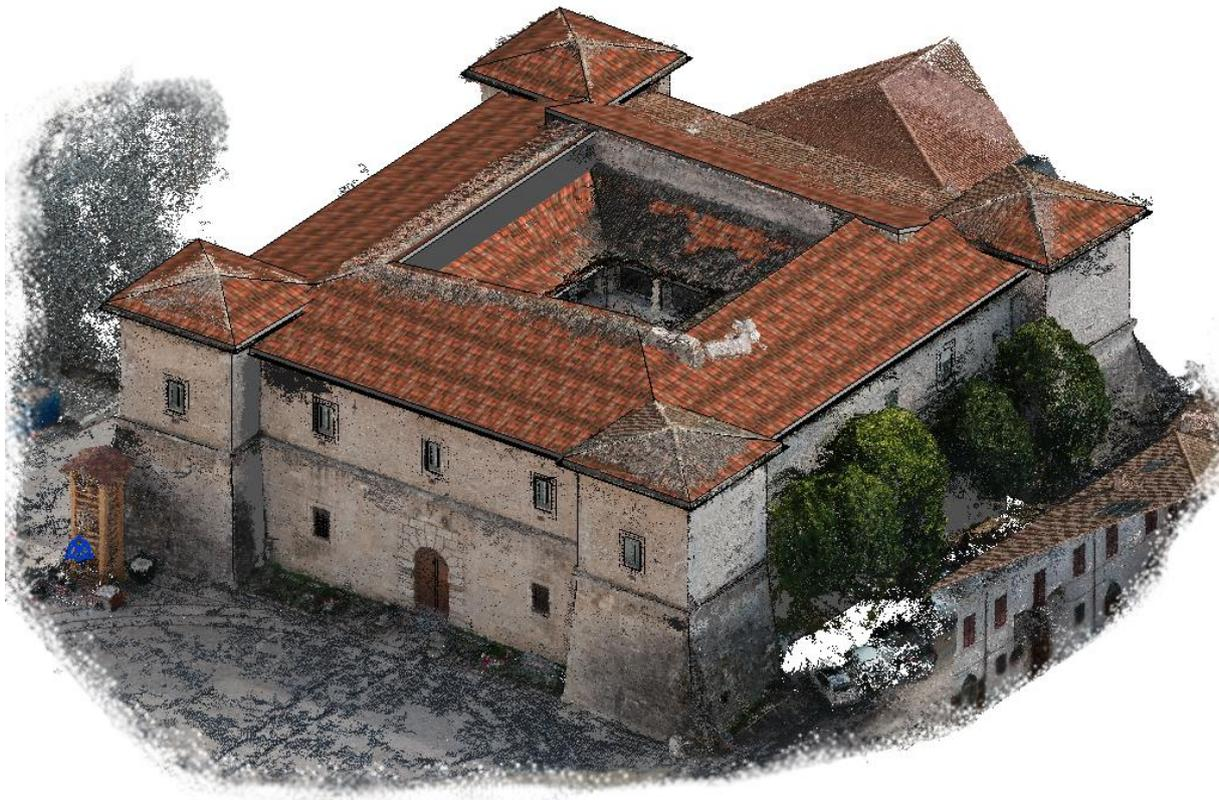
**Figura 127:** Vista assonometrica della fortezza della Castellina e sovrapposizione del modello BIM con la nuvola di punti.
