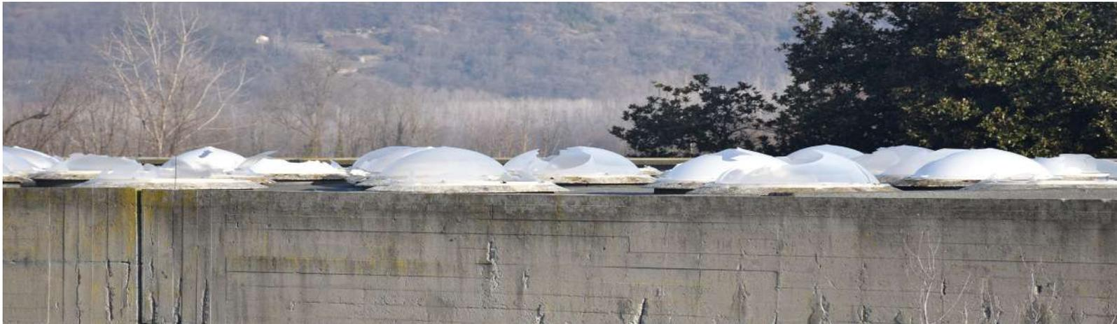
Fig.11 Ciò che rimane delle cupole emisferiche in perspex
