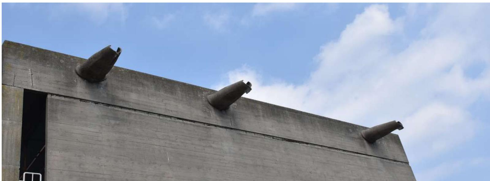
Fig.1 Macchie di umidità e patine biologiche depositatosi sui cornicioni del manufatto
