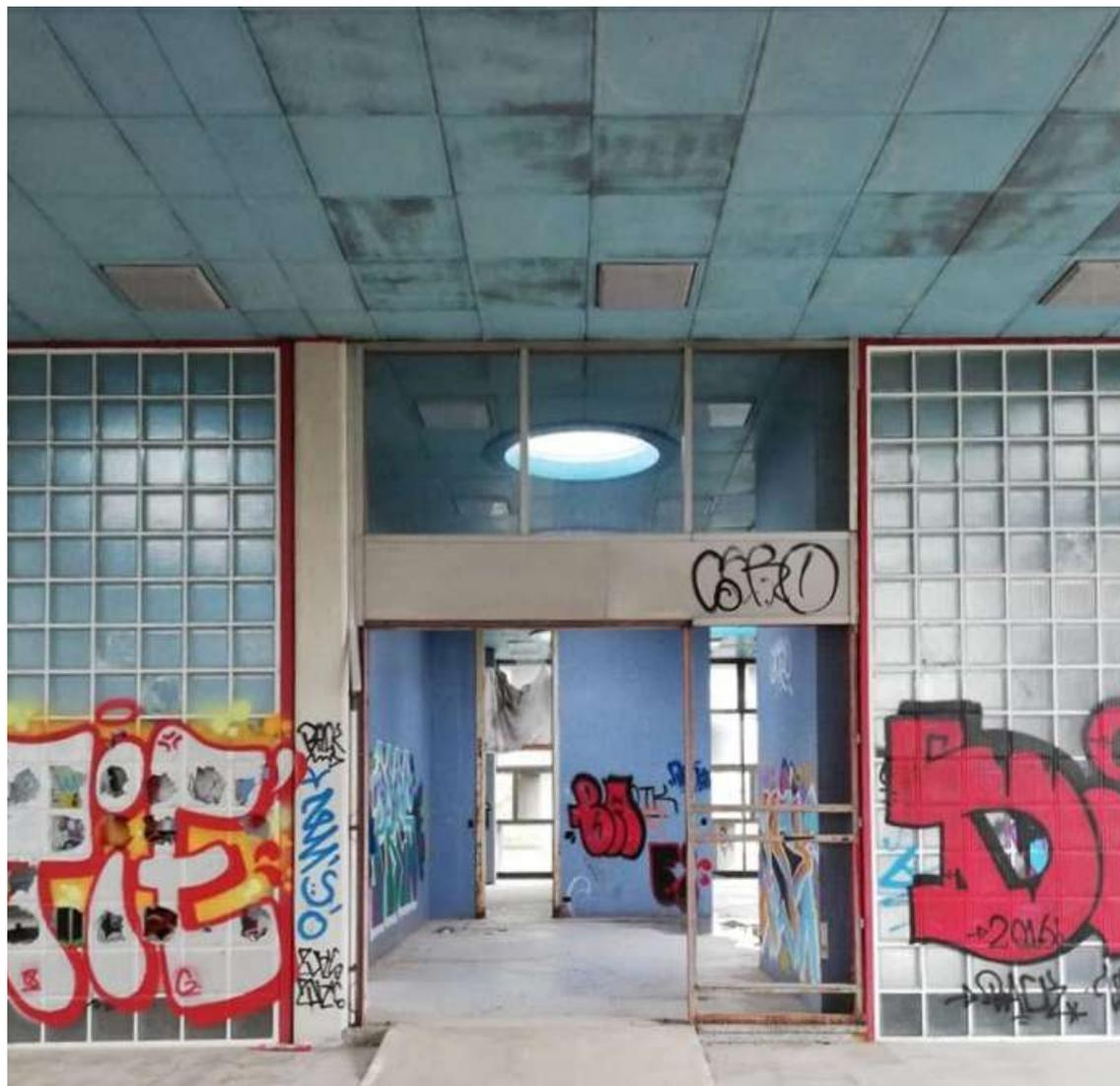
Fig.19 Particolare delle mattonelle in vetrocemento
