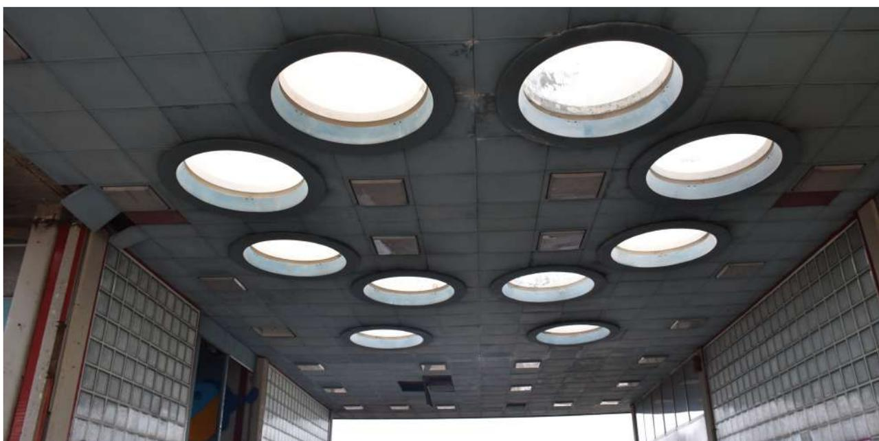
Fig.14-15 I lucernari visti dall'esterno e dall'interno dell'edificio, le cupole in perspex sono oggi fortemente degradate
