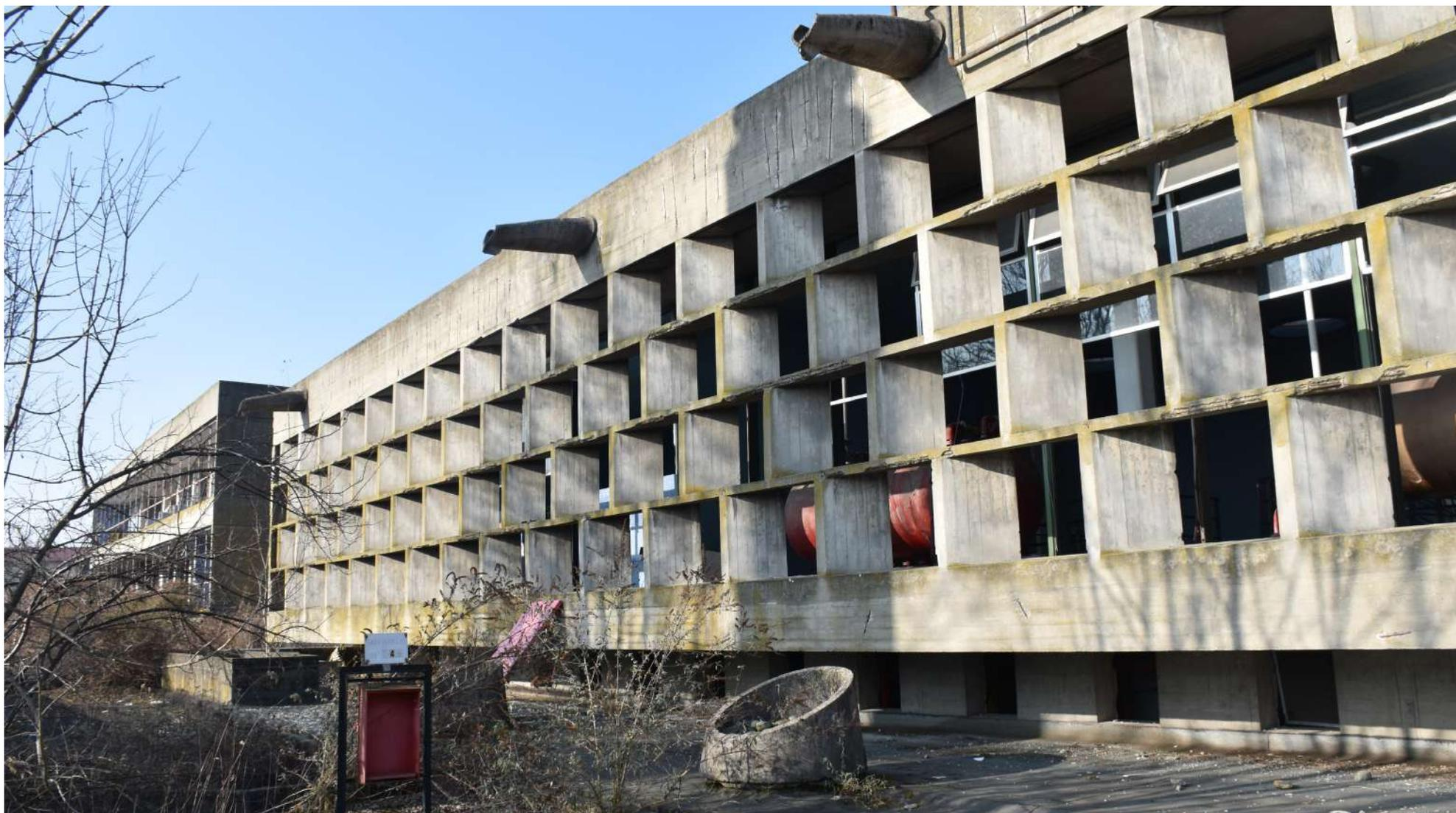
Fig.20 Particolare di una delle facciate dell'edificio in cui sono collocati i doccioni di scolo dell'acqua e le rispettive vasche di raccolta
