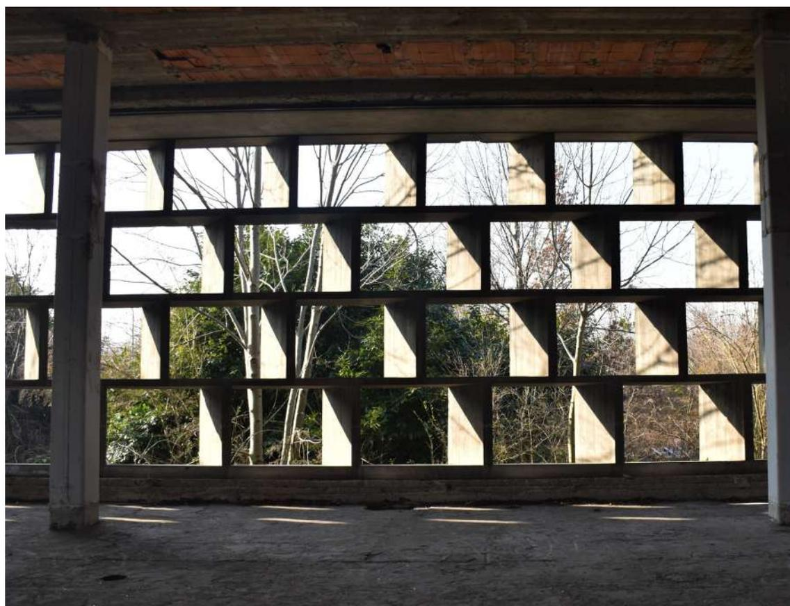
Fig. 16 Particolare del frangisole in cemento armato della facciata
