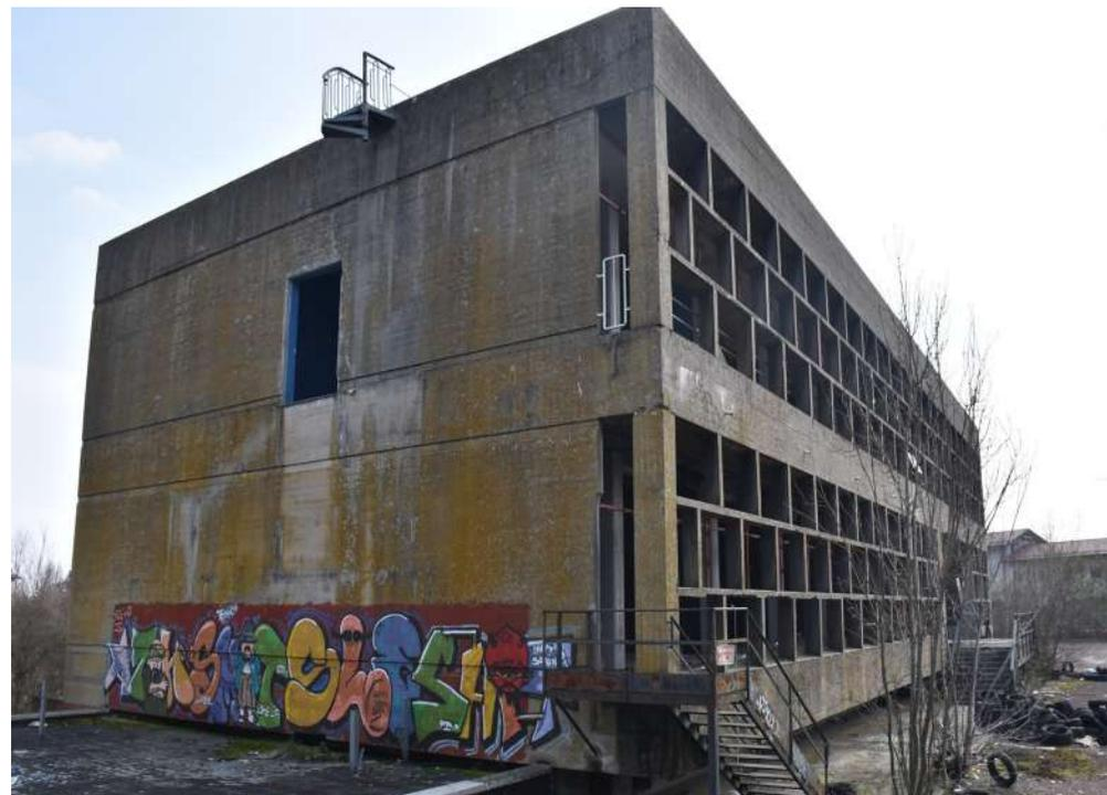
te quelli di tipo superficiale, sono abbondanti, soprattutto sulle facciate cieche, e di frequente si riscontrano distacchi più profondi tali da mostrare parti dei ferri delle armature. In particolare il distacco del materiale è molto accentuato sui frangisole e sui cornicioni. Nella porzione di edificio che racchiude la centrale termica, i frangisole risultano essere particolarmente degradati e paiono sgretolarsi. Ciò è dimostrato dalla presenza di calcestruzzo sul terreno e dalla presen-
