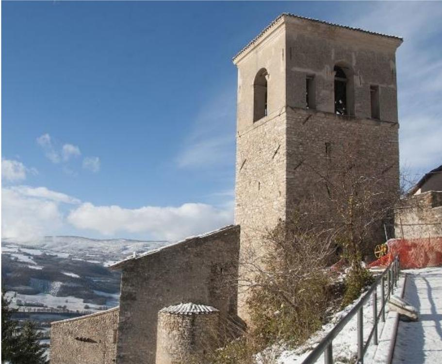
**Figura 3.10** Interventi di restauro. Fessurazioni stuccate in seguito al sisma del 1979, legate al meccanismo di danno della cella campanaria (fotografia reperibile attraverso il motore di ricerca [www.google.it/maps](http://www.google.it/maps))
