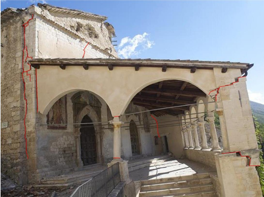
**Figura 5.4** Stato del danno dopo le scosse del 26 ottobre 2016. Principio di ribaltamento della facciata. Mappatura delle fessurazioni. (immagine reperita dal sito [www.lavoce.it](http://www.lavoce.it))
