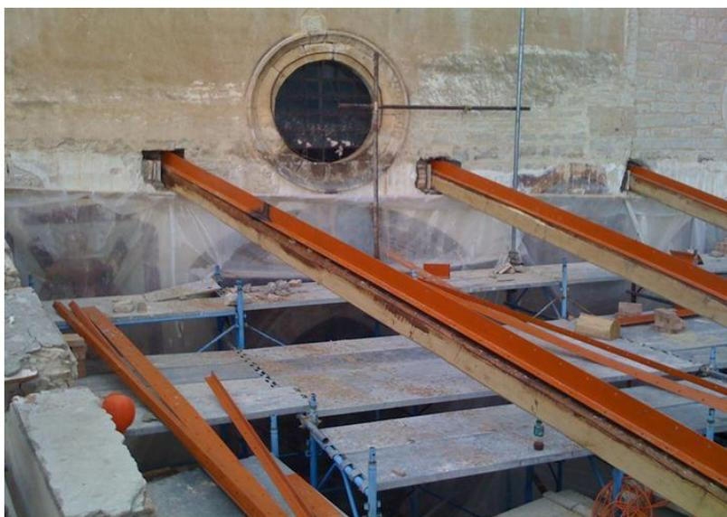
**Figura 3.8** Ancoraggio del portico alla facciata tramite travi metalliche nel 2009 (immagine reperita dal sito [www.antenucciugosrl.it](http://www.antenucciugosrl.it)).
