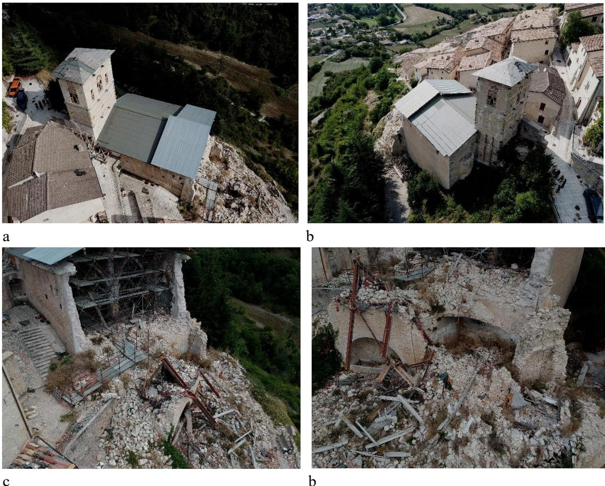
**Figura 5.1** La chiesa di Sant'Andrea dopo le scosse sismiche del 2016. (fotografie scattate da drone durante il rilievo fotogrammetrico).
