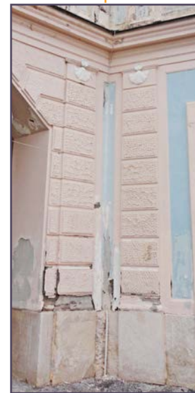
tav.25. Rilievo Termografico - PROSPETTO SUD-EST. SCHEDA 2
