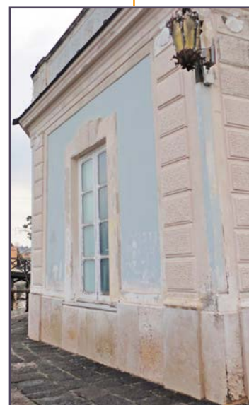
tav.28. Rilievo Termografico - PROSPETTO NORD-EST. SCHEDA 8
