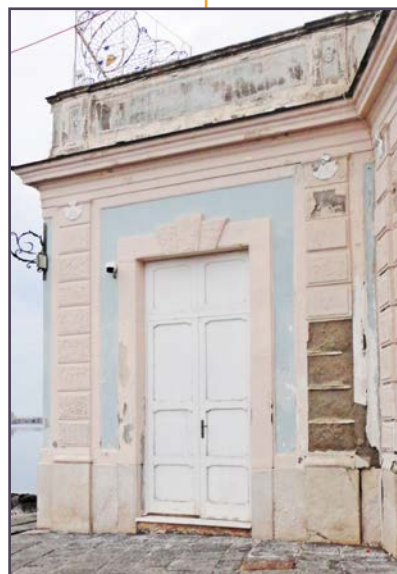
tav.25. Rilievo Termografico - PROSPETTO SUD-EST. SCHEDA 1
