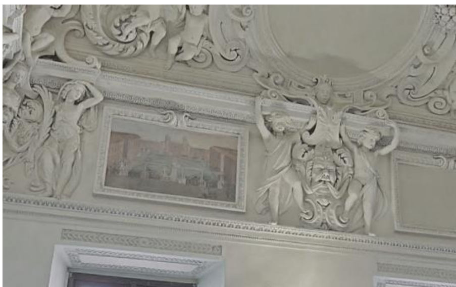
Figura 39– Riquadro affrescato sul fregio Immagine ricavata dal servizio di Google Maps Street View, posto all'interno del sito https://castellodelvalentino.polito.it/
