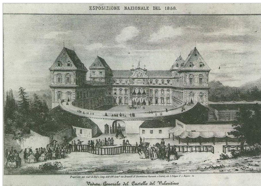
Figura 7 – Veduta generale del Castello del Valentino. Per l'esposizione del 1858 sono abbattute le maniche castellamontiane e realizzate le grandi gallerie espositive di collegamento fra torri e padiglioni su progetto di Luigi Tonta e Domenico Ferri.
