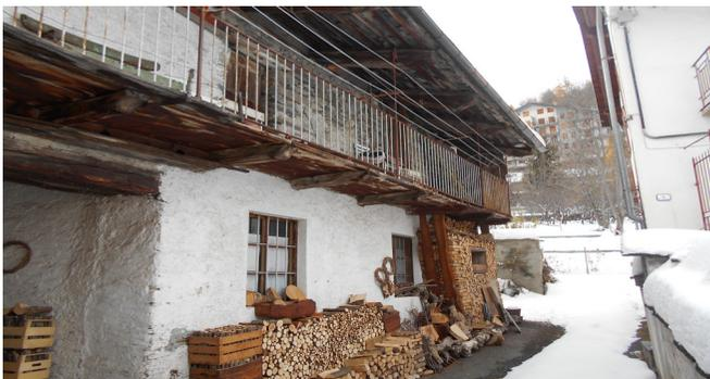
Lateralmente l'edificio ripete l'orizzontamento del balcone in legno lungo l'intera facciata. Si vede anche una trave in legno che sostiene il piano del balcone in facciata. Inoltre, la trave si incastra nella colonna portante lo sporto del tetto, soluzione, anche questa, già descritta come usuale nell'architettura montana.
