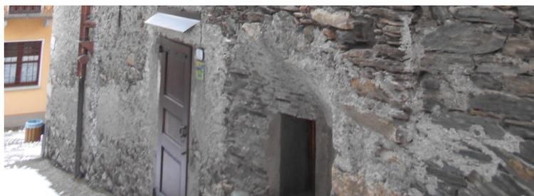
Alcuni interventi hanno chiuso delle aperture lungo la strada. In foto, l'arco rimane segnalato dal posizionamento per coltello dei mattoni in pietra. Al di sopra dell'arco tamponato si vede una finestra. Probabilmente originaria dell'edificio, l'apertura si presenta piccola con sguinci. In elevato essa non è l'unica presente, anche se prevalgono i recenti interventi di ammodernamento dell'edificio. Un esempio è l'ingresso che presenta un tettuccio in lamiera.
