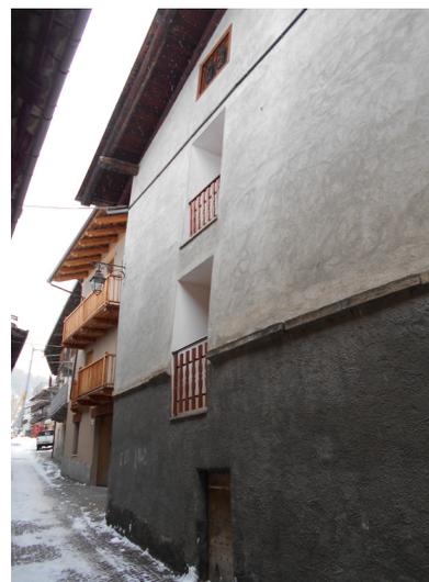
Proseguendo lungo via Pontechianale gli edifici sono ancora cinquecenteschi, nell'intorno della piazzetta, in particolare, riportiamo un intervento per lo scarico dell'acqua piovana che viene realizzato direttamente all'interno della muratura e successivamente tamponato con malta.
