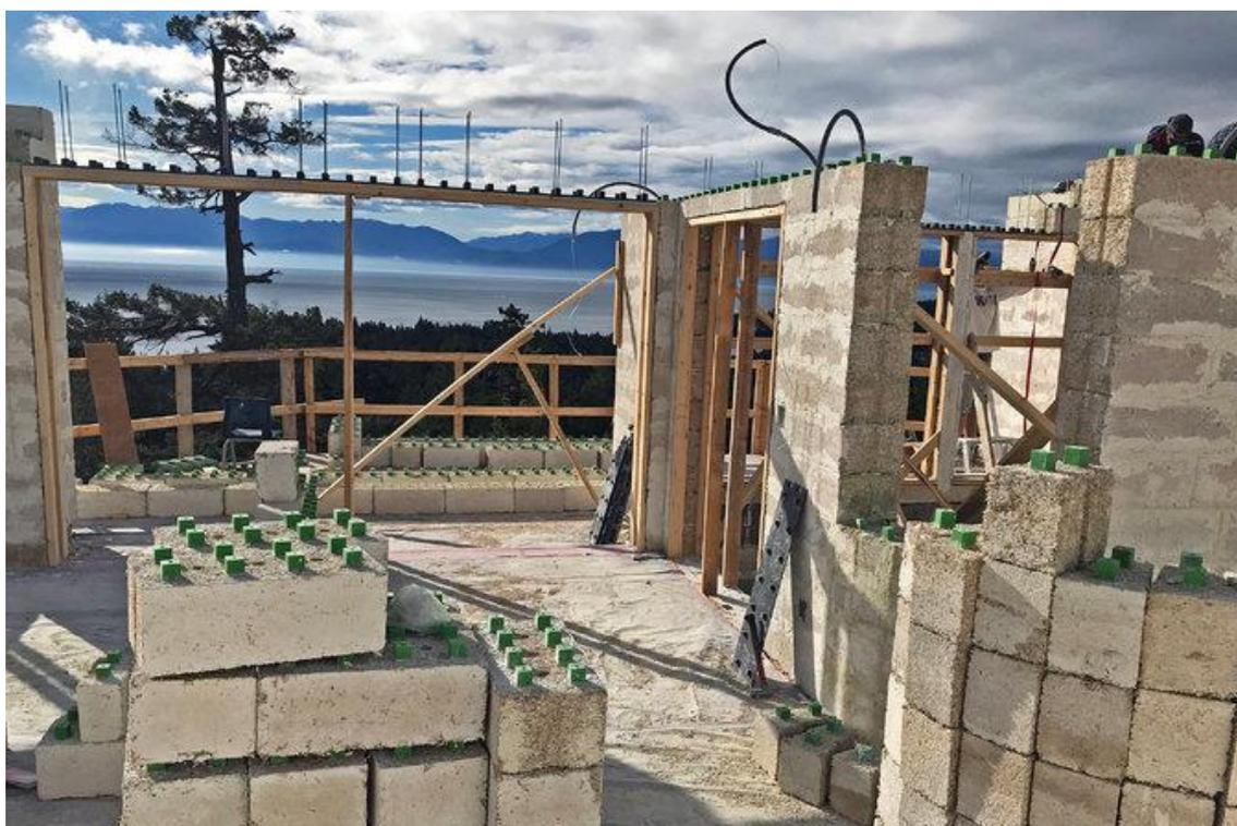
**Figura 11:** SSR block® in una costruzione della Columbia Britannica (Canada)
