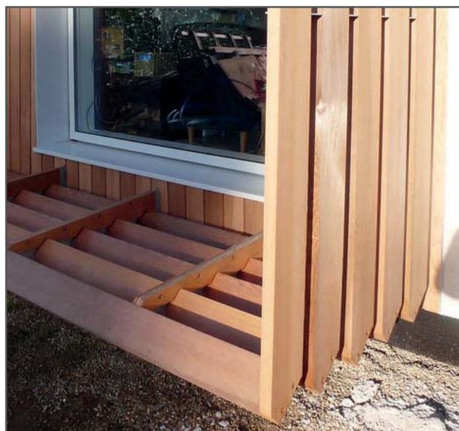
[Fig. III.36] Particolare della schermatura.
