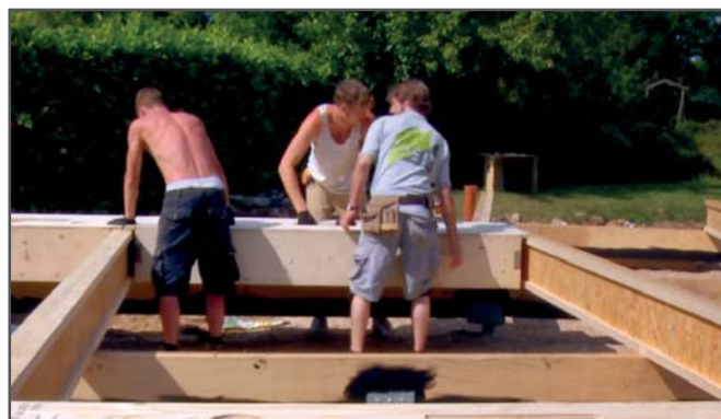
[Fig. III.34] Inserimento travi i-Joist e blocchi di isolamento nel solaio del piano terra.
