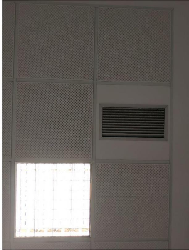
*Fig. 33 Foto interno aula 7I, dettaglio corpo illuminante e griglia in alluminio per ventilazione meccanica.*
