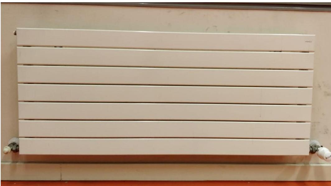
*Fig. 28 Foto interno aula 201, dettaglio terminale di emissione: radiatore in alluminio.*
