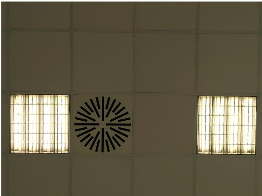
*Fig. 8 Foto interno aula 4V, dettaglio corpi illuminanti.*
