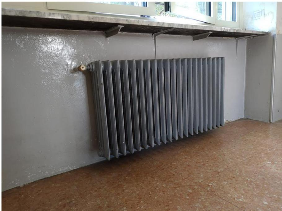
*Fig. 20 Foto interno aula 25, dettaglio terminale di emissione: radiatore in ghisa.*
