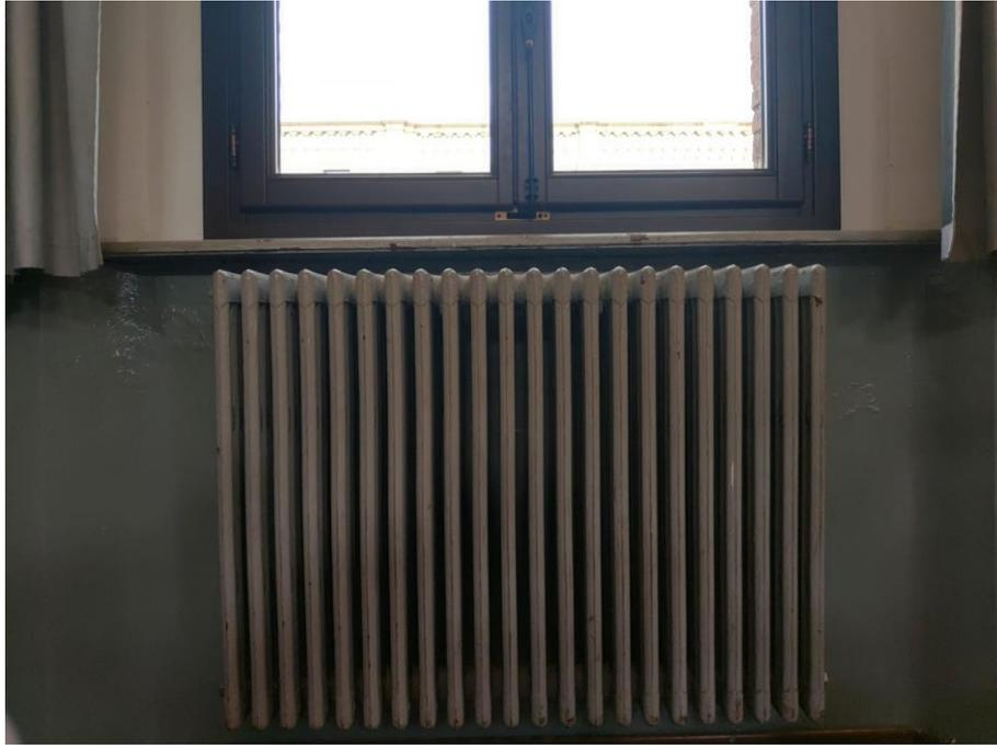
*Fig. 9 Foto interno aula 4V, dettaglio terminale di emissione: radiatore in ghisa.*
