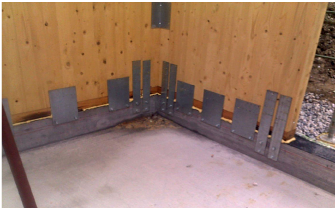
Foto 3- staffe di collegamento struttura/ fonte: tecnoring.com
