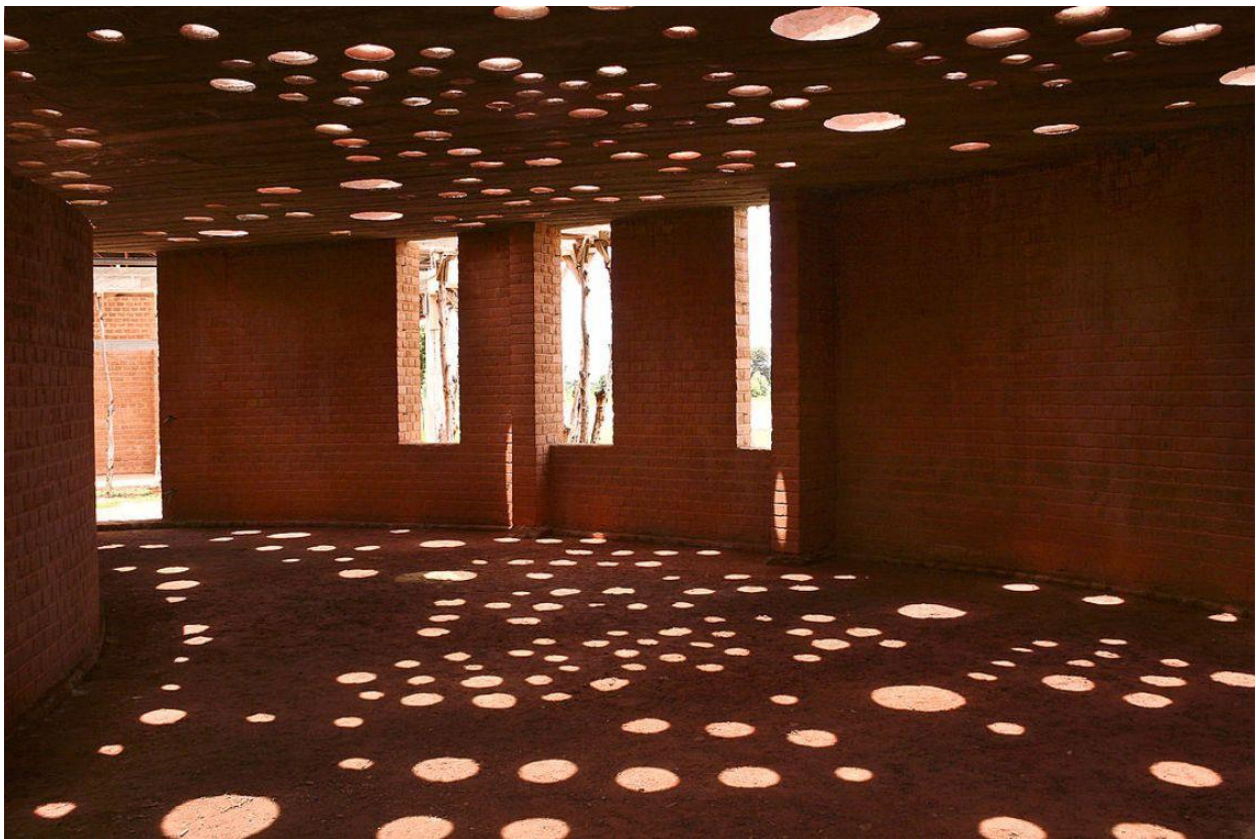
Foto 4 – Biblioteca di Gando in Mali di Kerè Architects Fonte: LIFEGATE
