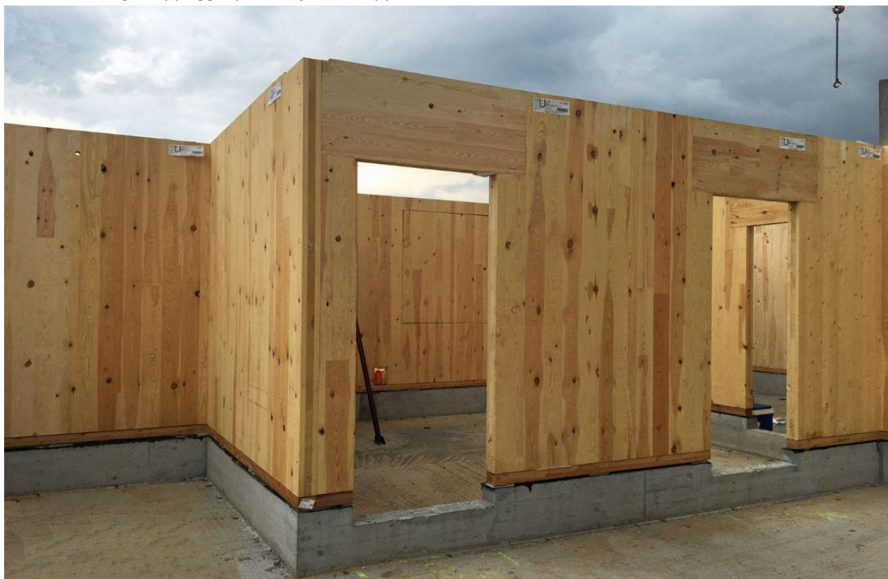
Foto 5 – dettaglio appoggio parete/ fonte: zoppelleto.net
