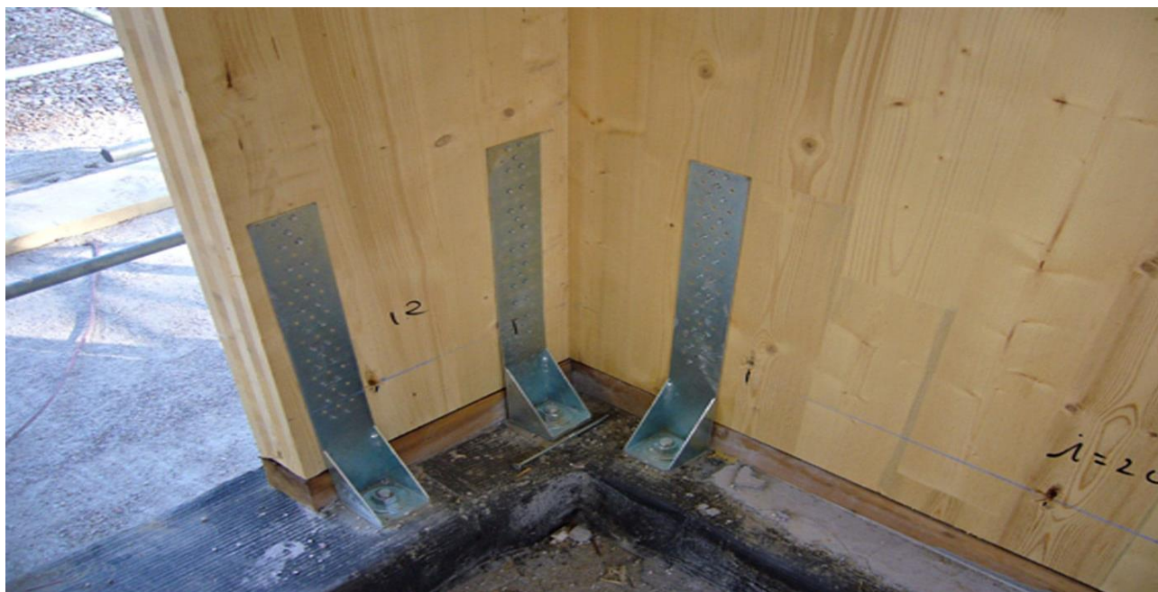
Foto 1 – staffe d'ancoraggio / fonte: tecnoring.com
