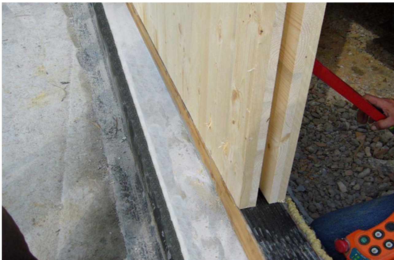
Foto 5 – dettaglio appoggio parete/ fonte: zoppelleto.net
