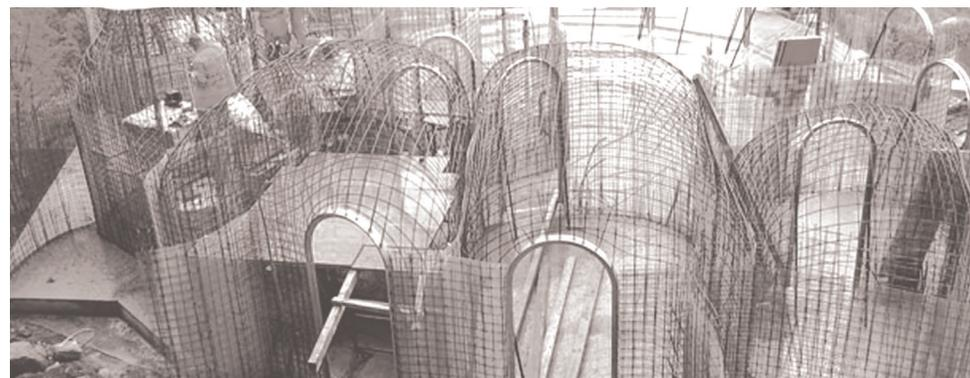
**immagine 6-** Posizionamento delle reti metalliche elettrosaldate durante la costruzione di un'abitazione ipogea realizzata con la tecnica del calcestruzzo a proiezione.
