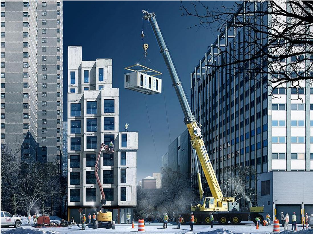
Immagine 42: montaggio della struttura modulare in sito.
