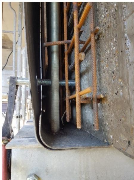
Figura 211: Dettaglio 2 rinforzo sella Gerber
