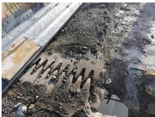
Figura 30: Dettaglio giunto
