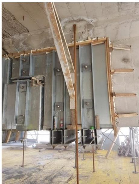
Figura 200: Dettaglio 1 rinforzo sella Gerber
