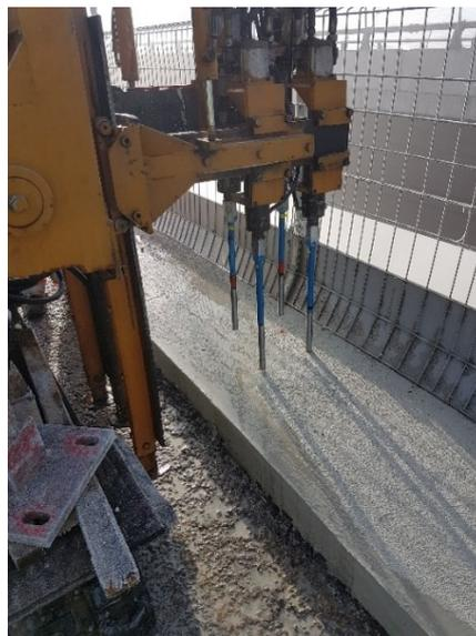
Figura 26: Dettaglio operazione realizzazione nuovo cordolo
