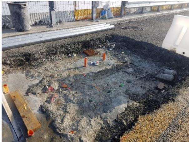
*Figura 38: Dettaglio adeguamento calcestruzzo di impalcato*
