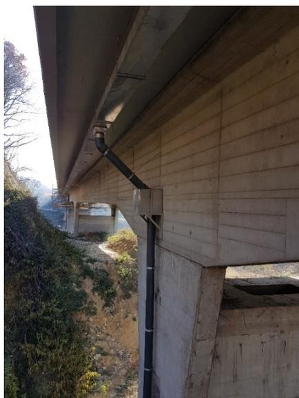
*Figura 31: Dettaglio sistema regimentazione acque 25*
