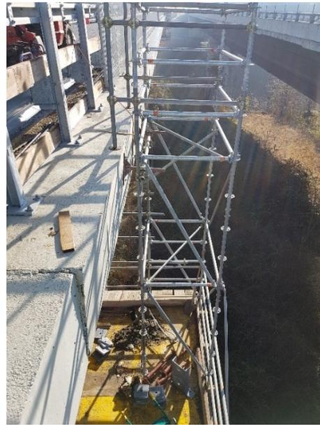
Figura 36: Dettaglio impalcatura realizzazione nuovo cordolo
