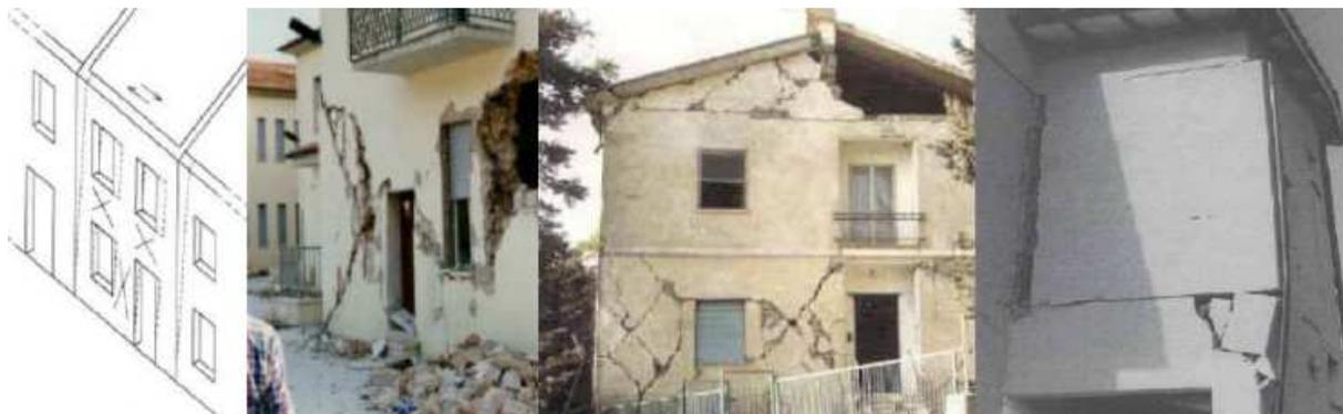
Figura 5.8: Casi reali di meccanismi di secondo modo
