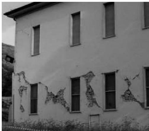
Figura 6: esempio di rottura per fessurazione diagonale [10]
