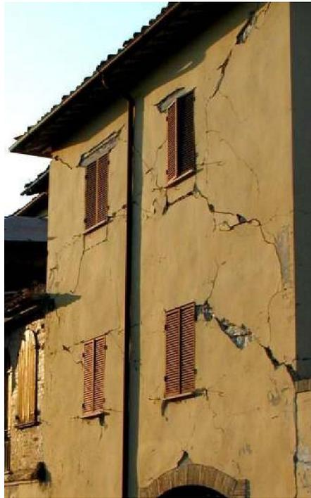
*Figura 8: esempio di rottura flessionale a seguito di un evento sismico [10]*
