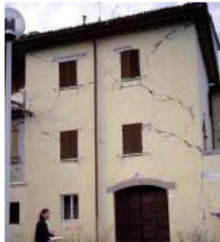
*Figura 1: (sinistra) esempio collasso fuori dal piano di una parete [10]; (destra) esempio di rottura nel piano della parete [10]*
