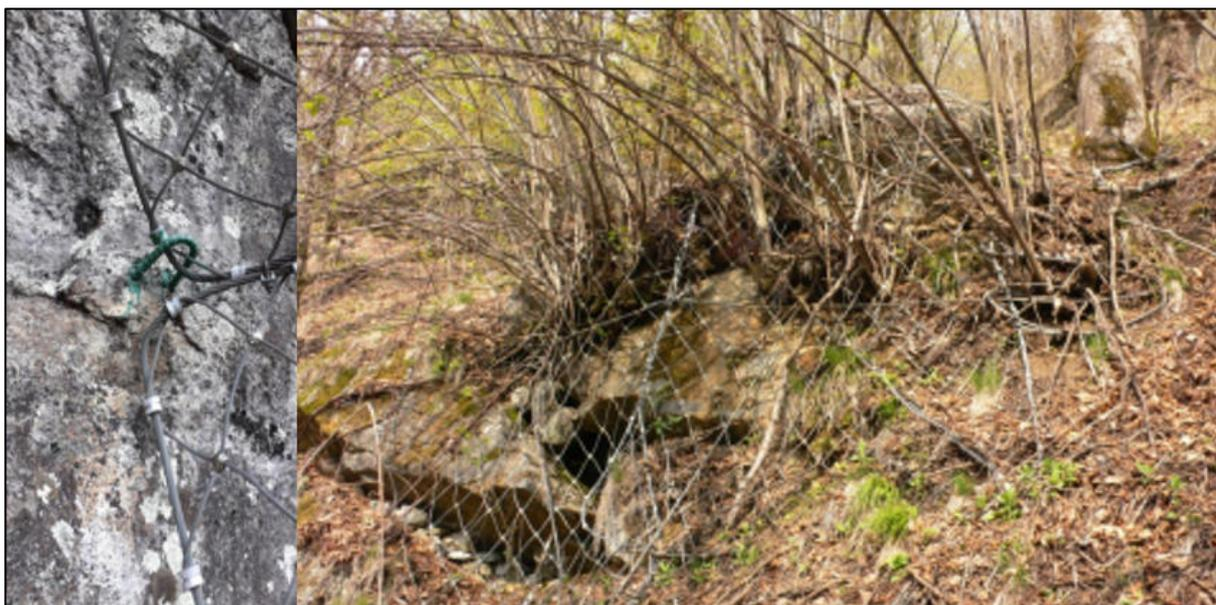
*Figura 6.0: Esempi di immorsamento non stabilizzante (sinistra) e fitta vegetazione invasiva nei pannelli (destra) (Tecnosesia, 2019)*
