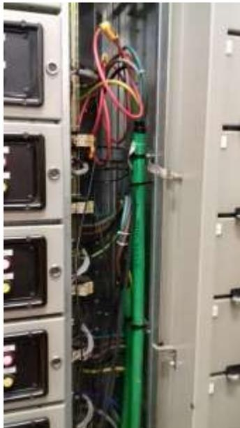
Figura 110 Sonde di corrente elettrica di tipo Rogowski
