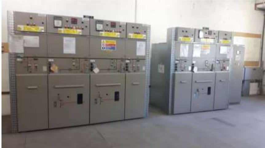
Figura 18 Quadri di media tensione della cabina PEF (QMT1 e QMT2)
