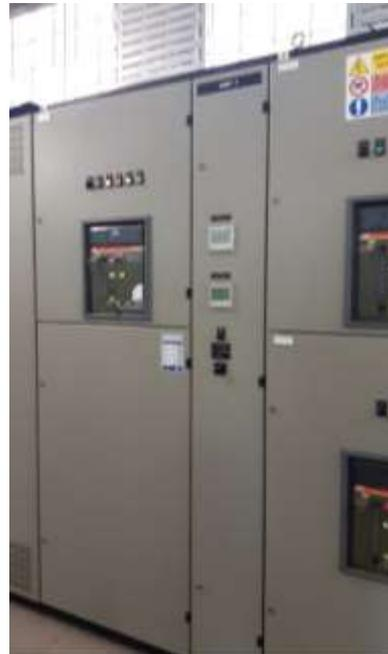
Figura 19 Quadri generali di bassa tensione della cabina PEF (QGBT1 e QGBT2)
