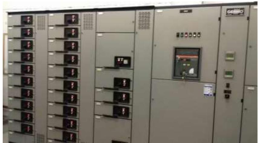
Figura 104 Quadro di media e di bassa tensione cabina PEF stazione metropolitana Porta Nuova
