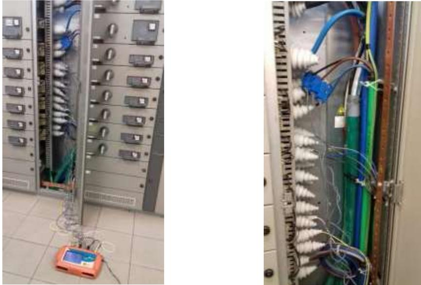
**Figura 115** Analizzatore di qualità di potenza Dranetz PowerGuide® 4400 e pinze amperometriche Dranetz TR-2550A Ac Clamp-On Probe
